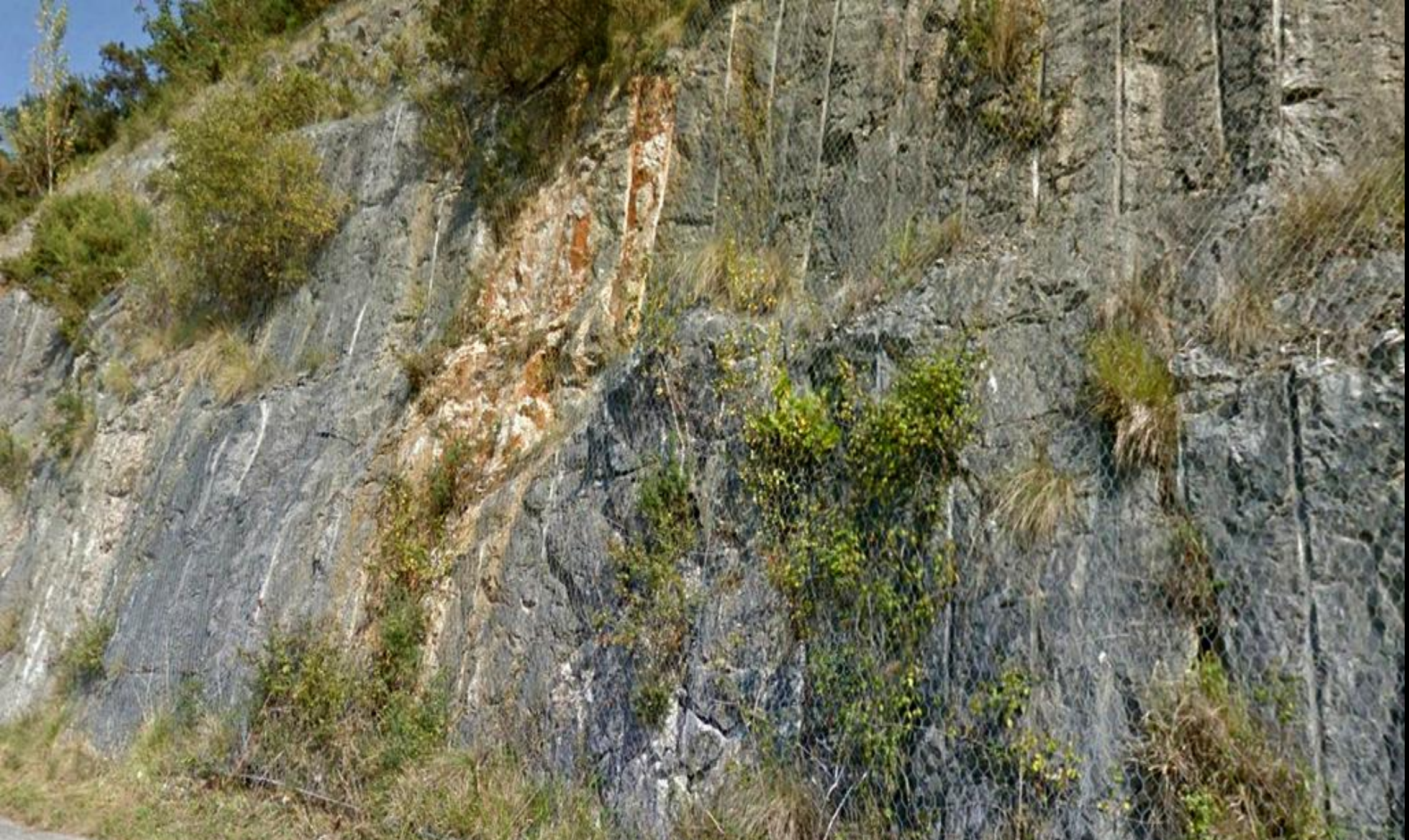
Mallazo en el talud de calizas con fallas , del Carbonífero Sup. Estribo Este del Embalse de Palombera, Río Nansa, en Herrerías, Cantabria. NW Hoja de Cabezón de La Sal.
