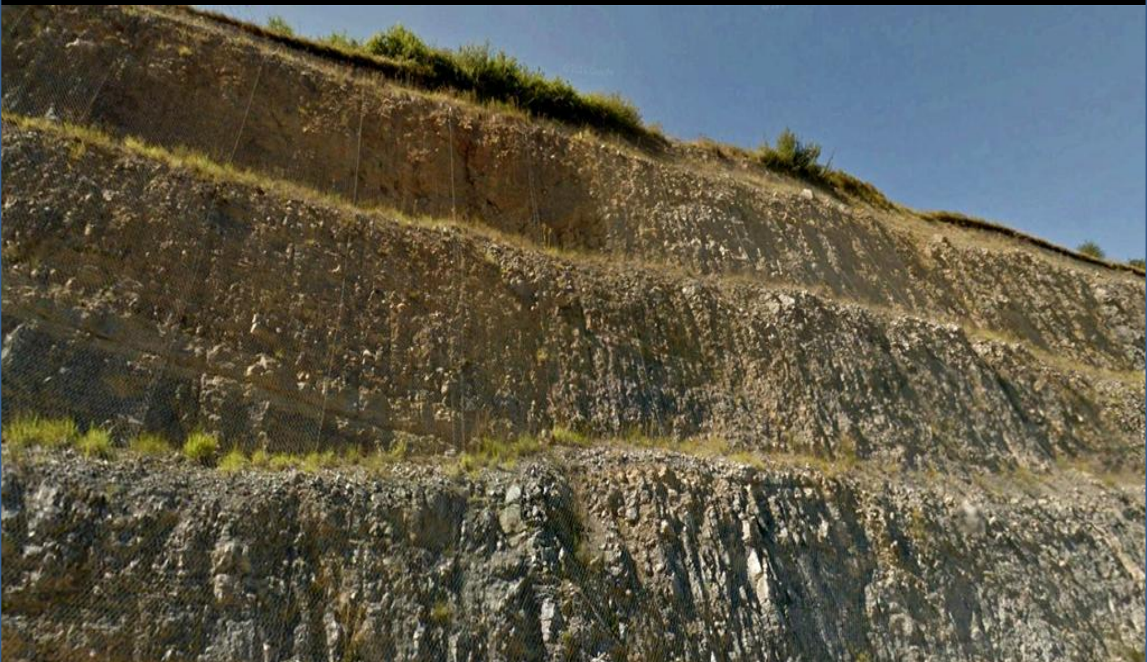
Mallazo en el talud de alternancia de margas y calizas arcillosas del Liasico, Jurásico Inf. Cerca del Túnel de Somaconcha, Cantabria. W Hoja de Reinosa,
