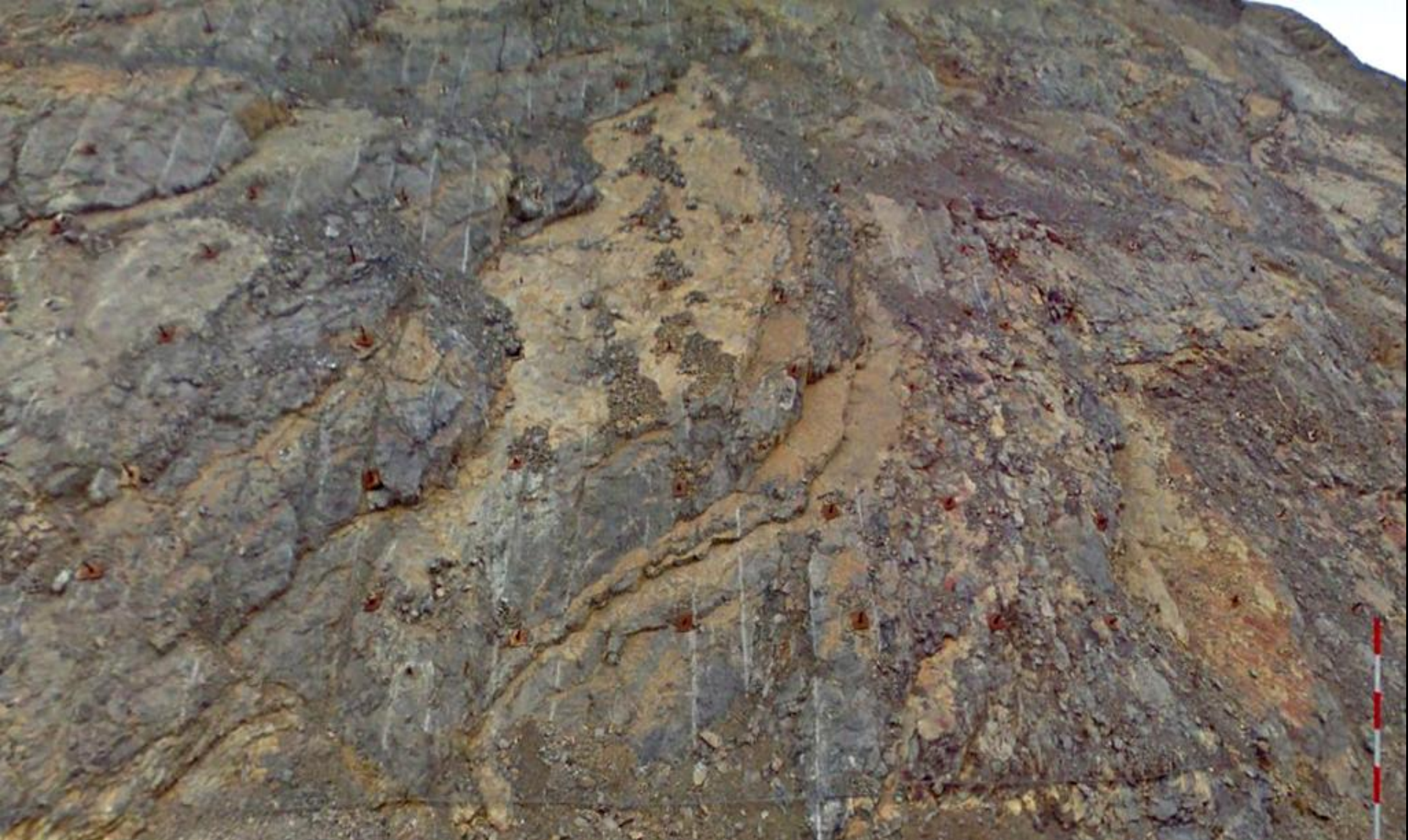
Bulones y mallazo en las calizas del Liásico, Jurásico Inf. W de Fonbellida, Cantabria. W Hoja de Las Rozas.
