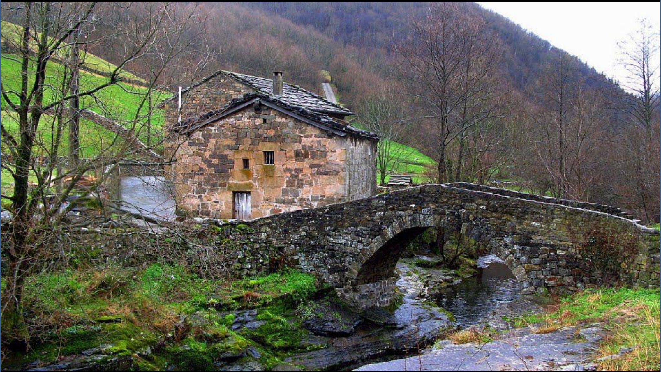
Puente sobre el Río Yera, Vega de Pas, Cantabria. NW Hoja de Espinosa de Los Monteros. (por icamino43-google)
