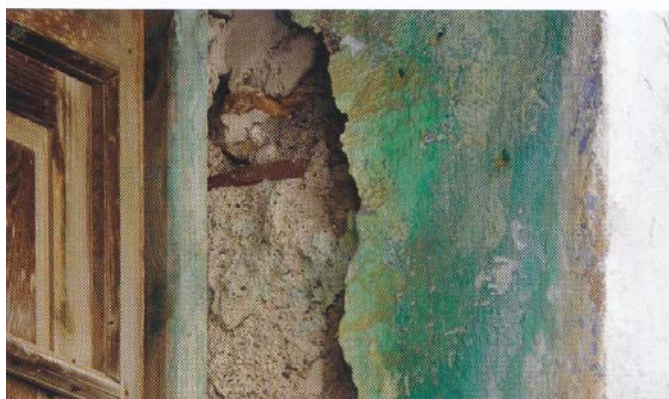
Capas de pintura en muros antiguos. Fuente: BALAGUER DEZCALLAR, P., VICÉN BANZO, L.: La arquitectura popular de Peñíscola. Manual de restauración del Centro Histórico . 1ª Ed. Benicarló: Onada Edicions, 2010, pag. 83.
