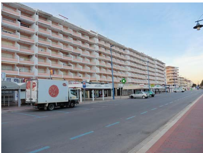
Vistas actuales de la edificación en el Polígono II (Playa Norte). Se observa la escasa cualidad del espacio urbano y espacios libres de uso privado, así como la escasa contribución de la edificación a mejorar la estética urbana. Fotografías propias.
