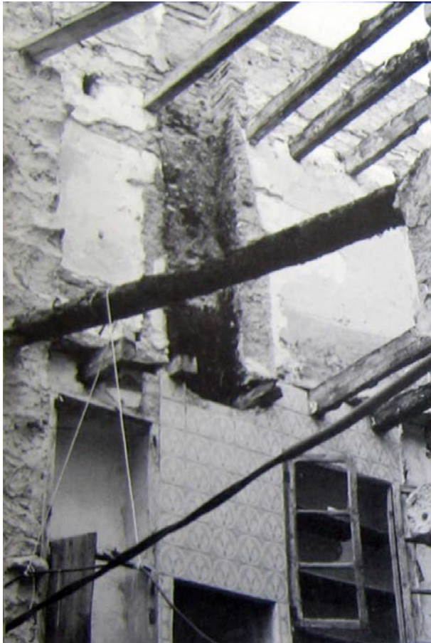
Ruinas en las que se aprecia el sistema estructural y la disposición de la cocina, con la chimenea y alacenas vaciadas de las paredes maestras. Fuente: UNIVERSIDAD POLITÉCNICA DE VALENCIA: Peñíscola: exposición de fotografías . Valencia, Reproval Editorial de la UPV, 2001.
