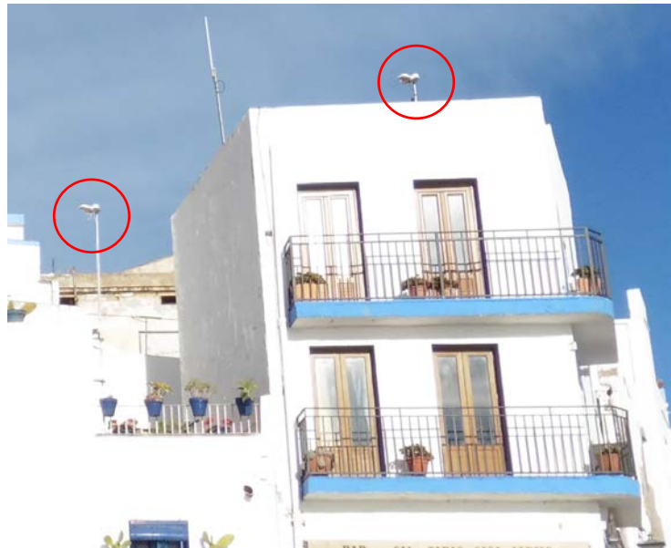
Panorámicas de Peñíscola y detalle tras la intervención para la eliminación de las viejas antenas de televisión. Se aprecia una importante reducción en el número e impacto de antenas de televisión. Fotografías propias.
