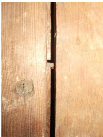
Figura 14. Clavo cuadrado: Elemento de ensamble entre la tabla y el marco. Orificio para unión machihembrada.
