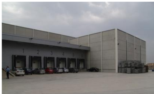
Figura12 Muelles para camiones refrigerados. Friopuerto (Valencia). Fuente: Fundación Valenciaport.
