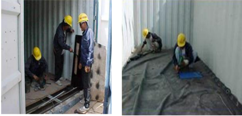
Figura 15 Mantenimiento de contenedores. Fuente: Mrsthai.com Container repair, maintenance & cleaning
