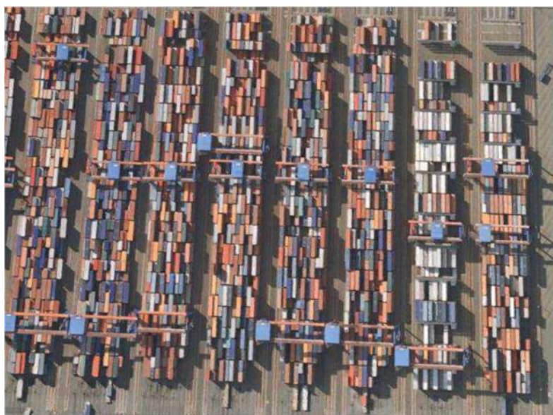
Figura 32 Configuración de layout utilizando grúas pórtico Fuente: Google Earth. Terminal CTA – Altenwerder (Hamburgo)
