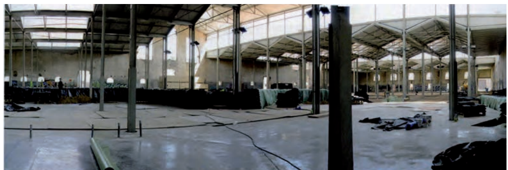
Imagen 102_ nave 17 (izquierda) y nave 15 antes de la intervención
