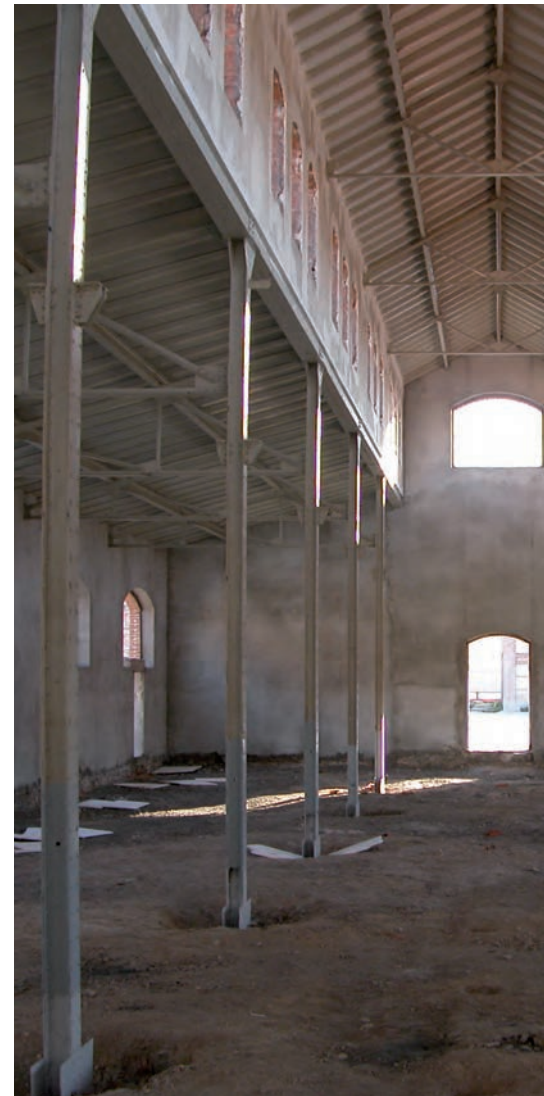
nave 12. antes de intervención
