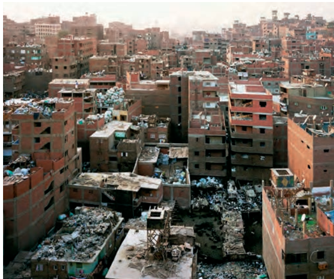
Azoteas de El Cairo, Egipto. Imagen tomada del blog "Willberwillberforce" https://willberwillberforce5333.wordpress.com/2011/05/11/garbage-city-cairo/ [Consulta: 10 de septiembre de 2015]
