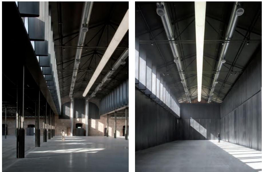
Imagen 77_Nave 16. Intervención materializada en acero sobre la envolvente existente de ladrillo.
