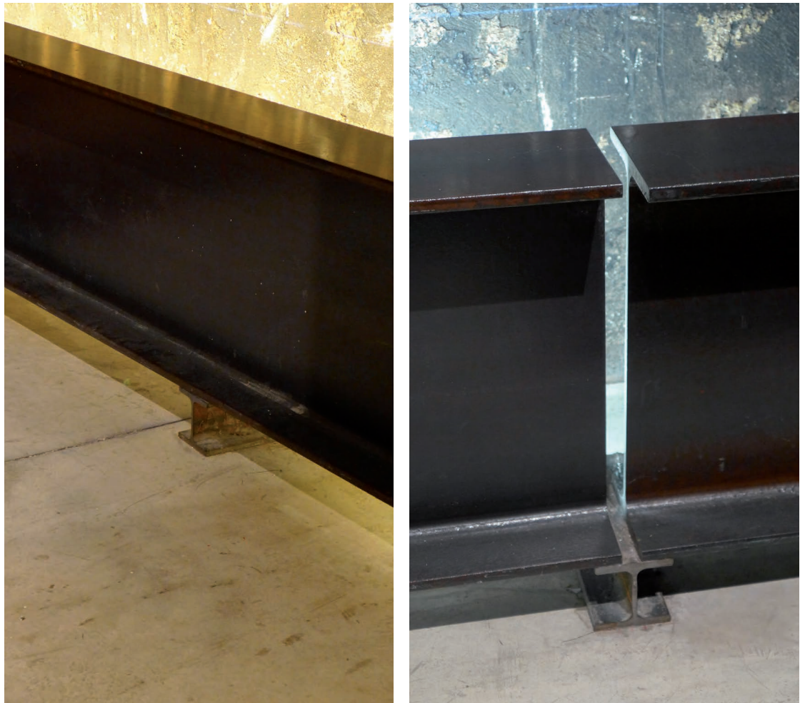
Imagen 126_Intermediae, las piezas se apoyan generando oscuros y manteniendo distancias de respeto entre lo nuevo y lo preexistente
