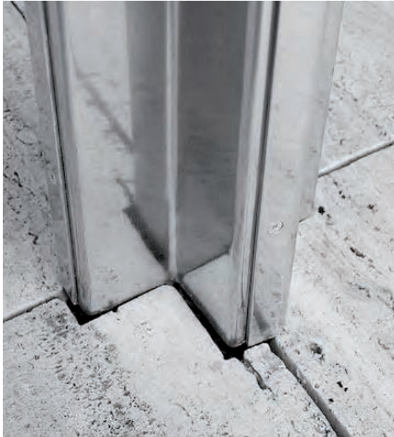
Pilar en cruz del Pabellón de Alemania para la Exposición Internacional de Barcelona en 1929. Mies van der Rohe. Reconstruido en 1986.
