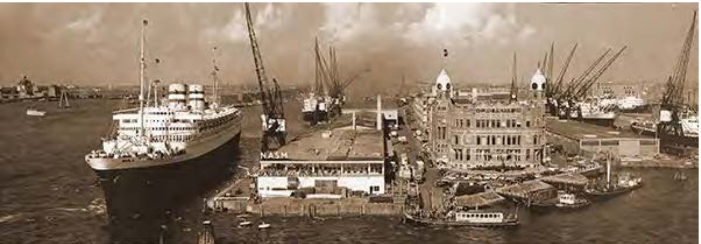
Hotel New York. ANTIGUAS OFICINAS HOLLAND AMERICA LINE. 1993. De Vos, Van der Have, y Loos. Holanda
