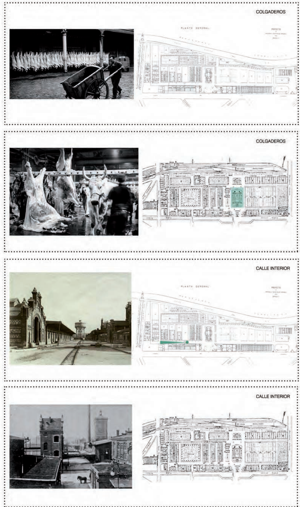
Imagen 6_Comparativa entre las instalaciones de los mataderos de Madrid y Colonia
