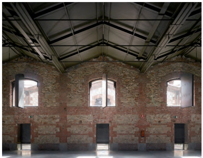
Imagen 105 b_ Fotografías interiores del sistema de apertura de huecos de fachada (esta página y la siguiente). Imágenes cedidas por los autores Carnicero+Vila+Virseda
