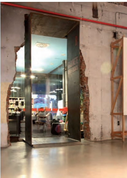
Imagen 94_Solución con marco de acero en el paso entre espacios en Intermediae
