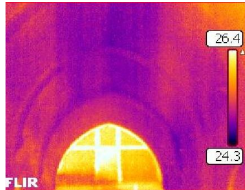
Ilustración 263 – Termografía de la bóveda.
