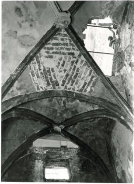
Ilustración 83 – Capilla P7 en 1967 antes de la rehabilitación. (Ferrant Vázquez, 1967)
