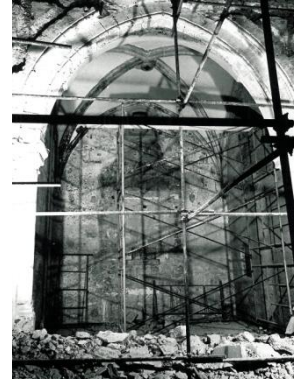
Ilustración 80 – Obras de rehabilitación del templo.(Ferrant Vázquez, 1967)
