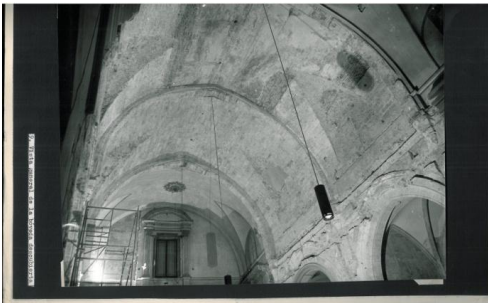
Ilustración 70 – Restos de lunetos en el tramo C5 de la bóveda central. (Ferrant Vázquez, 1967)
