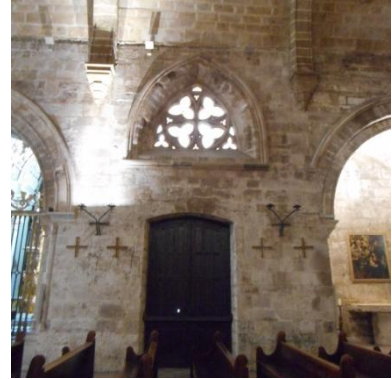
Ilustración 31 – Acceso norte desde el interior del templo.
