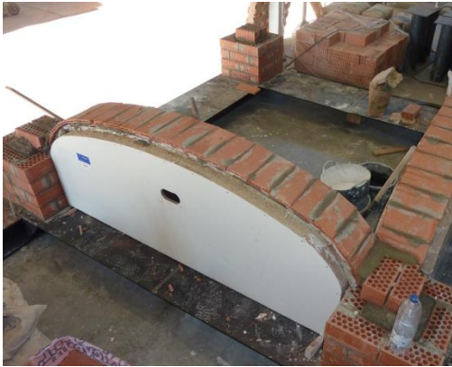
Ilustración 203.- Cimbrado de arcos
