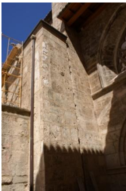
Ilustración 244– Ampliación del contrafuerte 3-4 del lado sur por el exterior.
