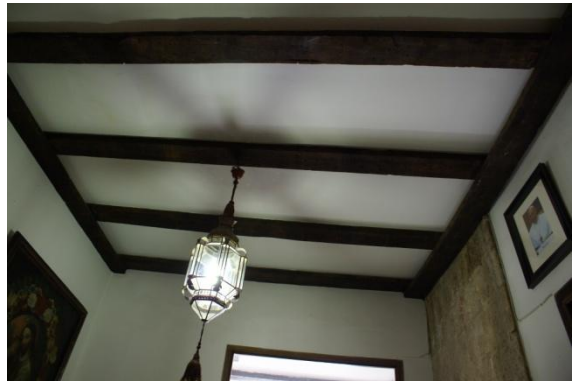
Ilustración 38 – Cubierta de la capilla V7
