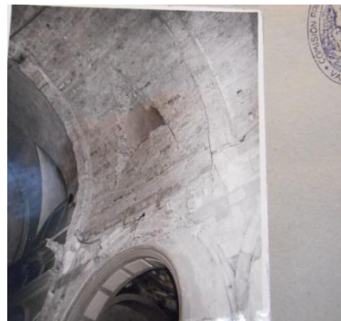
Ilustración 71 – Bóveda perforada por luneto. (Ferrant Vázquez, 1967).
