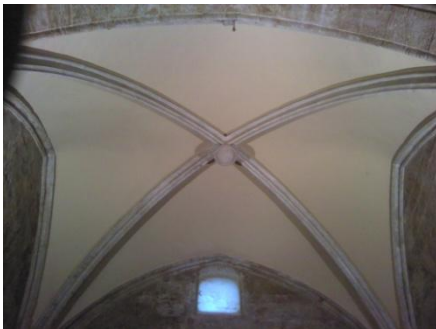
Ilustración 276– Fotografía de la bóveda de la capilla V6.
