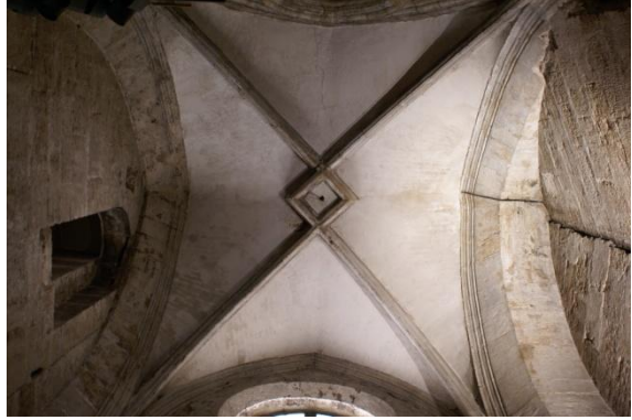
Ilustración 25 – Detalle de la clave doble de la capilla V1
