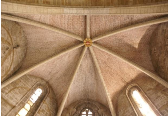
Ilustración 10 – Foto de la bóveda del ábside
