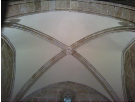
Ilustración 274– Fotografía de la bóveda de la capilla V5.
