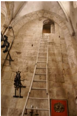
Ilustración 60 - Acceso a la cámara oculta desde la capilla V1
