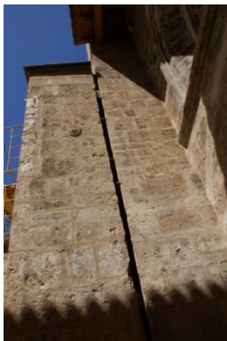
Ilustración 474– Contrafuerte 34 sur recrecido. .
