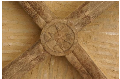
Ilustración 121 – Clave de la bóveda de la capilla funeraria.
