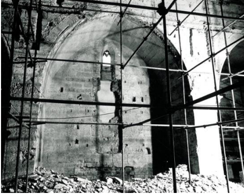
Ilustración 79 – Obras de rehabilitación del templo.(Ferrant Vázquez, 1967)
