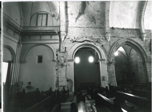
Ilustración 58 - Archivo Alejandro Ferrant. Bóveda barroca del tramo C6 sin retirar.
