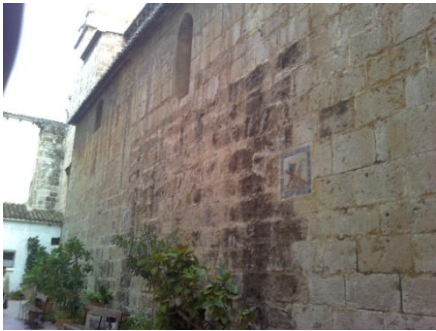
Ilustración 282- Fotografía muro exterior capillas norte.
