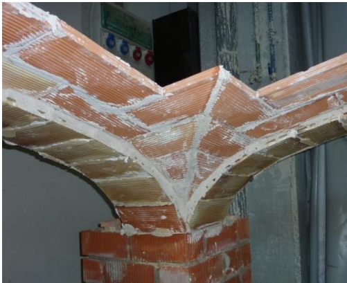
Ilustración 205.- Primera hilada bóveda
