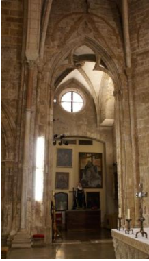
Ilustración 24 – Acceso a la capilla V1
