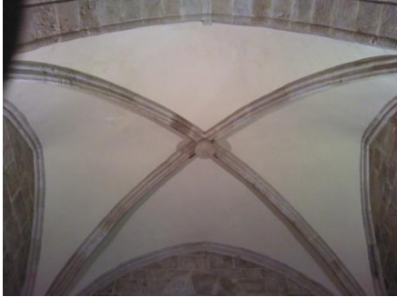
Ilustración 272– Fotografía de la bóveda de la capilla V4.
