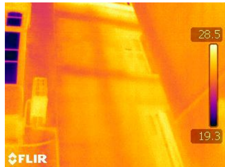
Ilustración 287 – Termografía fachada de obra nueva en el patio norte.
