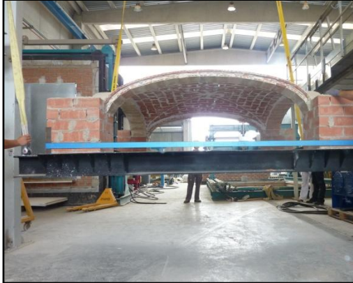
Ilustración 209.- Traslado de bóveda sobre marco de acero
