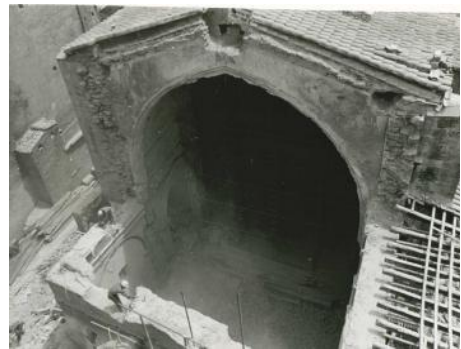
Ilustración 82 – Tramo 6 durante la rehabilitación (Ferrant Vázquez, 1967)
