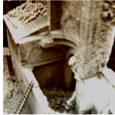
Ilustración 84 – Capilla V5 en 1967 antes de la rehabilitación.
