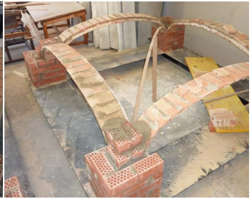
Ilustración 204.- Arcos con guías para bóveda
