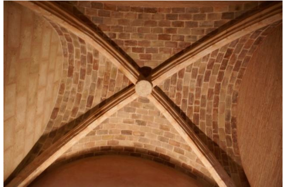
Ilustración 40 – Bóveda de la capilla C7
