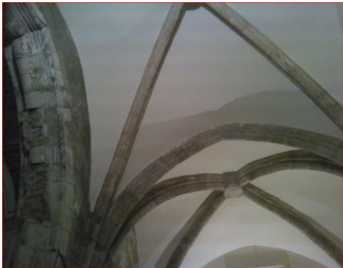
Ilustración 270– Fotografía de la bóveda de la capilla P7.
