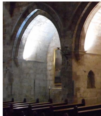
Ilustración 245– Ampliación del contrafuerte 3-4 del lado sur por el interior.
