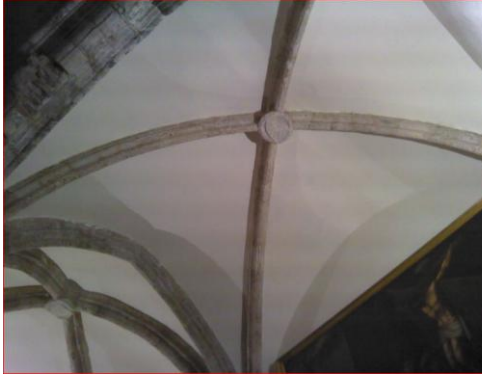
Ilustración 268– Fotografía de la bóveda de la capilla P7.
