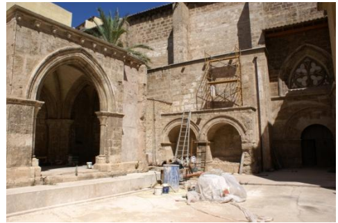
Ilustración 119 – Capilla funeraria y arcosolios de la fachada sur.
