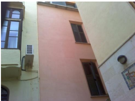
Ilustración 286- Fotografía fachada de obra nueva en el patio norte.
