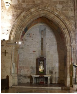
Ilustración 26 – Acceso a la capilla V2
