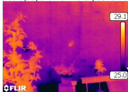
Ilustración 259 – Huella del calor de la mano del director de la tesis en el muro retirada segundos antes de tomar la imagen.
