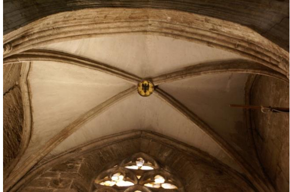
Ilustración 14 – Clave de la capilla P1
