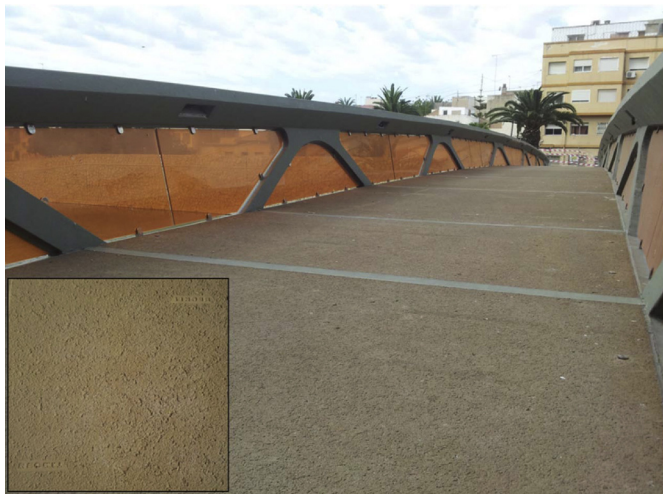
Figura 29. Textura de las losas superficiales.
