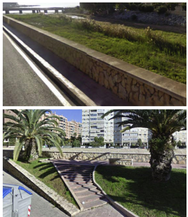
Figura 3. Desembarco y acera disponible inicialmente en la margen izquierda (arriba); escaleras existentes y desembarco en la margen derecha (abajo).
