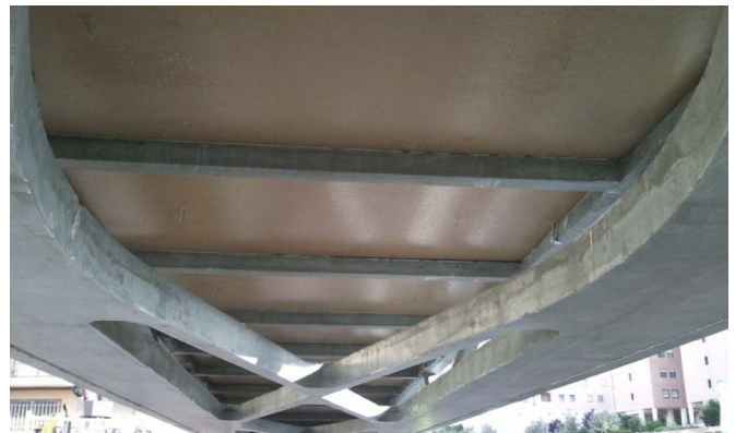
Figura 28. Disposición de las losas sobre los nervios longitudinales y transversales.
