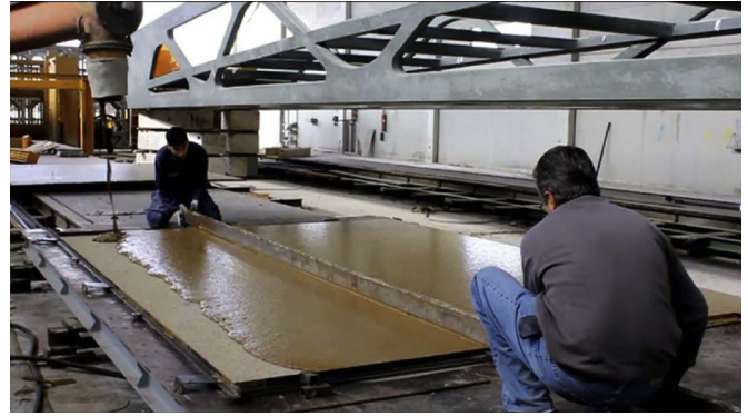
Figura 27. Fabricación de las losas con HMAR ocre.
