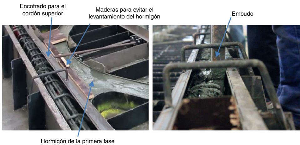
Figura 23. Preparación del encofrado del cordón superior (izquierda) y vertido con embudo (derecha).
