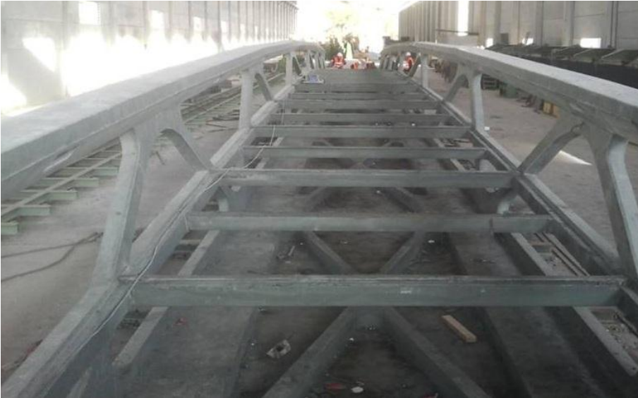
Figura 26. Pasarela tras la finalización de la cuarta fase de hormigonado
