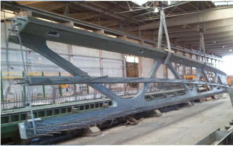
Figura 24. Transporte de una mitad de la celosía lateral (izquierda); conexión de ambas celosías (derecha)
