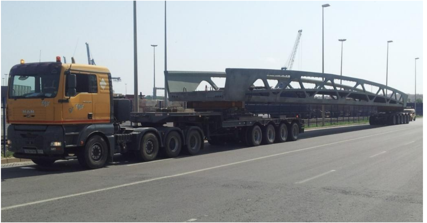
Figura 31. Transporte de la pasarela a su paso por la A-3 a la altura de Buñol (Valencia)
