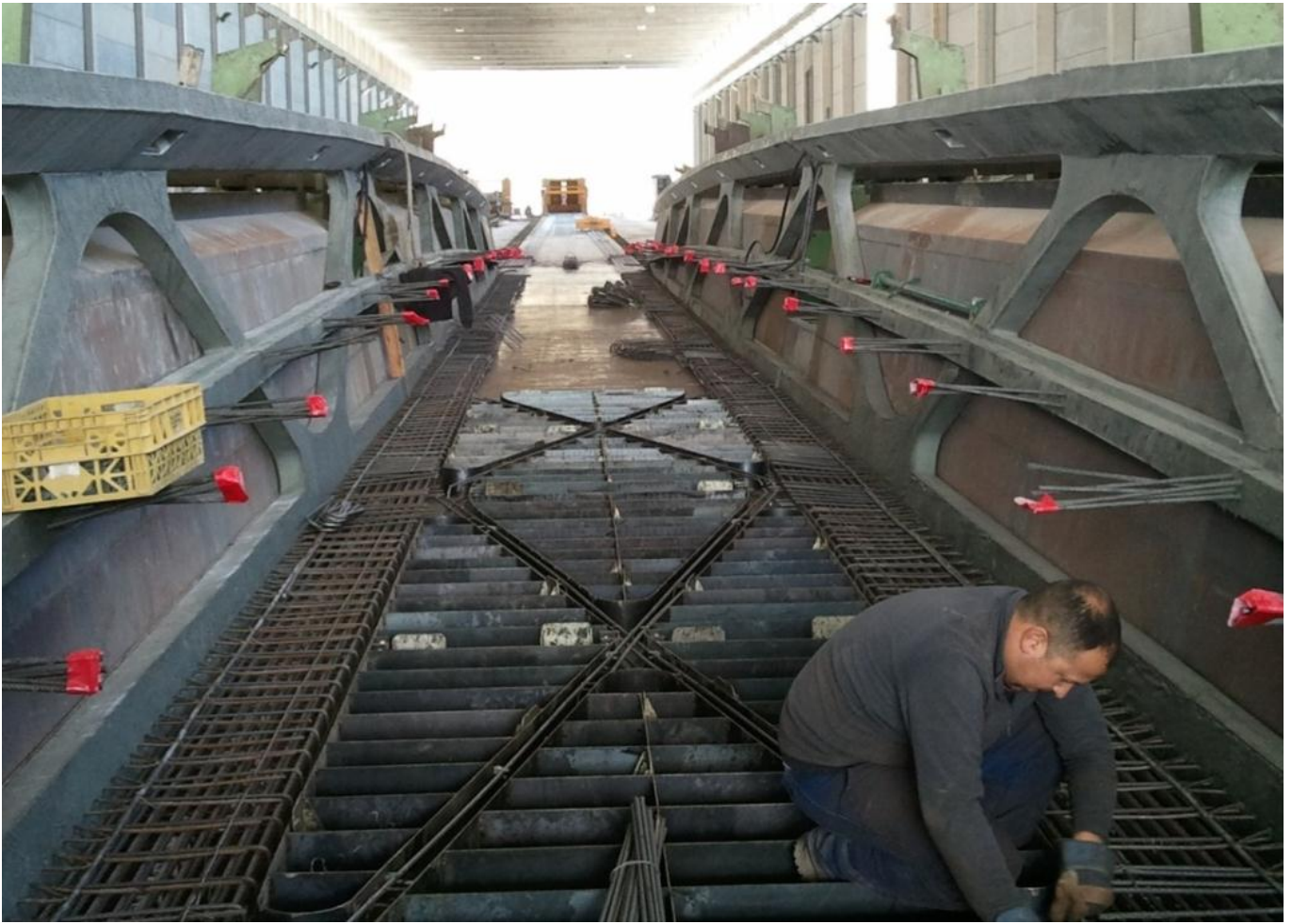
Figura 25. Tercera fase de hormigonado. Preparación de la celosía inferior en X
