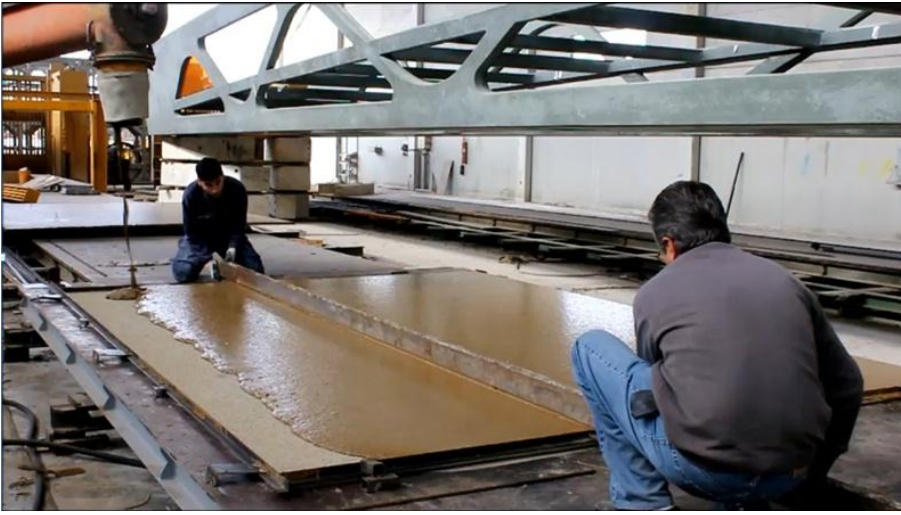
Figura 27. Fabricación de las losas con HMAR ocre
