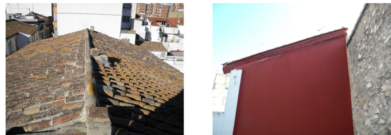
Figura 44: Cubiertas de teja cerámica curva a dos y un agua (Propia)
