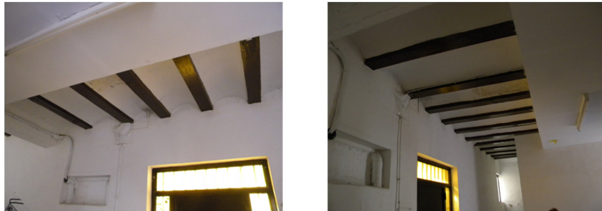
Figura 40: Detalle forjado de revoltones calle Puzol nº 6 (Propia)
