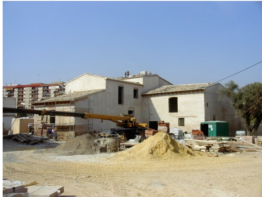
Figura 49: Proceso de rehabilitación Alquería Barrinto (Web Ayto.Valencia)
