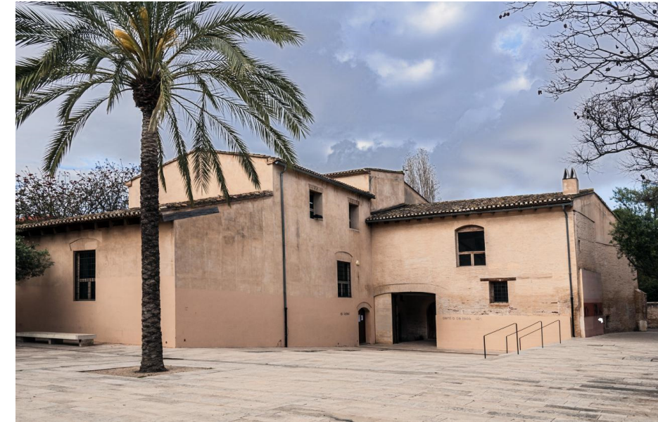
Figura 51: Estado rehabilitado Alquería Barrinto (Web Ayto.Valencia)
