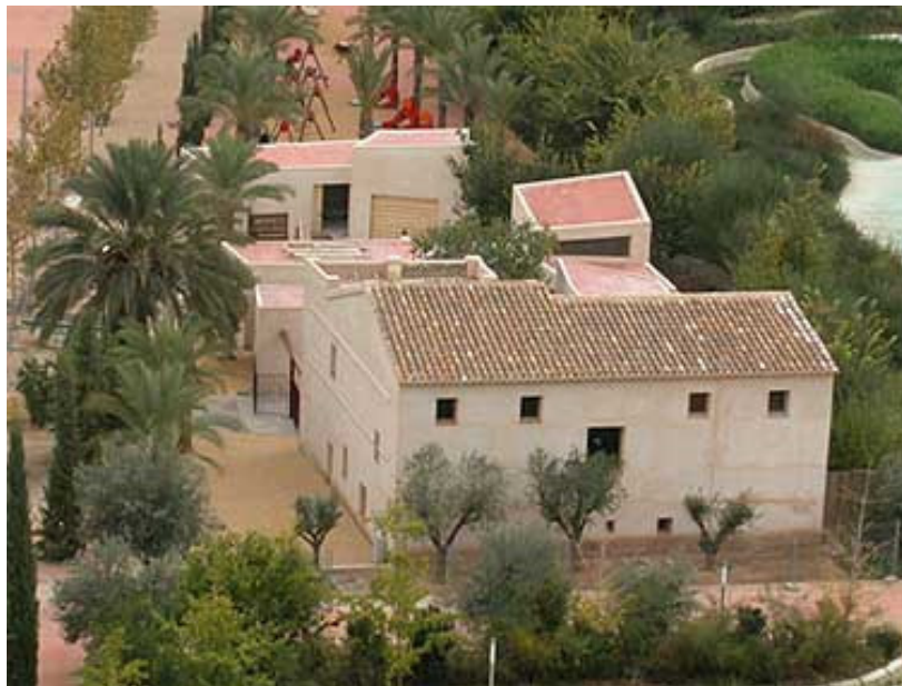
Figura 46: Rehabilitación Alquería Félix (Web Ayto.Valencia)
