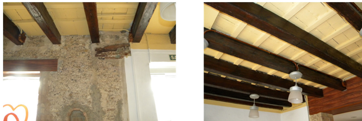
Figura 42: Detalles forjado vigueta de madera en calle Puzol nº8 (Propia)
