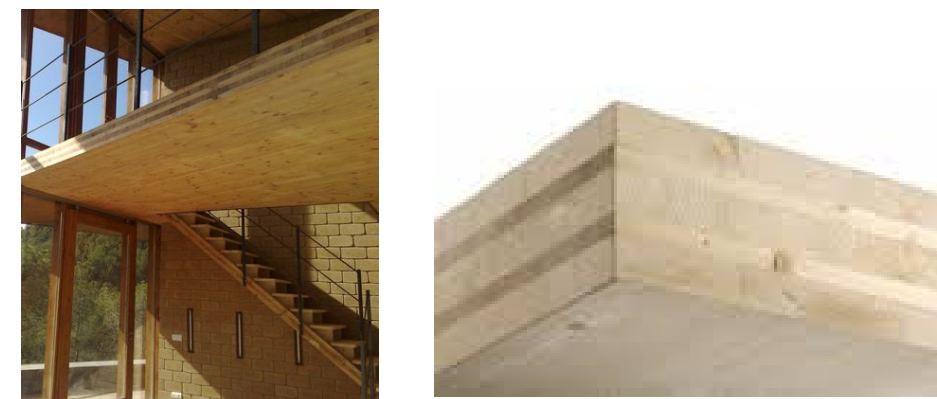
Figura 59: Forjado similar ampliación y refuerzo (Web CLT)
