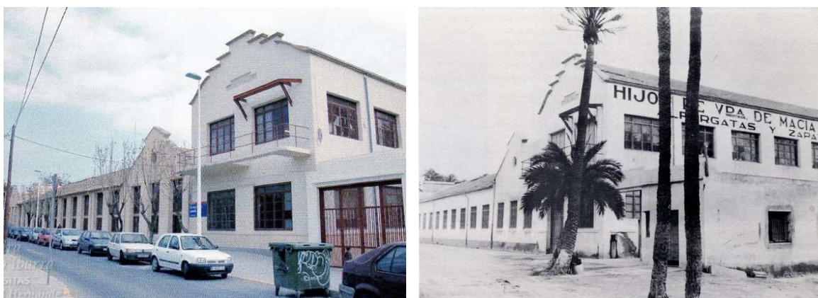
I.350, I.351. Fachada Calle Candalix año 2002 y mitad década de los 50.
