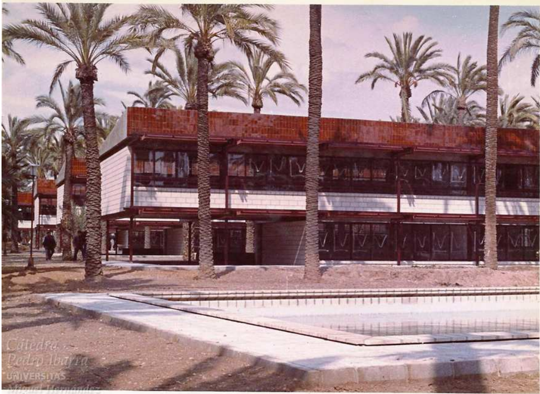
I.277. Vista exterior del pabellón de aulas y piscina en construcción, 1971.
