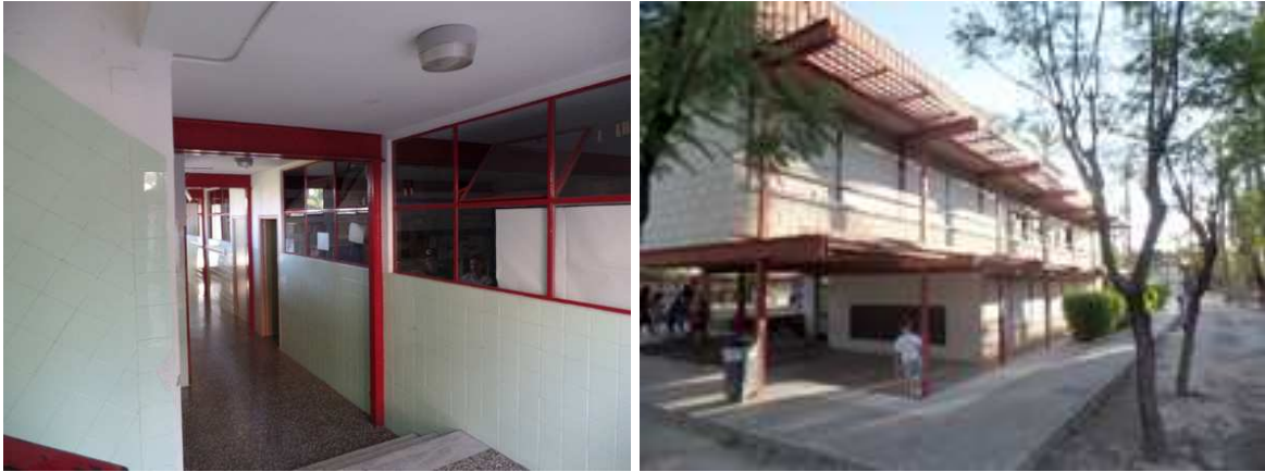
I.282, I.283. Vista actual interior del pabellón de aulas y detalle del espacio exterior bajo cubierta.
