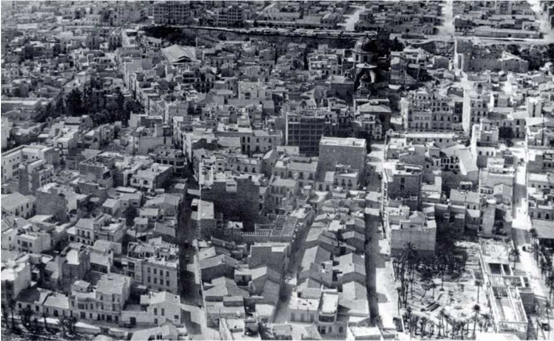
I.140. Vista aérea del centro de la ciudad en 1960. A la derecha abajo, el Colegio Fernández Cruz en construcción.
