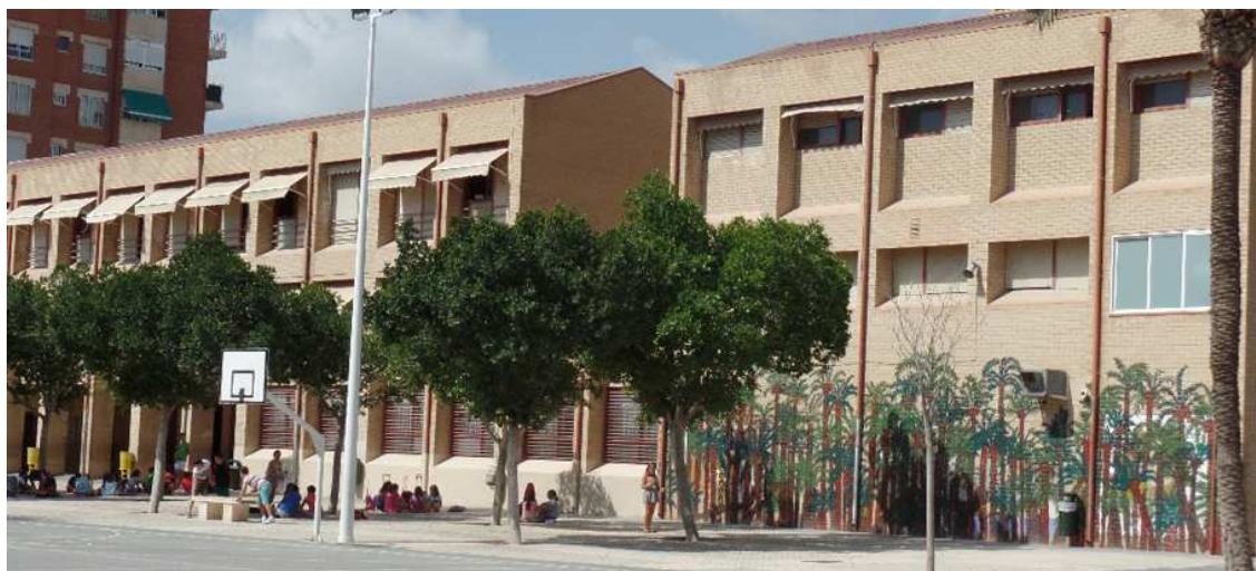
I. 335, I.336. Testero colegio Sanchis Guarner y El Plá. I.337, I.338, I.339. Interior y exterior colegio Miguel de Cervantes,
