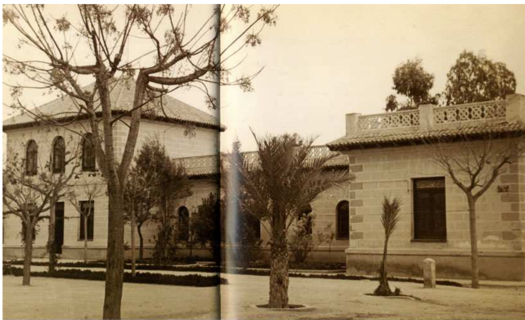
I.10. Escuelas Graduadas en Elche. Pedro Sánchez Sepúlveda, arquitecto, 1931
