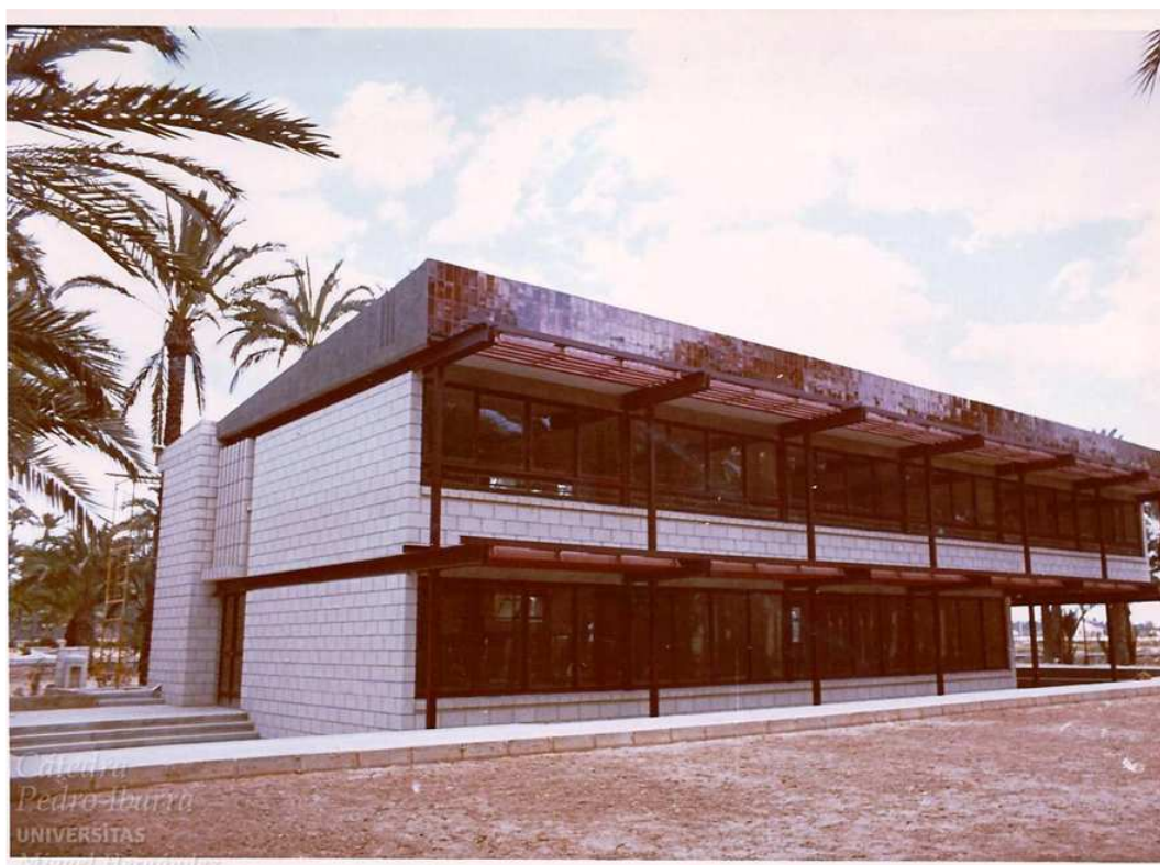
I.276. Vista exterior del pabellón de aulas en construcción, 1971.
