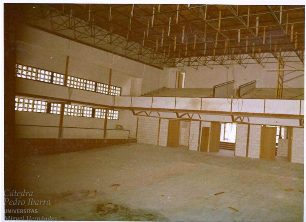
I.278. Interior del pabellón del salón de actos en construcción, 1971.
