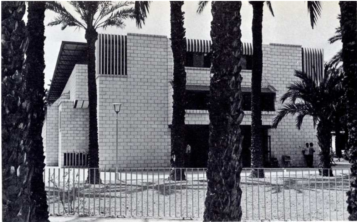
I.293. Fachada Norte del Salón de actos, primera década de los 70.
