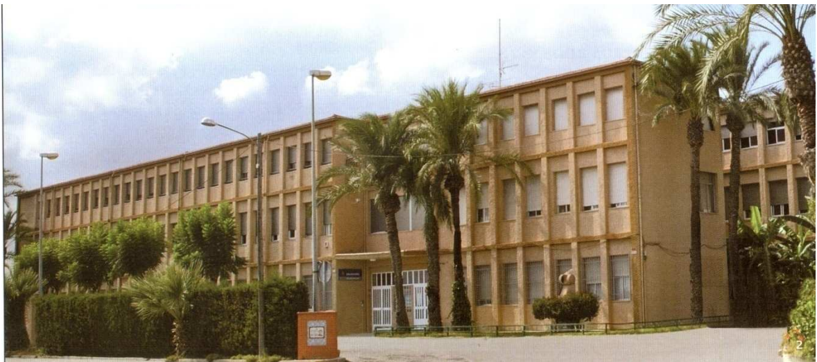
I.382. Vista exterior actual Escuela profesional San José Artesano. Fachada de levante del pabellón principal.
