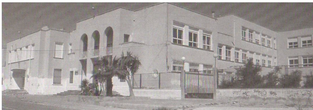
I.54. Vista del Instituto Jorge Juan. Juan Vidal, Arquitecto, 1942.
