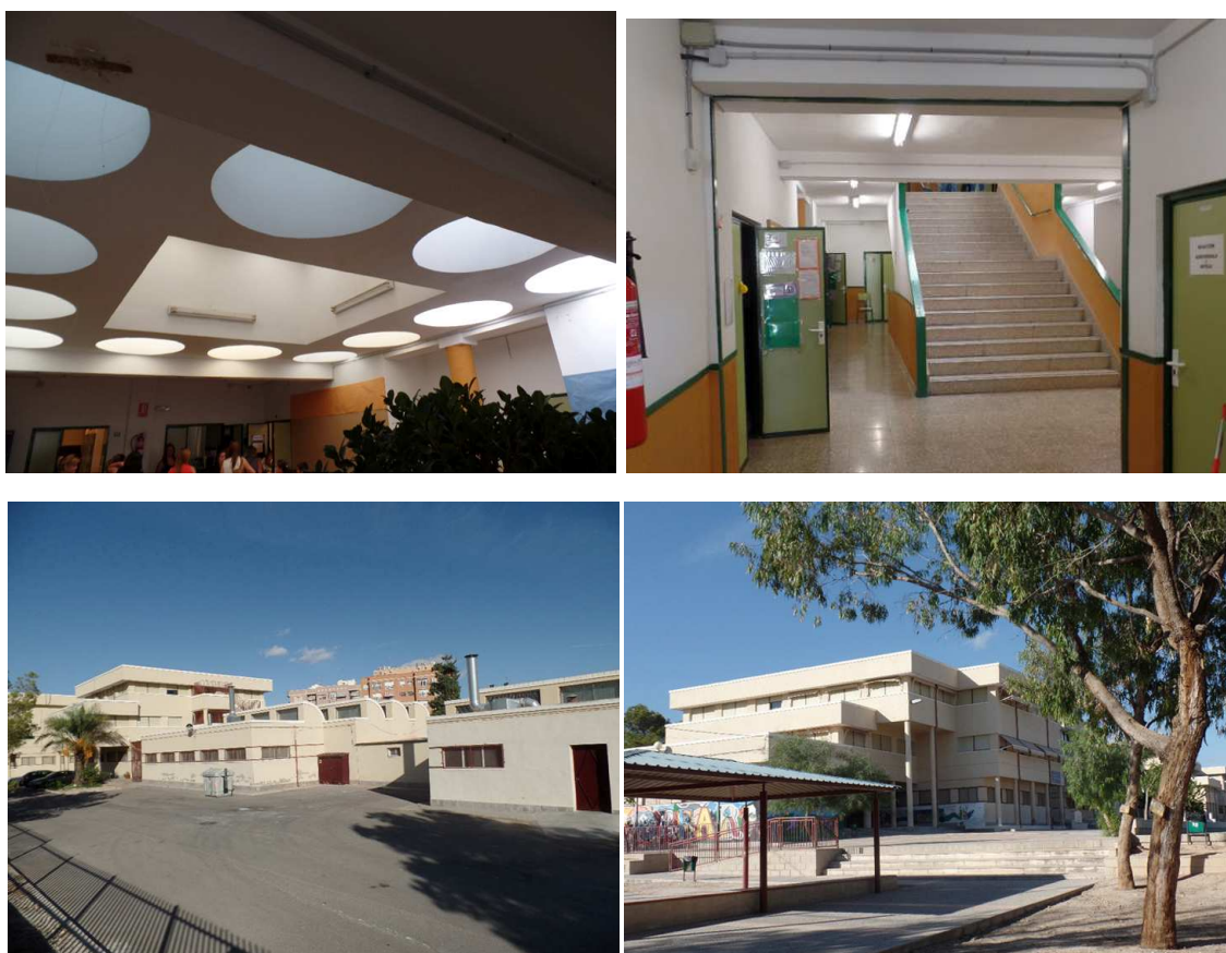
I.323; I.324. Vista interior y escalera en el colegio Julio. M. López Orozco. I.325, I.326. Vistas actuales del exterior del colegio Julio M. López Orozco.
