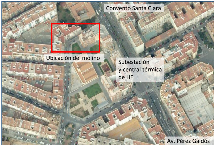
Figura 5.9. Vista aérea de la manzana donde se ubicaba el Molino de Nou Moles. Junto al molino se construyó una subestación y central térmica de Hidroeléctrica de la que actualmente permanece restaurado el edificio de oficinas. Fuente: elaboración propia sobre imagen de Google maps.
