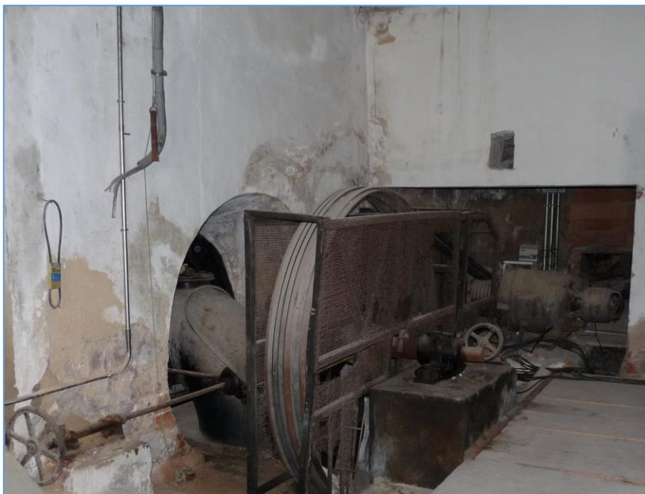
Figura 5.1. Turbina y alternador en el complejo industrial Electroquímica del Serpis en 2011. Fuente: Archivo Personal de Juan Martínez Altur.
