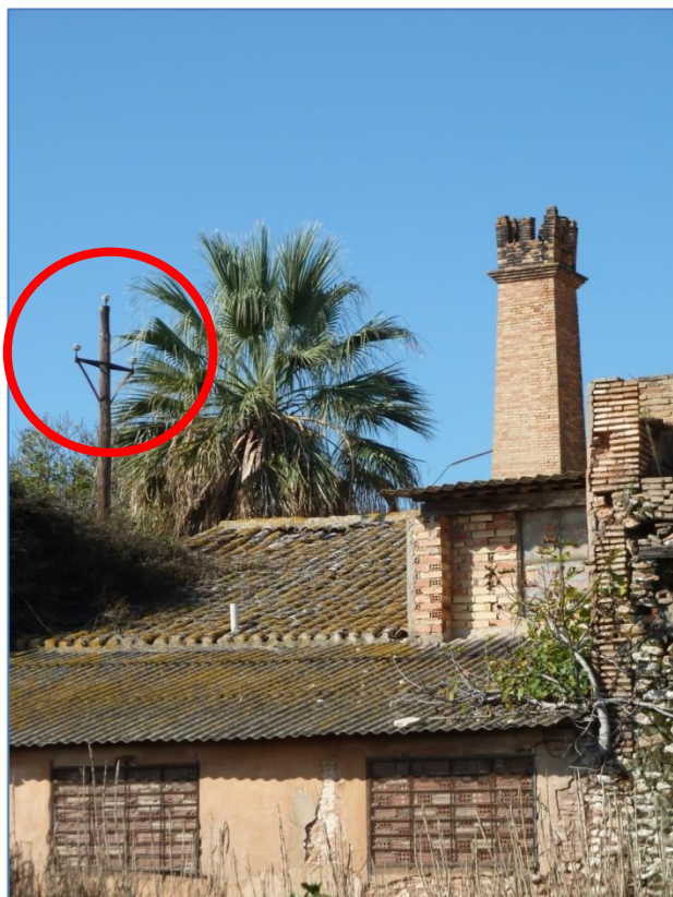
Figura 5.7. Molino grande de Silla. Poste trifilar que todavía permanece. Año 2011. Fuente: archivo personal de Antonio Armero.
