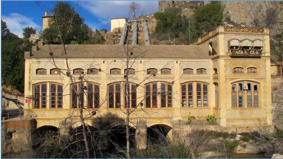
Figura 6.16. Edificio de turbinado de la SVE en la actualidad. Fuente: Ana Planells Pérez, 2015
