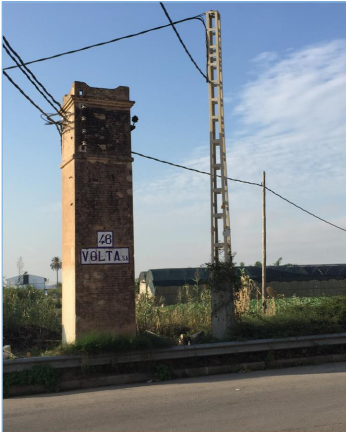
Figura 6.22. Antigua torreta de apoyo de líneas en el polígono industrial de Alboraya. Fuente: Archivo personal de Antonio Armero.
