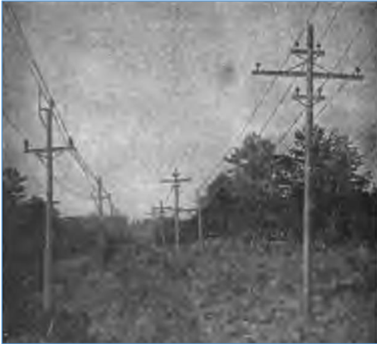
Figura 3.17. Postes de 11 KV (derecha) y 44 KV (izquierda). Fuente: Hawkins (1917).
