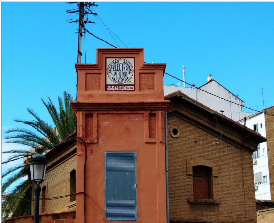
Figura 6.21. Subestación 882 de Electra Valenciana en Ruzafa. Fuente: Flickr. Autor: Antonio Marín Segovia. Obtenida de
