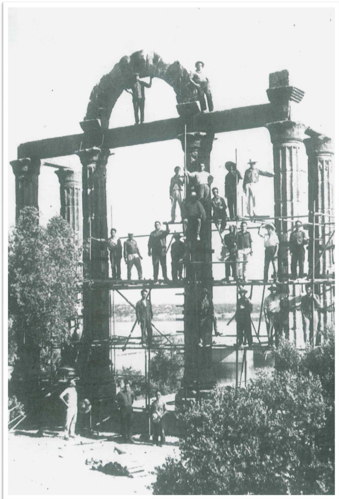
Fotografía realizada el día del montaje del templo en su nuevo emplazamiento (extraída de Santos Sánchez 1993)
