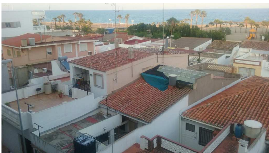
FIGURA 3.1 DEPÓSITOS EN AZOTEAS
