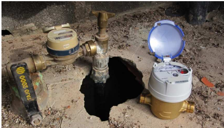
FIGURA 3.3 CAMBIO DE CONTADOR PARA LA OBTENCIÓN DEL PATRÓN DE CONSUMO
