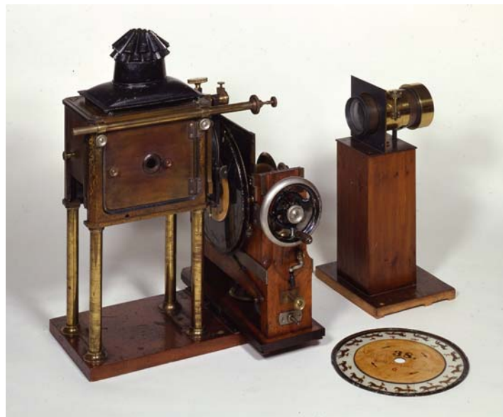
# 25 Imagen del zoopraxinoscopio. Eadweard Muybridge, 1879.
