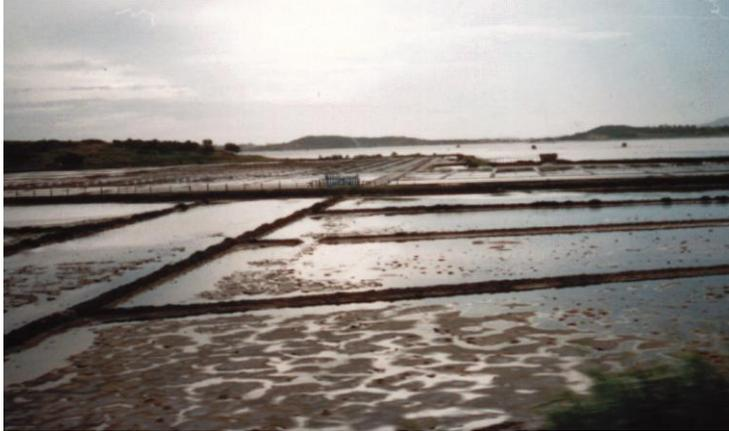
**Figura I.10.** Detalle del proceso de cristalización fraccionada para la recuperación de sal marina.
