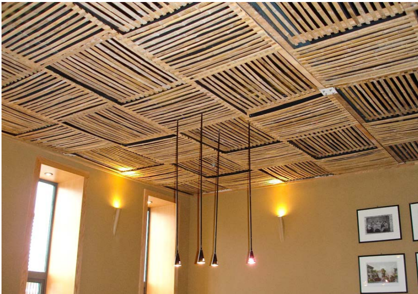
Fig. 214: Integración de iluminación y otros elementos del techo. Foto: Elaboración propia (2010)
