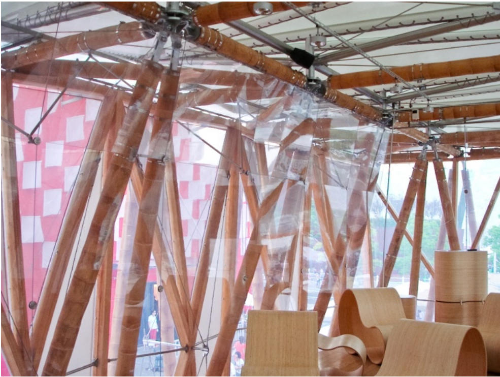
Fig. 101: Láminas transparentes de protección interior. Foto: Elaboración propia (2010)
