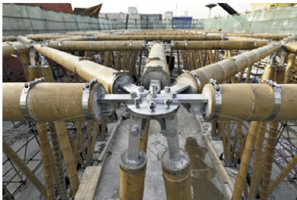
Fig. 109: Unión del bambú y acero en la parte superior. Foto: Elaboración propia (2010)
