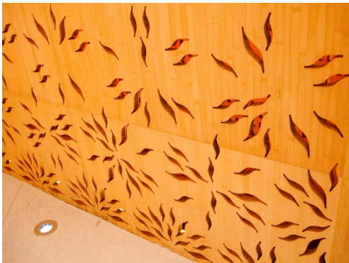
Fig. 195: Detalle de los paneles interiores con motivos cortados al laser. Fotos: Elaboración propia (2010)
