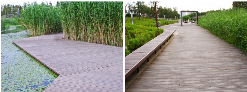
Fig. 244: Dos vistas del paseo. Foto: Elaboración propia (2010)
