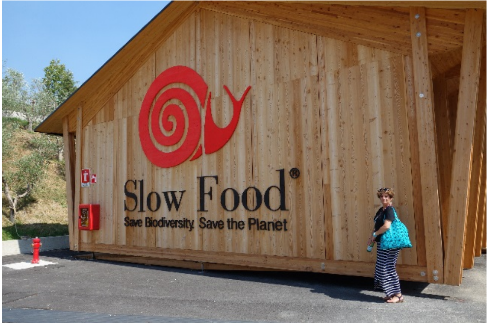
Fig. 101: Pabellón Slow Food, imagen del exterior del conjunto. Fuente: Elaboración propia (2015)
