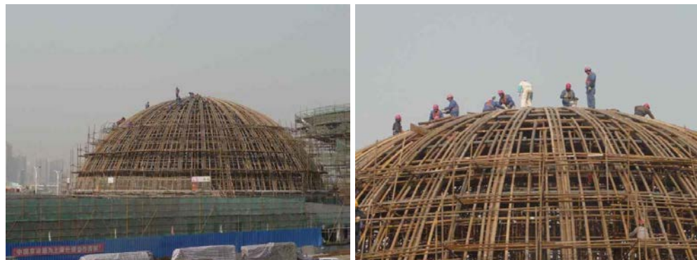
Fig. 151: Cúpula completa. Vista durante el montaje. Fuente: Press Material
