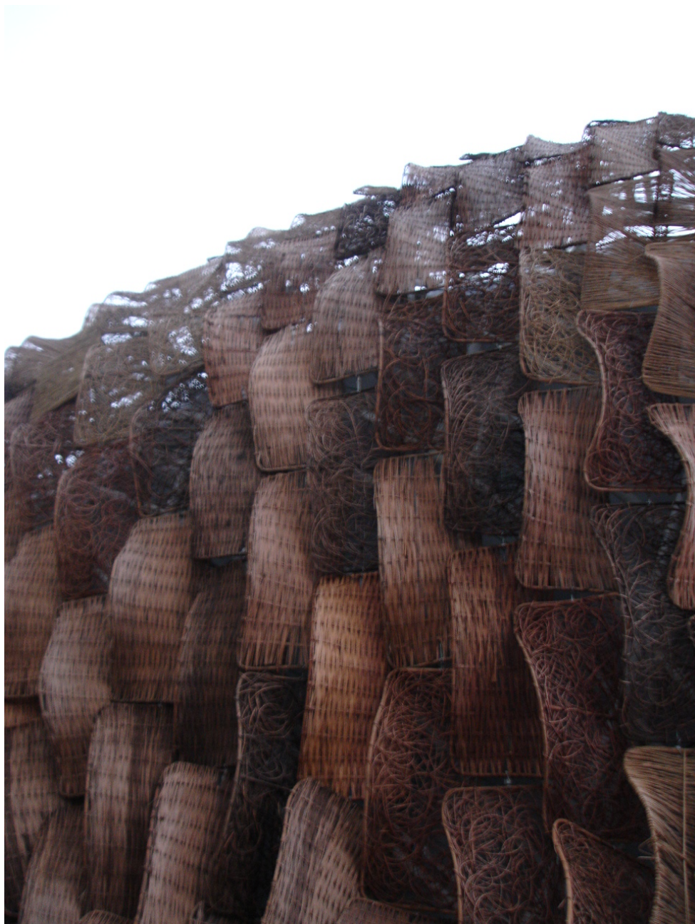
Fig. 50: La "piel" del cesto, tejida en mimbre, ratán y bambú. Foto: Elaboración propia (2010)
