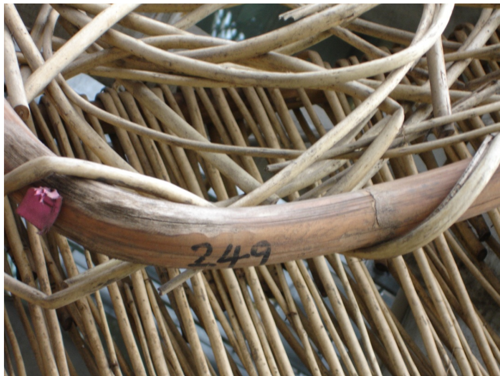
Fig. 64: Detalle de panel marcado de cada pieza para facilitar el montaje. Foto: Elaboración propia (2010)
