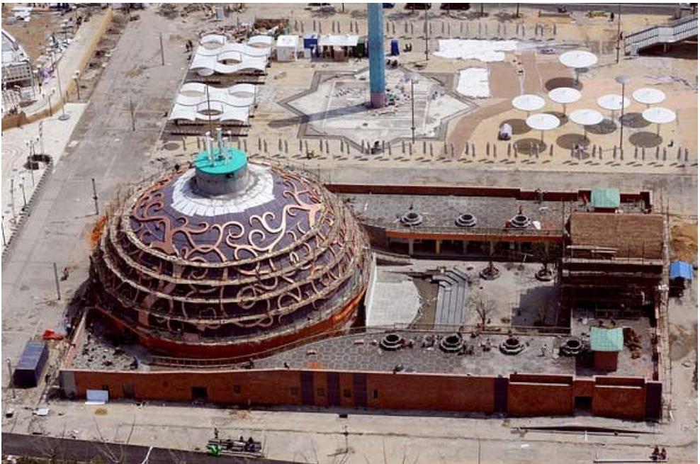
Fig. 155: Disposición de la plantilla sobre la cúpula. La plantilla sirve de guía la colocación de las piezas de cobre del Árbol y la disposición de las plantas. Fuente: Press Material
