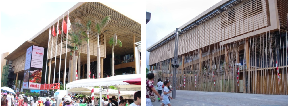
Fig. 164: Exterior. Se aprecian los paneles móviles de madera. Fotos: elaboración propia (2010)
