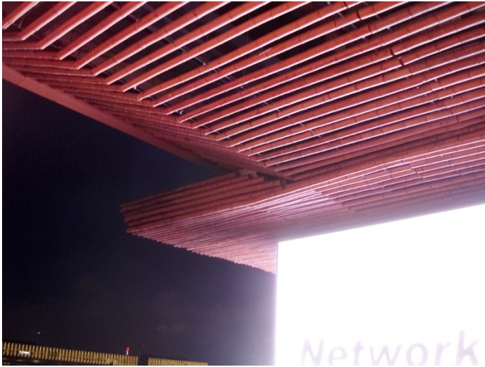
Fig. 165: El techo creado con varas de bambú. Fotos: Elaboración propia (2010)
