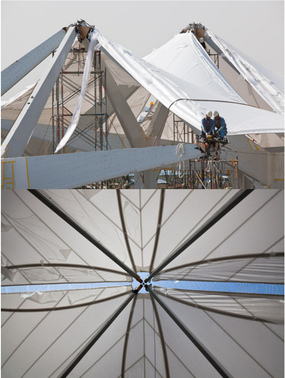
Fig. 192: Colocación y tensado del recubrimiento exterior. Fuente: Patrick Wack
