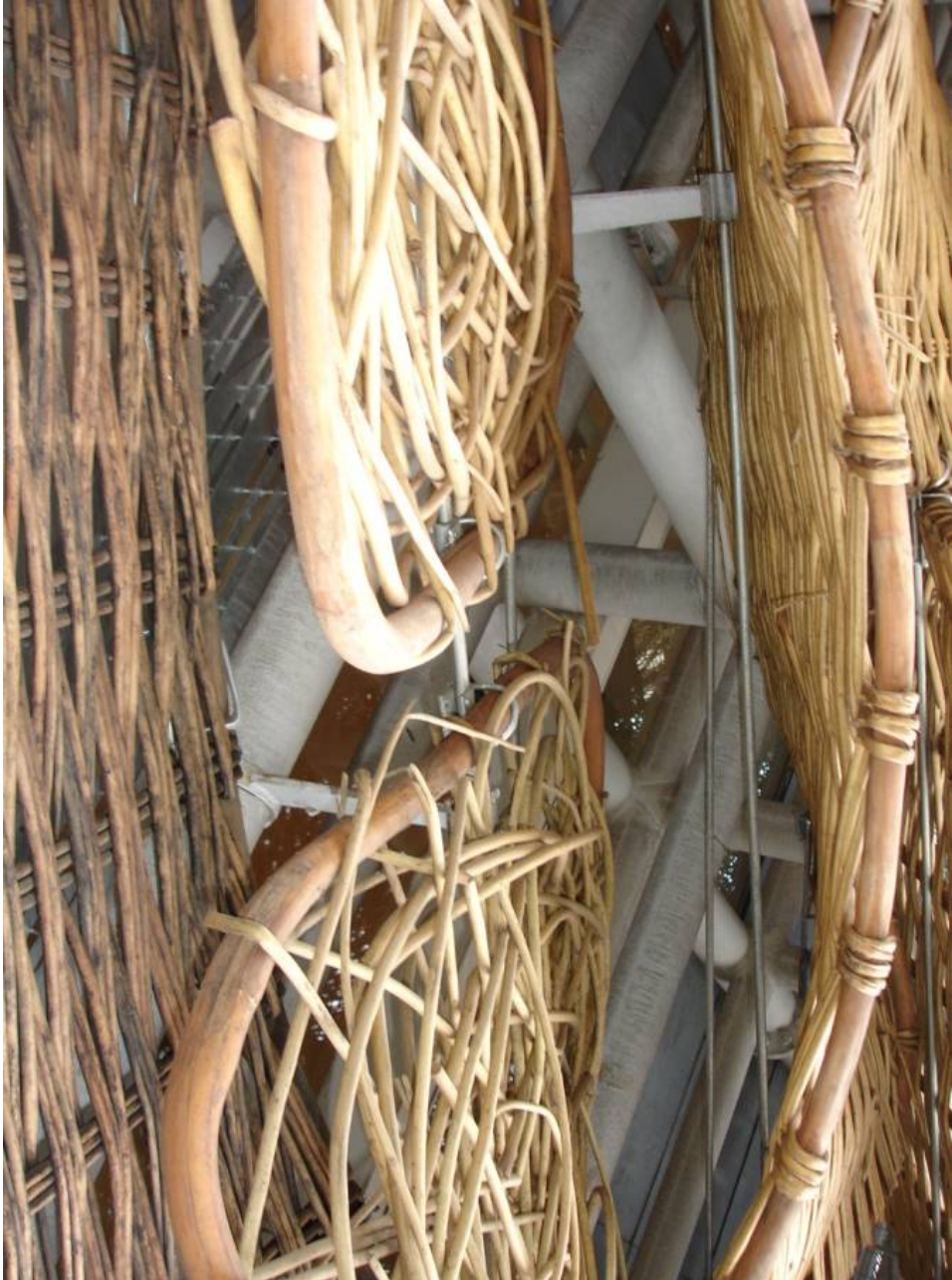
Fig. 76: Paneles, estructura de acero, cables y sujeción. Fotos: Elaboración propia (2010)
