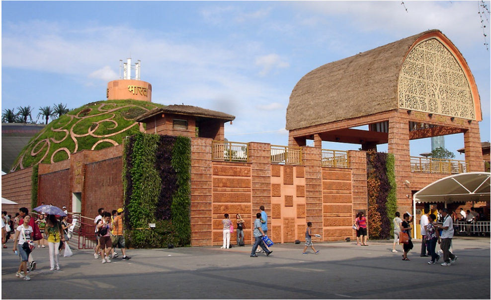
Fig. 134: Vista general de la puerta principal. En los paneles rectangulares, escenas de los cuentos Jakata. En el zaguán, el Árbol de la Vida. Fuente: Elaboración propia (2010)
