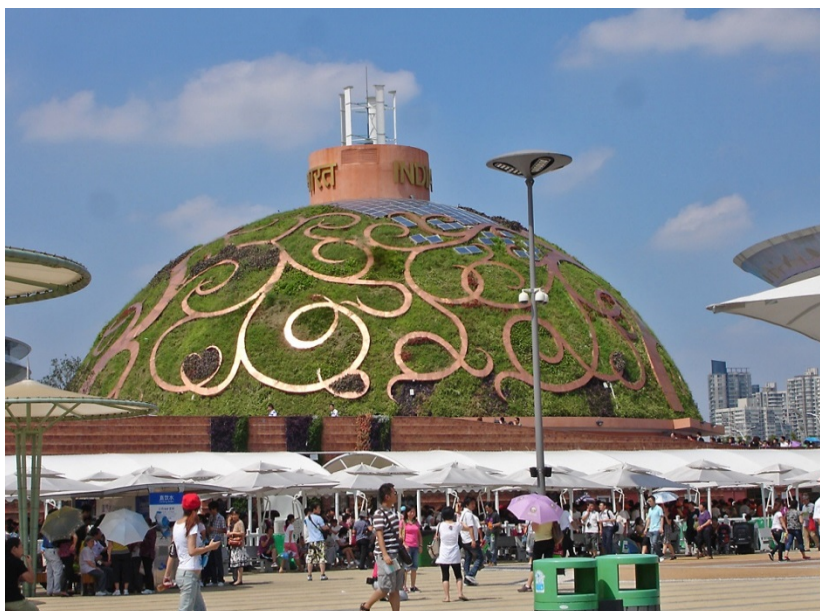
Fig. 137: La cúpula. Se aprecian los paneles solares en la parte superior y el recubrimiento vegetal. Fuente Elaboración propia (2010)
