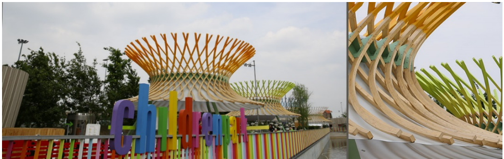
Fig. 68: Espacio en forma de bobinas gigantes donde se albergaban las exposiciones y actividades infantiles. En el detalle se observa cómo se trabajaron como celosías de madera. Fuente: © ZPZ Partners
