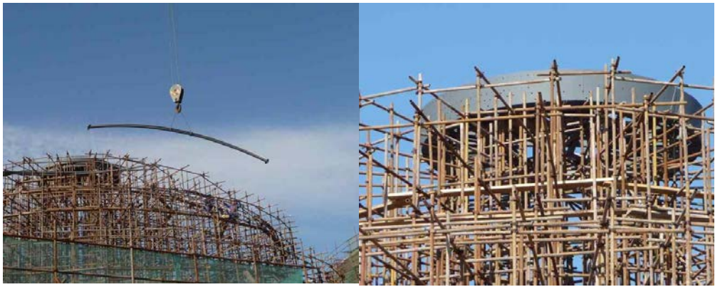
Fig. 148: Construcción de la estructura. Fuente: Press Material
