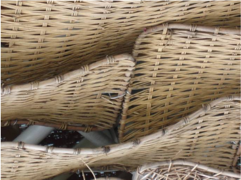
Fig. 60: Tejido tradicional aplicado a los paneles para el recubrimiento exterior del pabellón. Foto: Elaboración propia (2010)
