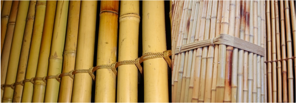
Fig. 224: Detalle de pared construida con bambú anudado. Abajo: En primer plano, columna, al fondo, la pared. Fotos: Elaboración propia (2010)
