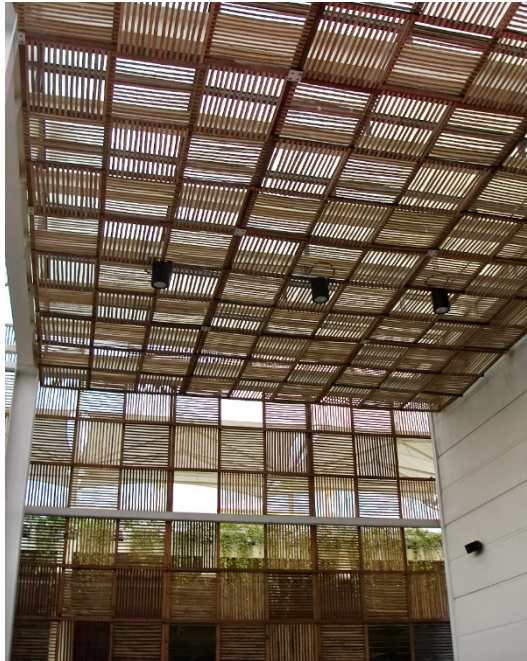
Fig. 217: Vista desde el interior del entramado de bambú. Foto: Elaboración propia (2010)
