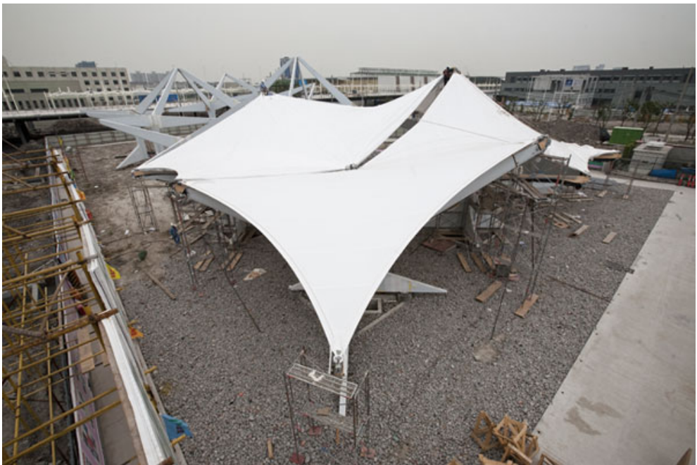
Fig. 191: Cubierta: Colocación y tensado de la membrana superior. Fuente: Patrick Wack
