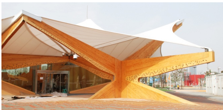
Fig. 179: En esta imagen se aprecia la estructura de uno de los árboles. Fuente: Copyright© Helen & Hard
