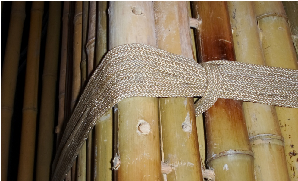
Fig. 225: Detalle del atado, donde se observan las cuñas de refuerzo. Elaboración propia (2010)
