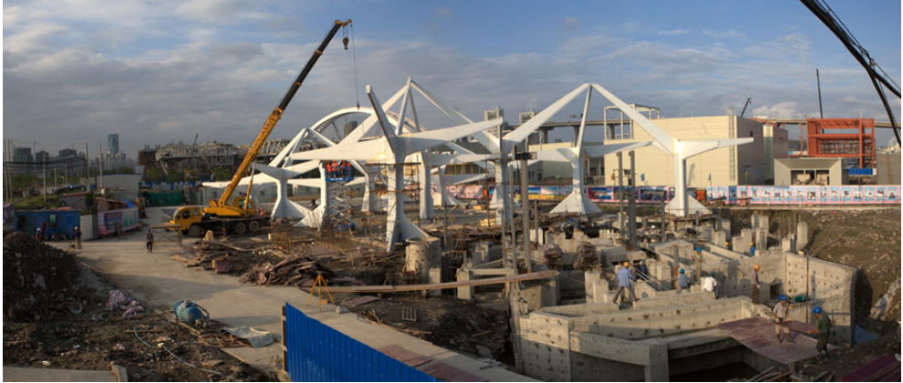
Fig. 190: Montaje con grúas de la estructura principal. Fuente: Patrick Wack
