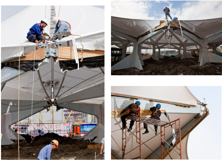
Fig. 193: Técnicos trabajando en la terminación de la cubierta. Se observa la posterior eliminación del material protector de la madera. Fuente: Patrick Wack
