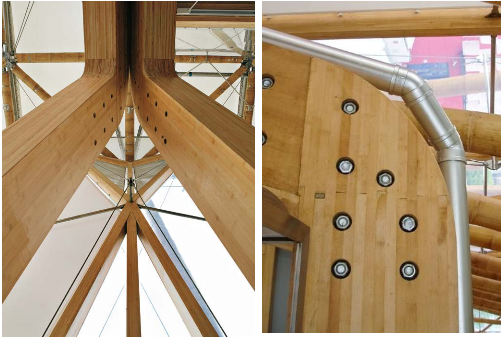
Fig. 99: Se aprecian las vigas internas de bambú laminado que convergen en la parte superior. Fotos: Elaboración propia (2010)
