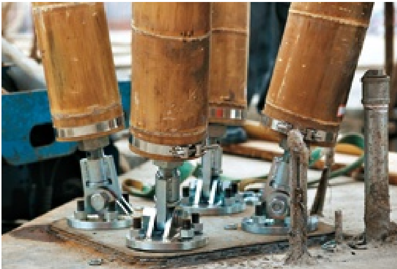
Fig. 108: Unión de vigas de bambú y acero en el suelo. Foto: Elaboración propia (2010)
