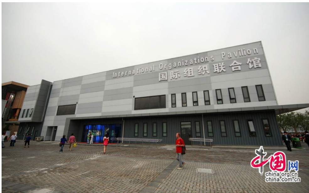
Fig. 119: Edificio International Organitacions Pavillion, en el que se albergaba INBAR. Fuente: http://www.china.org.cn
