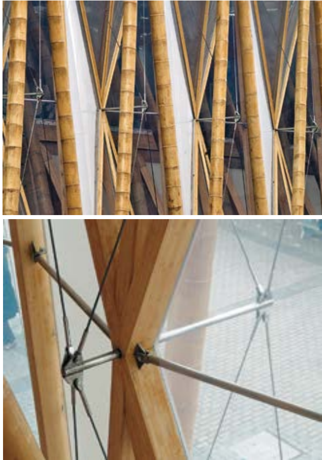
Fig. 100: En ambas imágenes se aprecia la lámina transparente de EFTE. Foto: Elaboración propia (2010)
