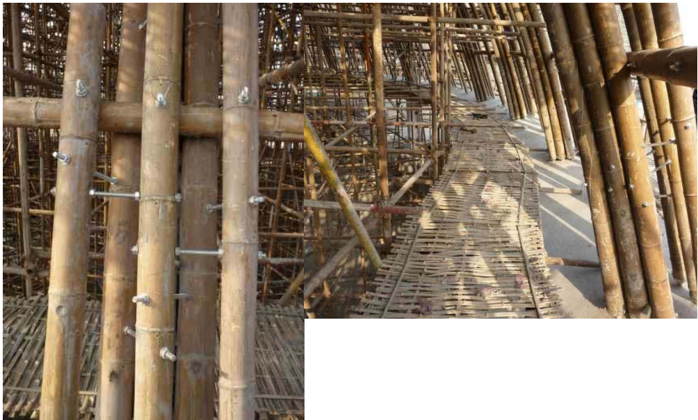
Fig. 149: Fijaciones de acero en las costillas. Fotos: Elaboración propia (2010)
