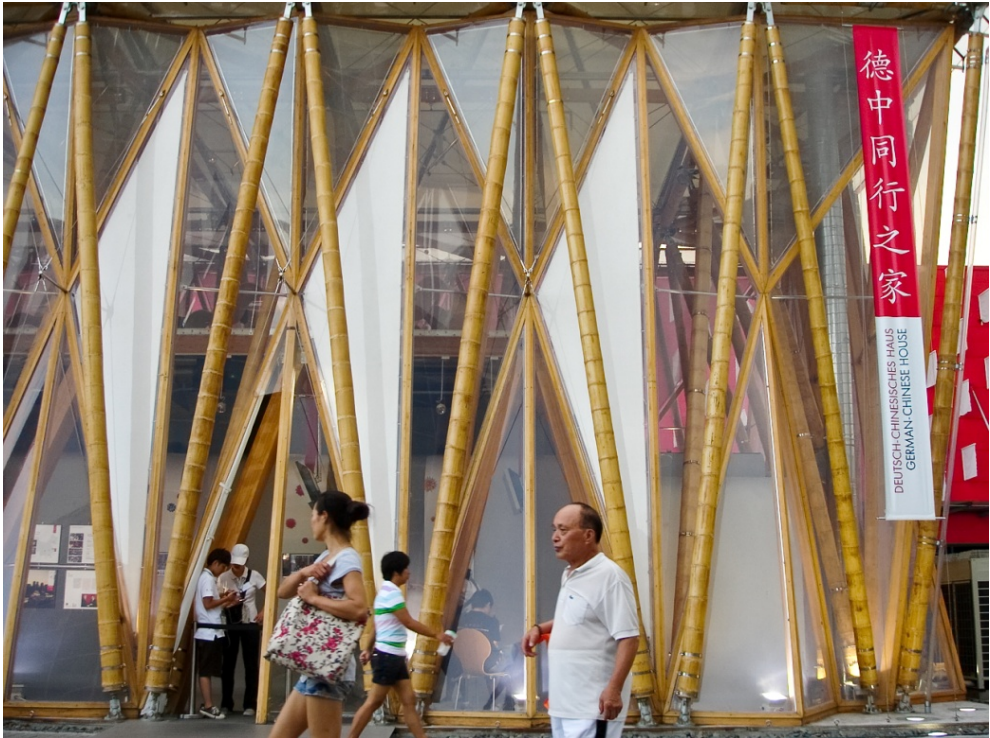
Fig. 102: Se observa una de las zonas de acceso al pabellón. Foto: Elaboración propia (2010)
