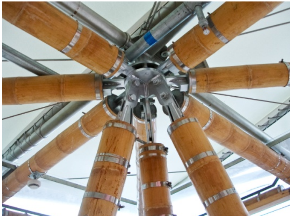
Fig. 110: Unión del bambú y acero similar a la anterior vista desde el interior del pabellón. Foto: Elaboración propia (2010)
