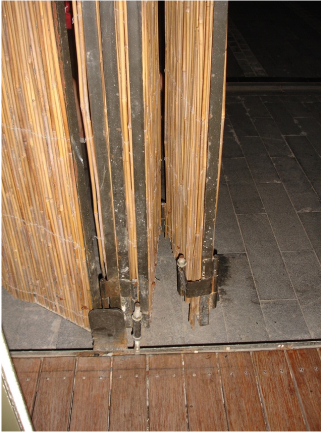
Fig. 230: Paneles de Bambú. Foto: Elaboración propia (2010)
