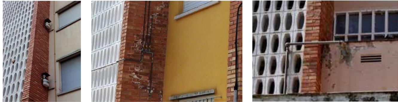
Las viviendas no tienen de origen instalación de aire acondicionado o calefacción, lo que ha motivado, debido a las malas condiciones de confort de las viviendas, la instalación de aparatos de climatización localizados en las fachadas sin ningún rigor estético, o el empleo de otros aparatos domésticos cuyo uso inadecuado puede ser causa de futuras patologías.
