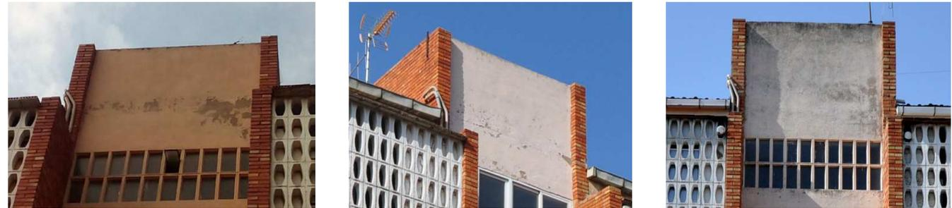
Manchas de humedad en los frentes de las cubiertas voladas situadas sobre los portales de los edificios y bajo los alféizares de las ventanas, debido a la inexistencia de goterón en las piezas de borde y/o a la poca pendiente de la cubierta.
