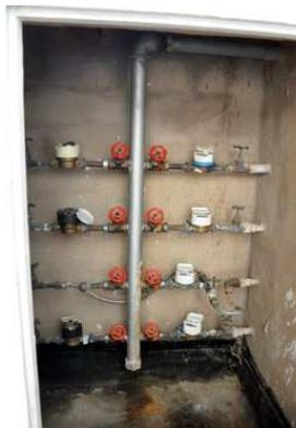
Fig. 173. Imagen de la centralización de contadores de agua en el rellano de la escalera.
