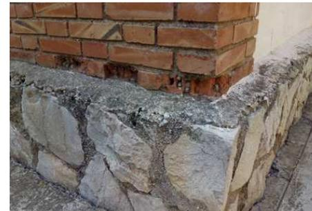
Fig. 191, 192 y 193. Imágenes de humedades sobre el muro de mampostería.
