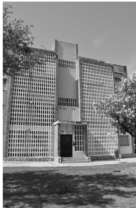
Fig. 86. Detalle del acceso a los bloques por el lado Norte u Oeste (en función del bloque). A los lados del acceso, celosía de protección formada por piezas prefabricadas de hormigón, sobre las zonas húmedas (cocina y baño) de las viviendas.
