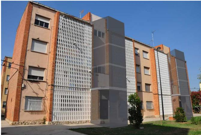
Fig. 233. Imagen del edificio con la situación de los ascensores sobre la fachada principal.
