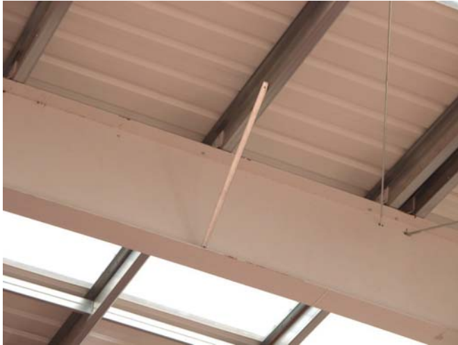
Arriostamiento desde la correa del cordón inferior comprimido de una estructura metálica y una de madera.
