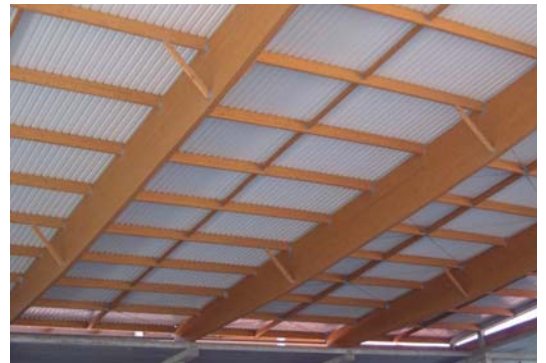
Arriostamiento desde la correa del cordón inferior comprimido de una estructura metálica y una de madera.
