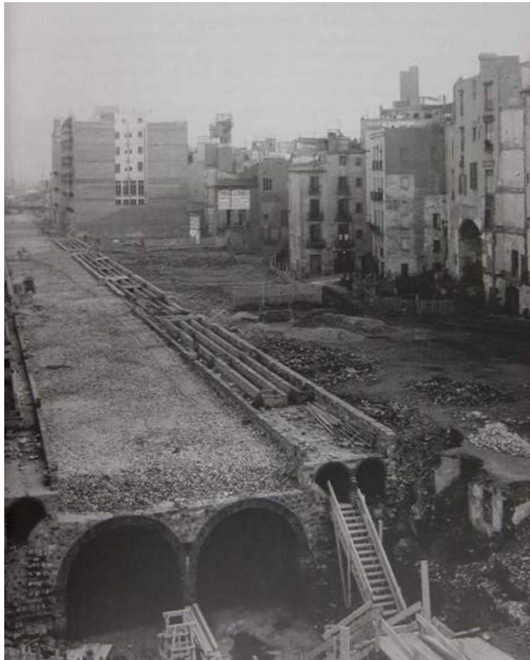
Figura 50. Imagen de las obras de apertura de la vía Laietana de Barcelona. En primer plano se aprecian las secciones del alcantarillado y del metro.
