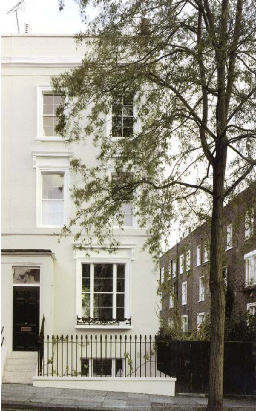
Figura 20. Casa Pawson (1997-1999). Acceso principal.
