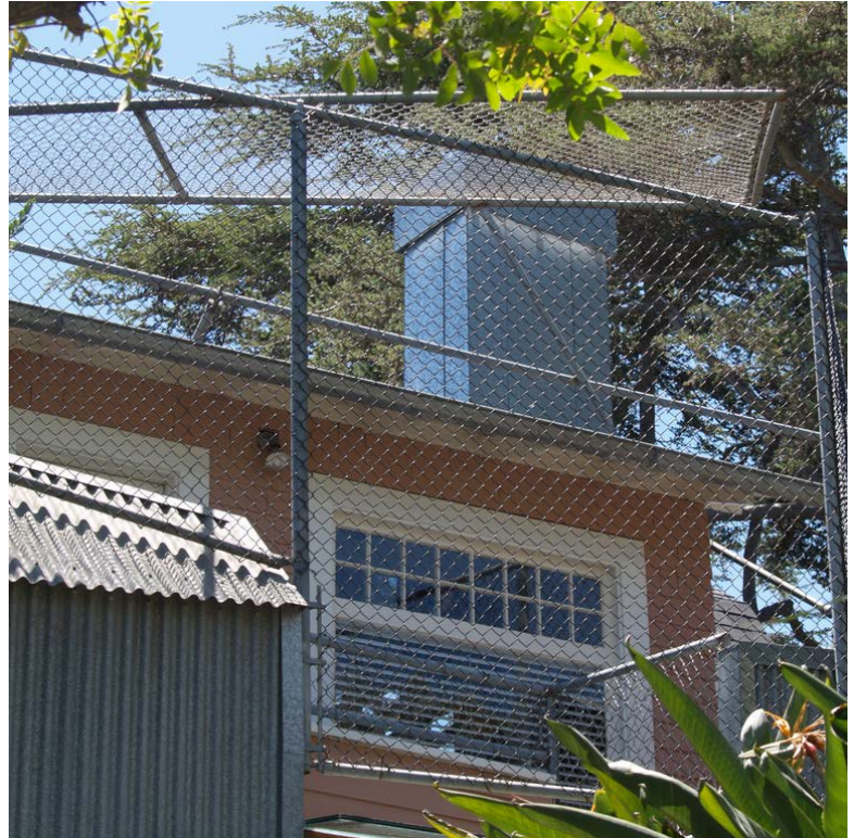
Figura 12. Detalle en el desván: acero corrugado y malla metálica.
