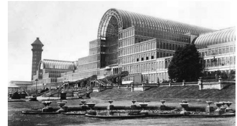
Fig.2.5. Crystal Palace para la Exposición Universal de Londres en 1851. Donde a partir de un método utilizado para la fabricación de invernaderos, el jardinero Joseph Paxton desarrolló un enorme invernadero de tres pisos con un transepto central de cubierta curva.
