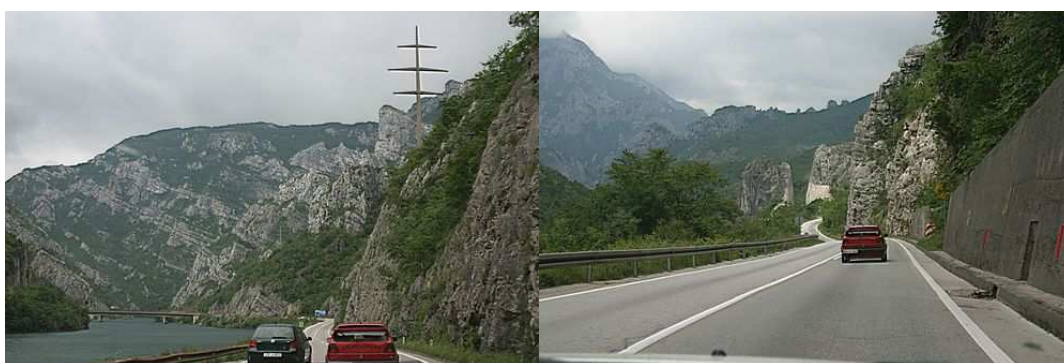
Izquierda: Carretera de Mostar a Sarajevo en Grabovica Derecha: Carretera de Mostar a Sarajevo en Salakovac
