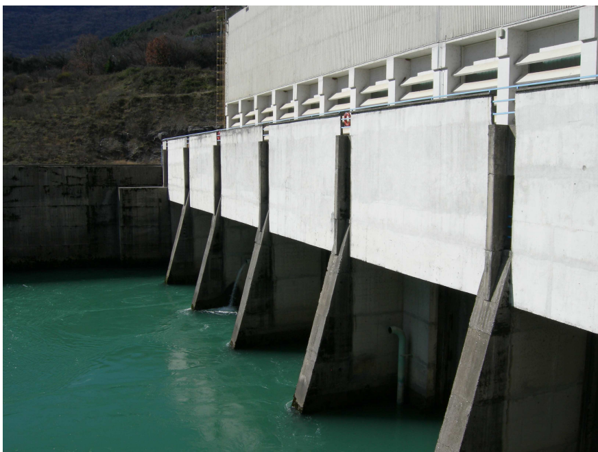
Central hidroeléctrica de Salakovac
