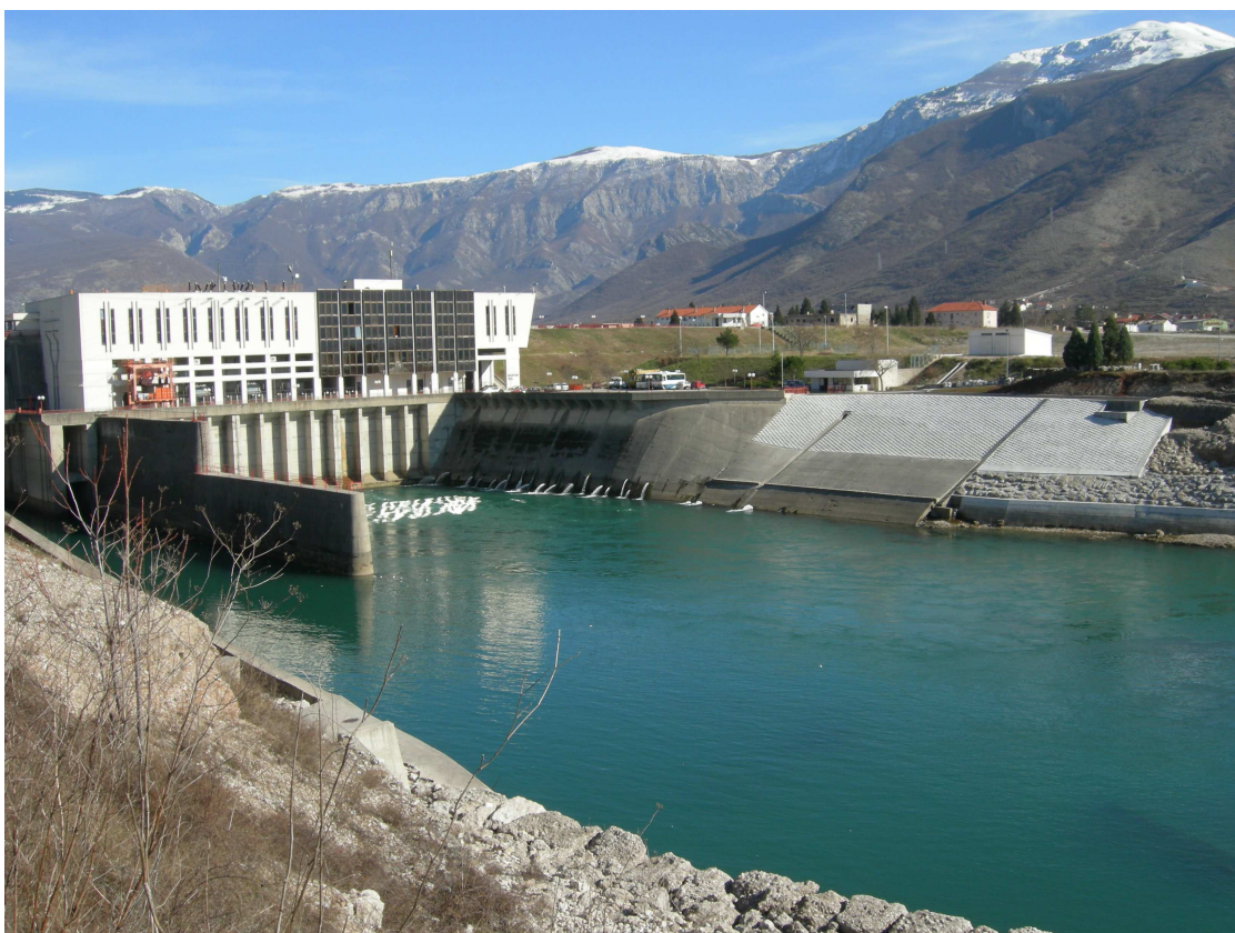
Central hidroeléctrica de Mostar
