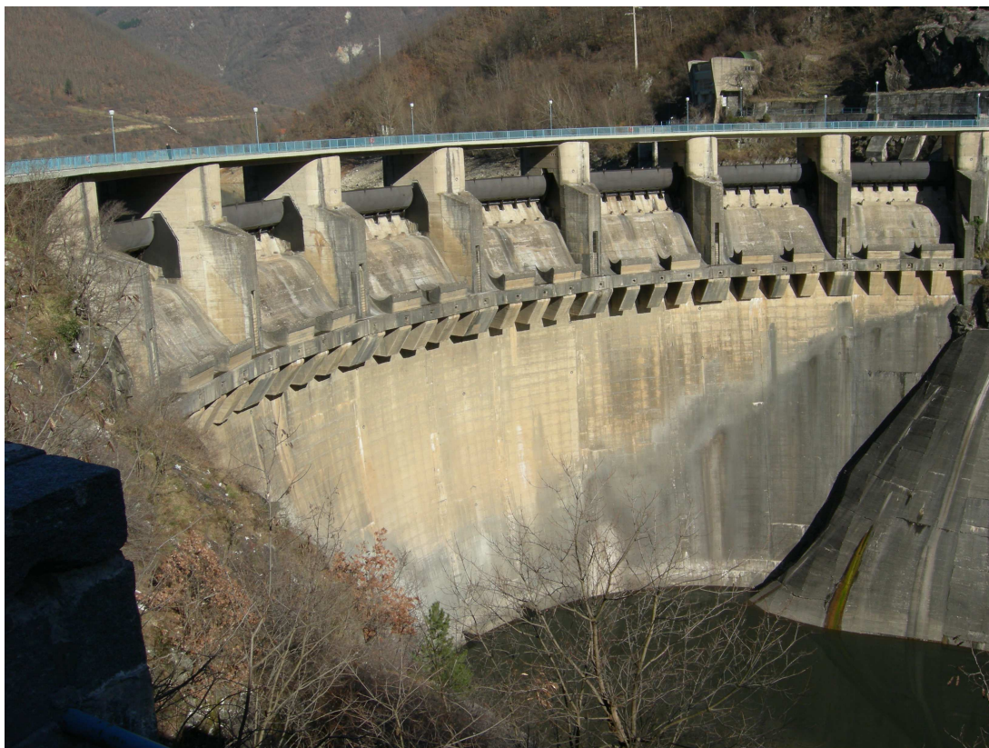
Presa de Jablanica
