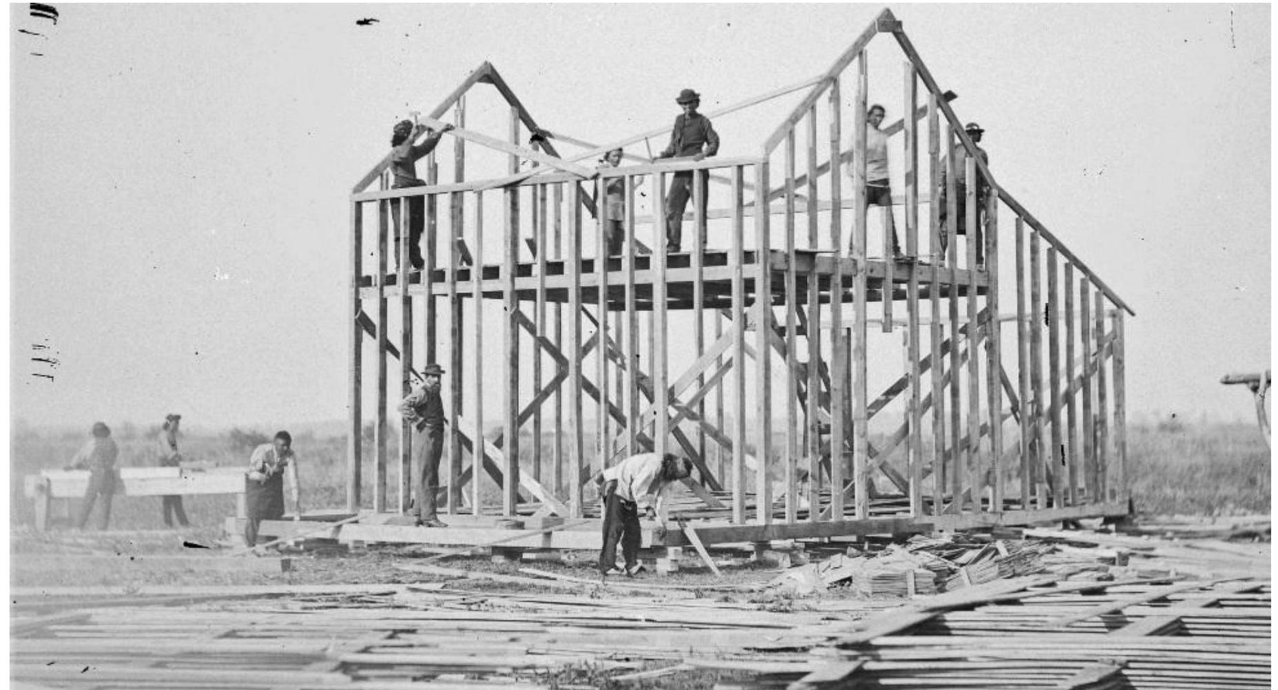
*Imagen 73. Ejecución de una vivienda con el sistema constructivo Balloon Frame*
