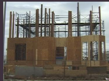
Ejecución en proceso. Planta Baja, sistema Platform Frame.
