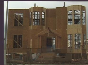
Ejecución en proceso. Planta Primera, sistema Platform Frame.
