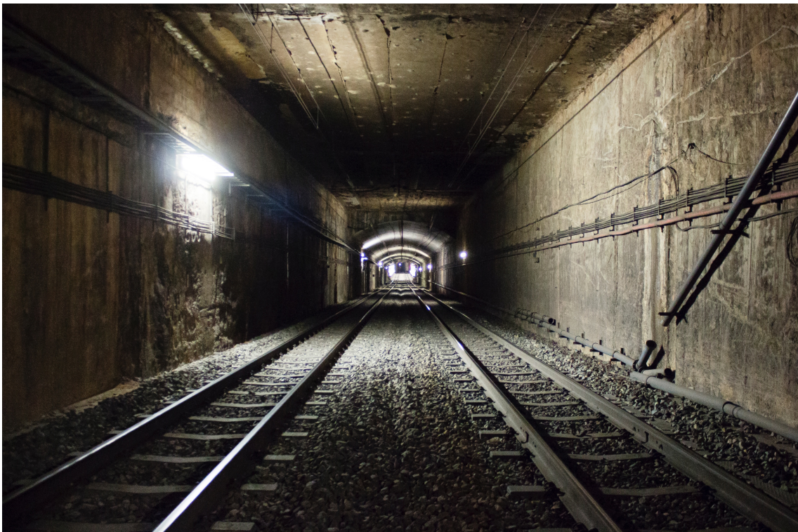
Imagen 50. Fotografía tomada en el interior de un túnel de Metro Valencia.
