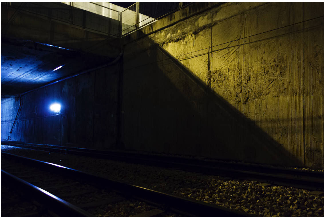
Imagen 48. Fotografía tomada en una de las entradas a un túnel de Metro Valencia.
