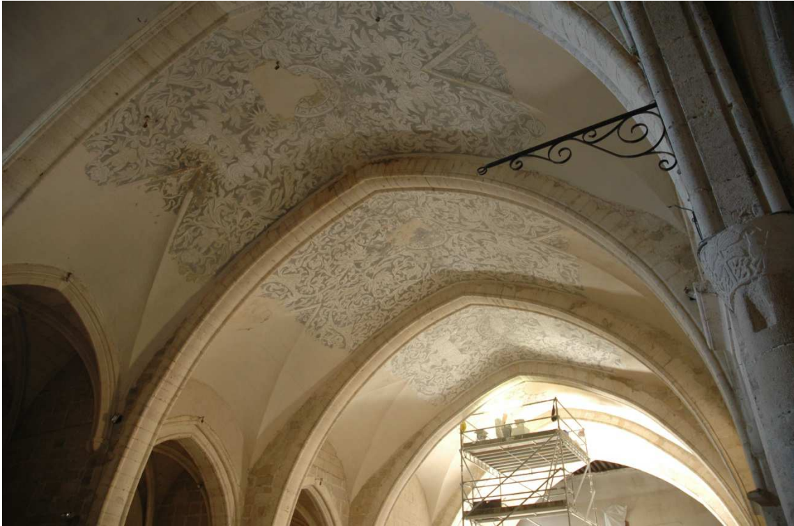
Ilustración 76: Proceso de restauración de los esgrafiados.
