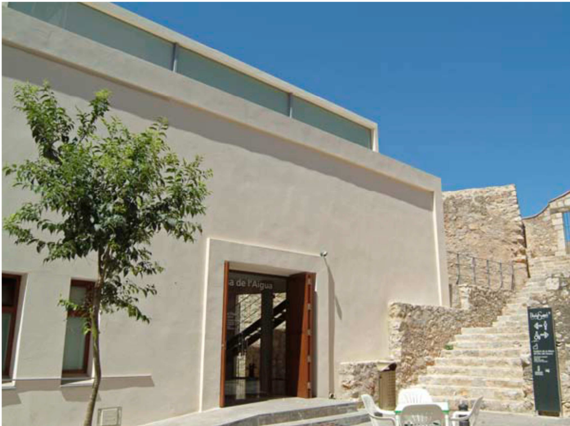
Ilustración 50: Imagen de la fachada de la Casa del Agua junto a las murallas de Peñíscola.
