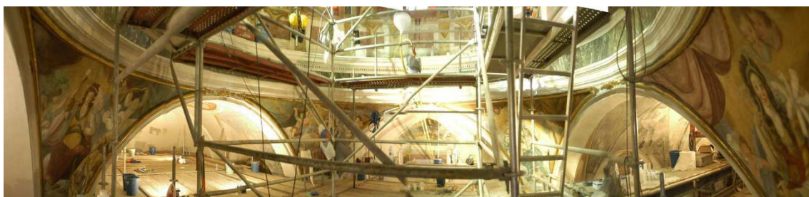
Ilustración 36: Imagen de los frescos de la Capilla de San Clemente con los andamios para su intervención
