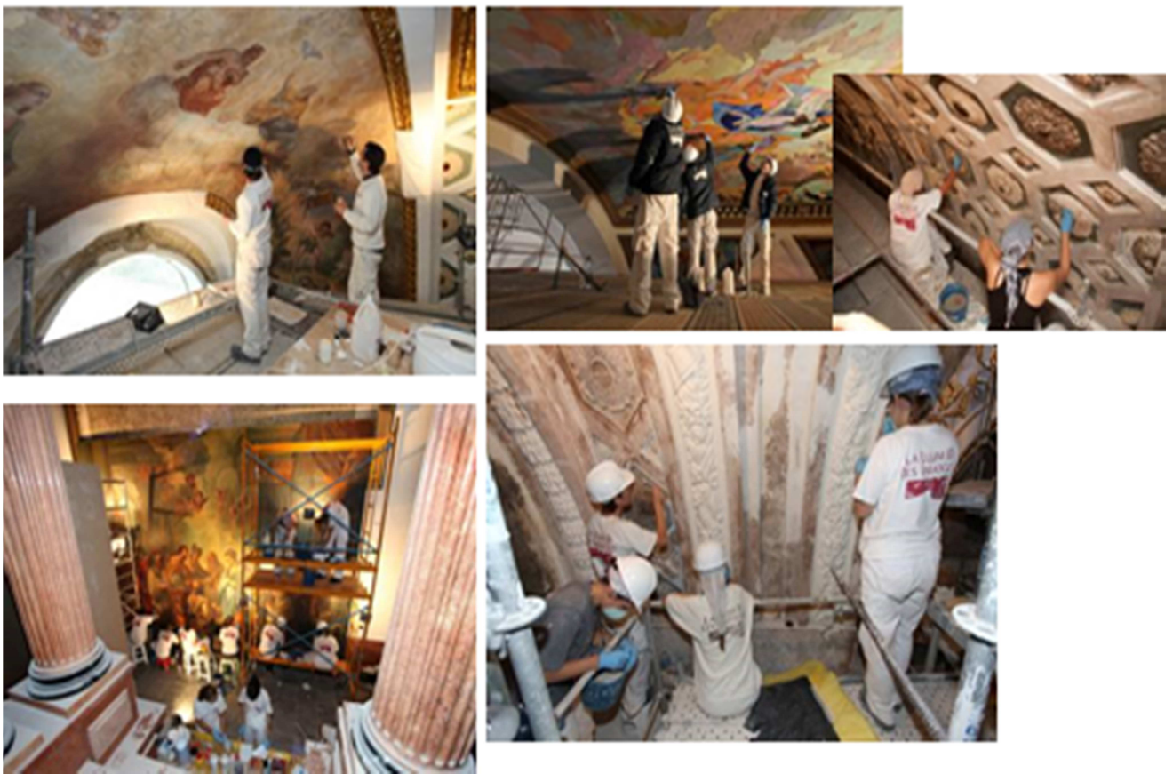
Ilustración 10: Trabajos de restauración en la decoración interior de los edificios
