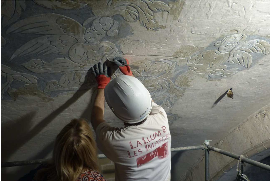
Il·lustració 75: Les primeres catas per comprovar l'estat dels esgrafiats de l'església de Catí.
