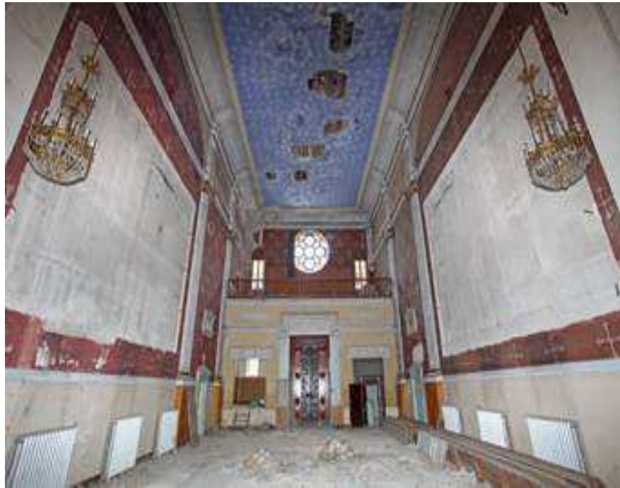
Ilustración 62: Capilla del antiguo asilo de las Hermanitas de los Pobres y Ancianos Desamparados en el estado que se encontraba antes de su restauración.
