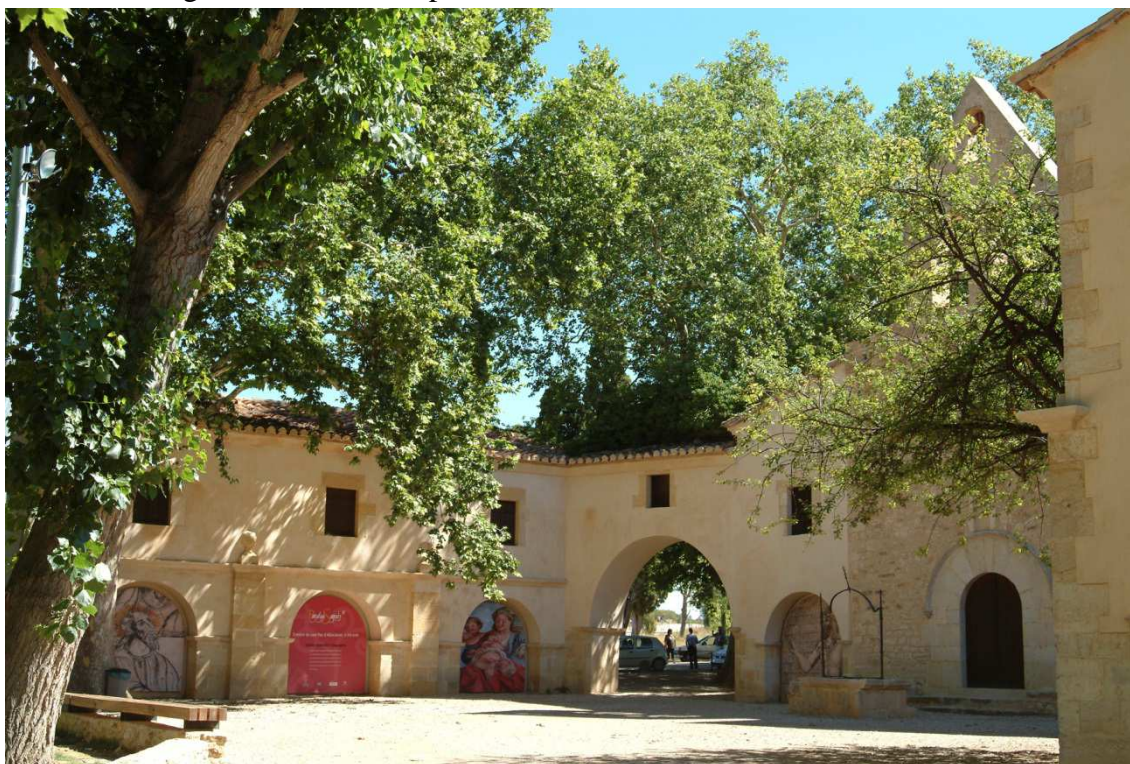
Ilustración 55: Estado final de las intervenciones en la explanada del ermitorio
