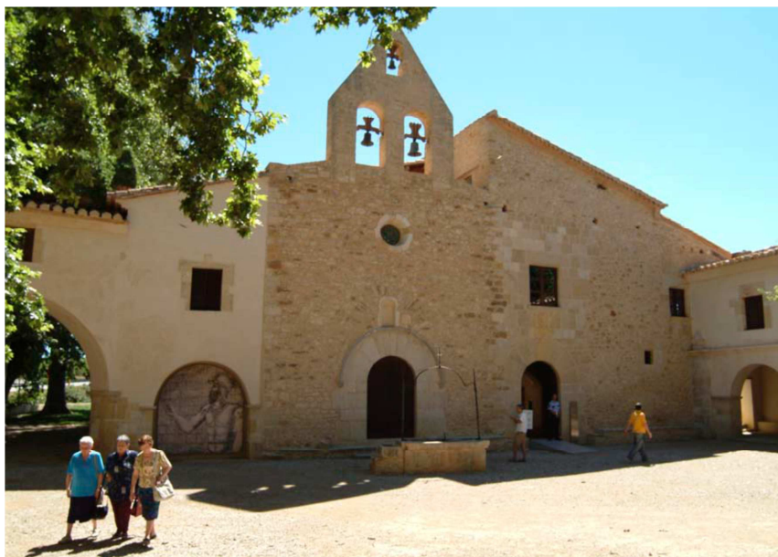
Ilustración 51: Ermitorio de Sant Pau en Albocàsser
