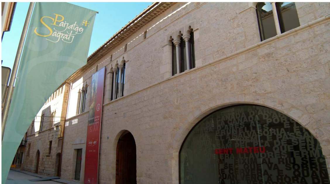
Ilustración 43: Fachada del Ayuntamiento de Sant Mateu tras su intervención
