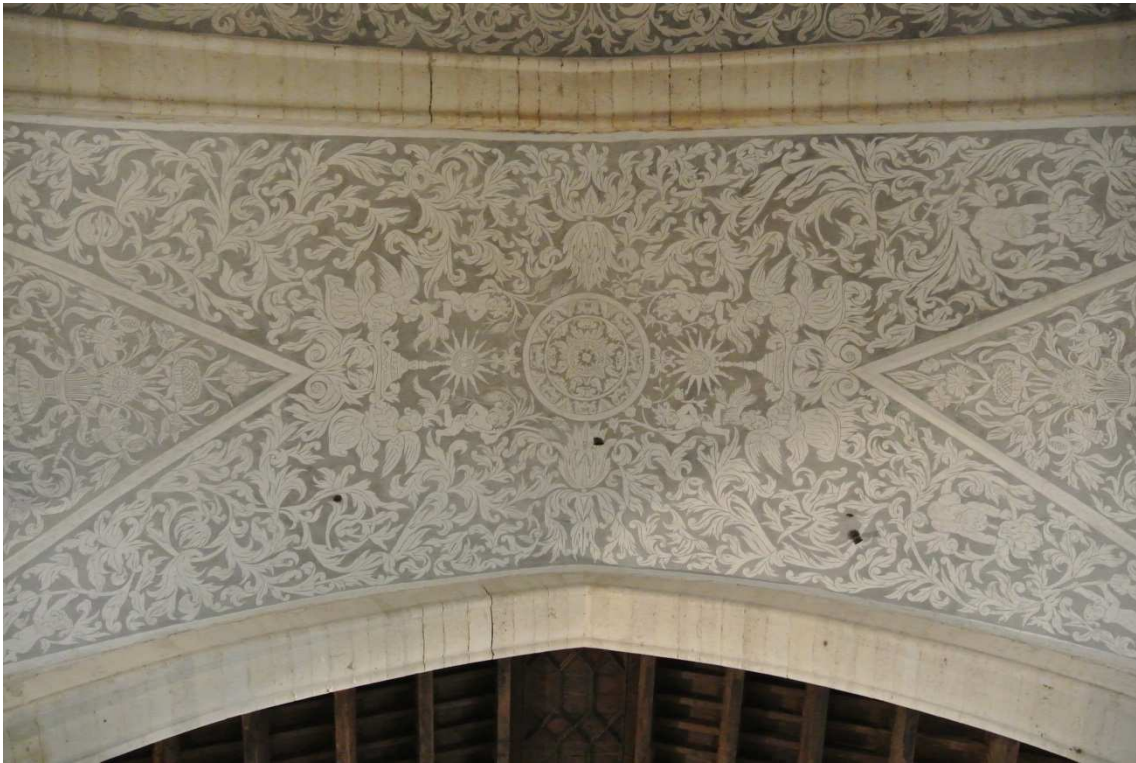
Ilustración 78: Estado final de una de las crujiás esgrafiadas.
