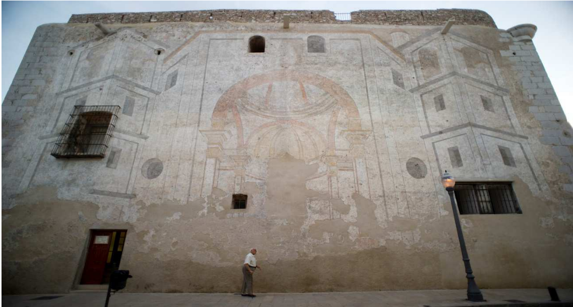
Ilustración 71: Vista de la fachada noreste tras su restauración.
