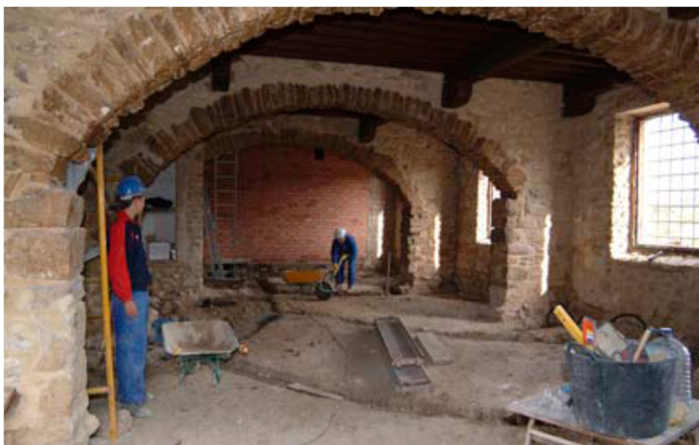
Ilustración 53. Obras de restauración en la antigua hospedería
