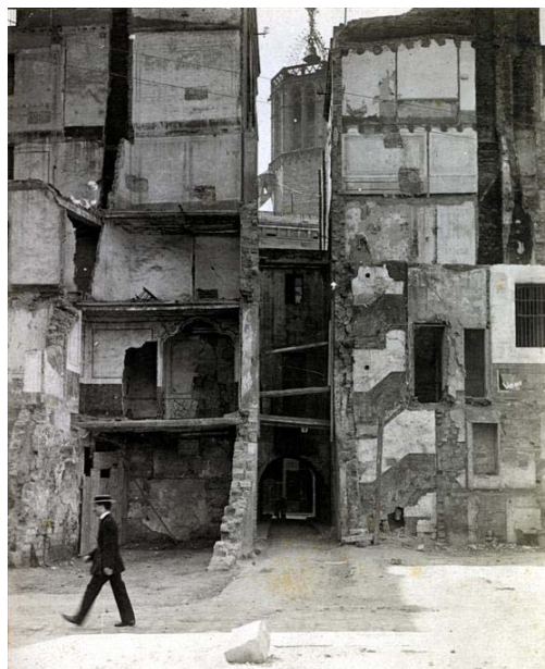
Obras de demolición. Apertura Vía Laietana Fuente: Arxiu Cerdá. F.Ballell. Obertura Vía Laietana
