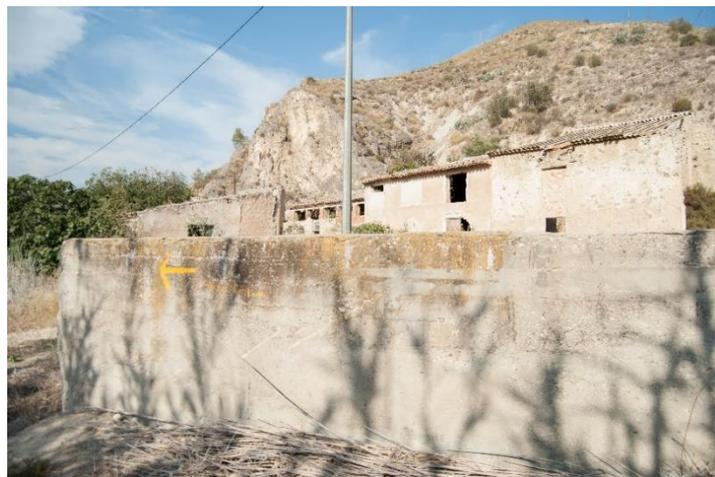
Fig. 57. Muro de la segunda balsa doble que indica su elevación sobre el terreno.
