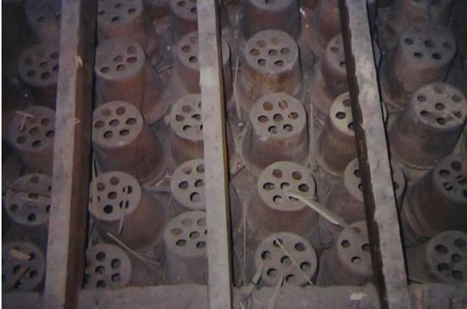
Figura 123 - Fotografía tomada en 1989. Cámara bajo el foso orquestal con las vasijas invertidas (Archivo del Área de Arquitectura de la Diputación Provincial de Valencia)
