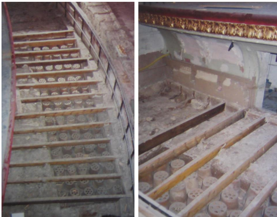
Figuras 126 y 127 - TPV. Cámara subterránea bajo el foso orquestal y vasijas cerámicas. 1989 (Archivo del Departamento de Arquitectura de la Diputación Provincial de Valencia)
