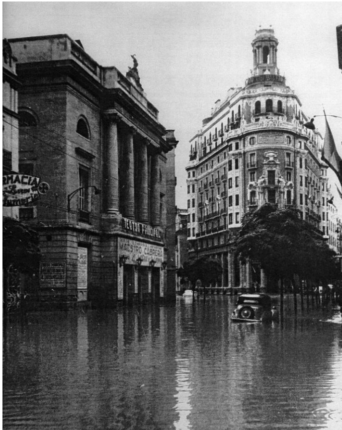
Figura 110 - Fotografía de la fachada de acceso del TPV en la calle de las Barcas, tras los efectos de la riada del año 1957
