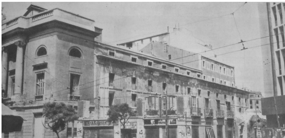
Figura 111 - Derribos de las manzanas adyacentes al teatro por ampliación de la calle del Poeta Querol. Aspecto exterior del TPV (Las Provincias, 17 de agosto de 1963)
