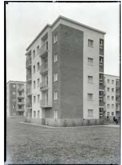
1 AGCECDFs | Escuela de aparejadores 2 | 3 | 4 | 5 | 6 AGCECDFs | Viviendas
