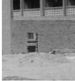
Fig. CAC.03. Se trata de una imagen del conjunto tomada desde la calle Santa María Micaela. Presenta el proyecto antes de que se construyera el edificio con el que tiene medianera, por lo que la visión del conjunto es perfecta.
