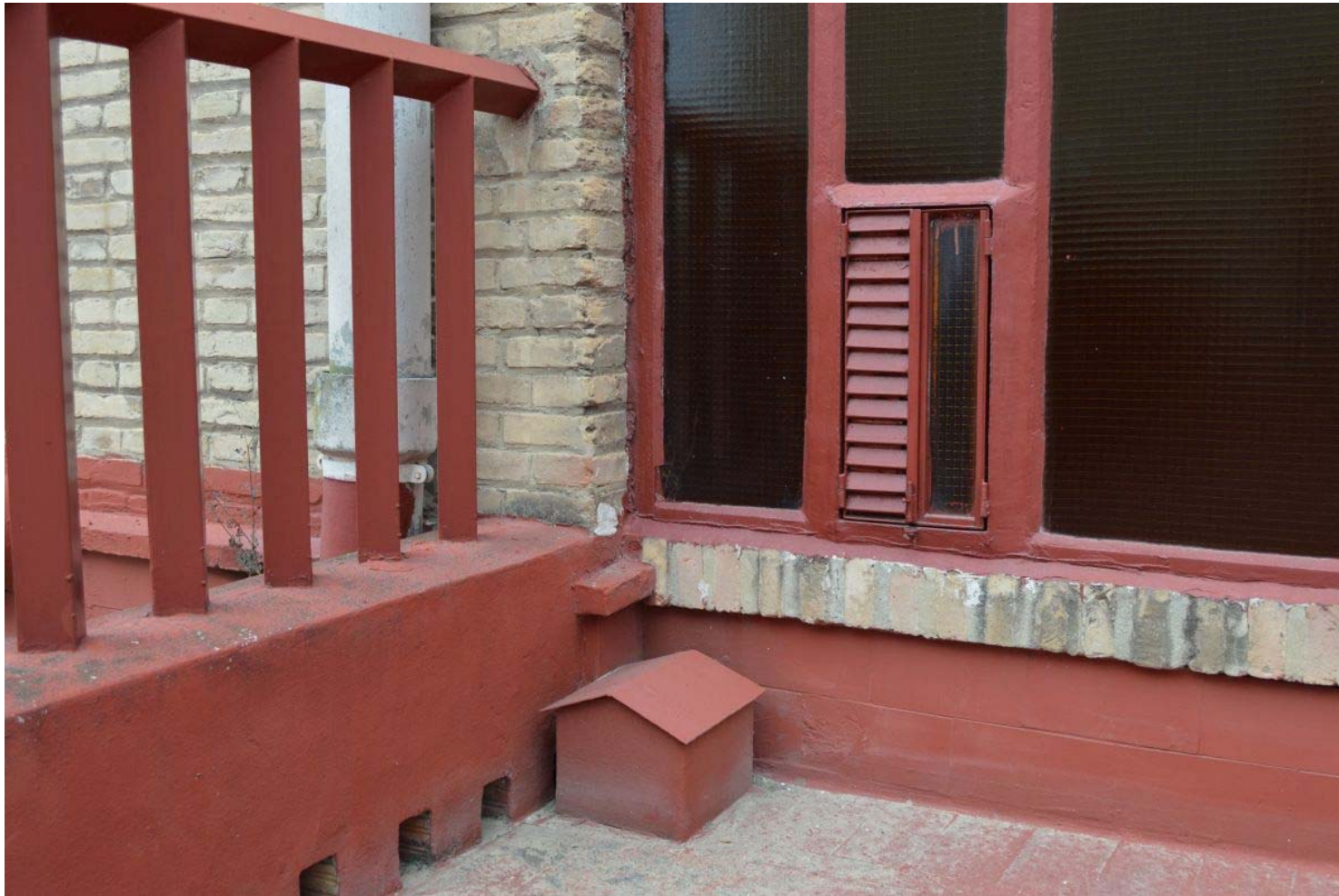
[48] V15: Planta quinta. Cubierta pisable. Detalle del encuentro entre la cubierta transitable y la pisable, del cajado metálico de protección de los huecos en forjado para descuelgue de andamiaje, del hueco de ventilación controlada del lucernario vertical, y del armado del vidrio de dicho lucernario. Nivel estructural +16,15 m. (2014). Autor: JMMN. V15.I.65.
