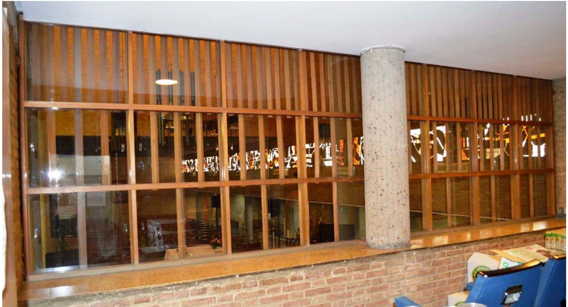
[35] V15: Planta primera. Lugar del coro y/o de los niños. Nivel estructural +3,57 m. (2014). Autor: JMMN. V15.I.51.
