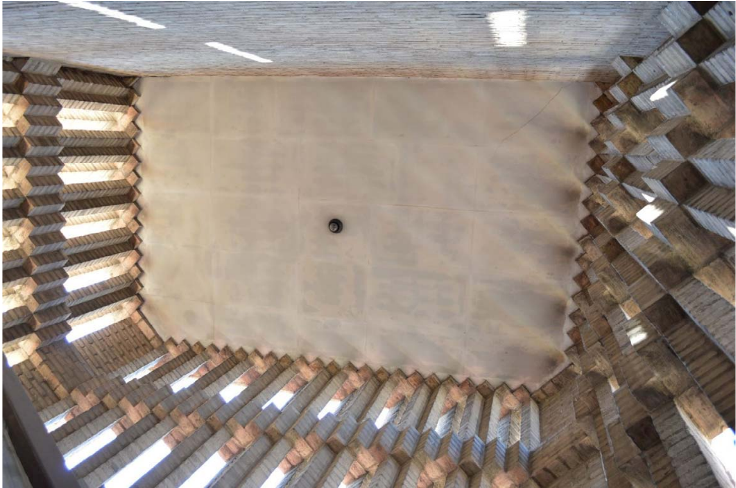
[60] V15: Descansillo entre las plantas, sexta y séptima. Vista cenital de la celosía de ladrillo del campanario. Nivel estructural +20,74 m. (2014). Autor: JMMN. V15.I.84.
