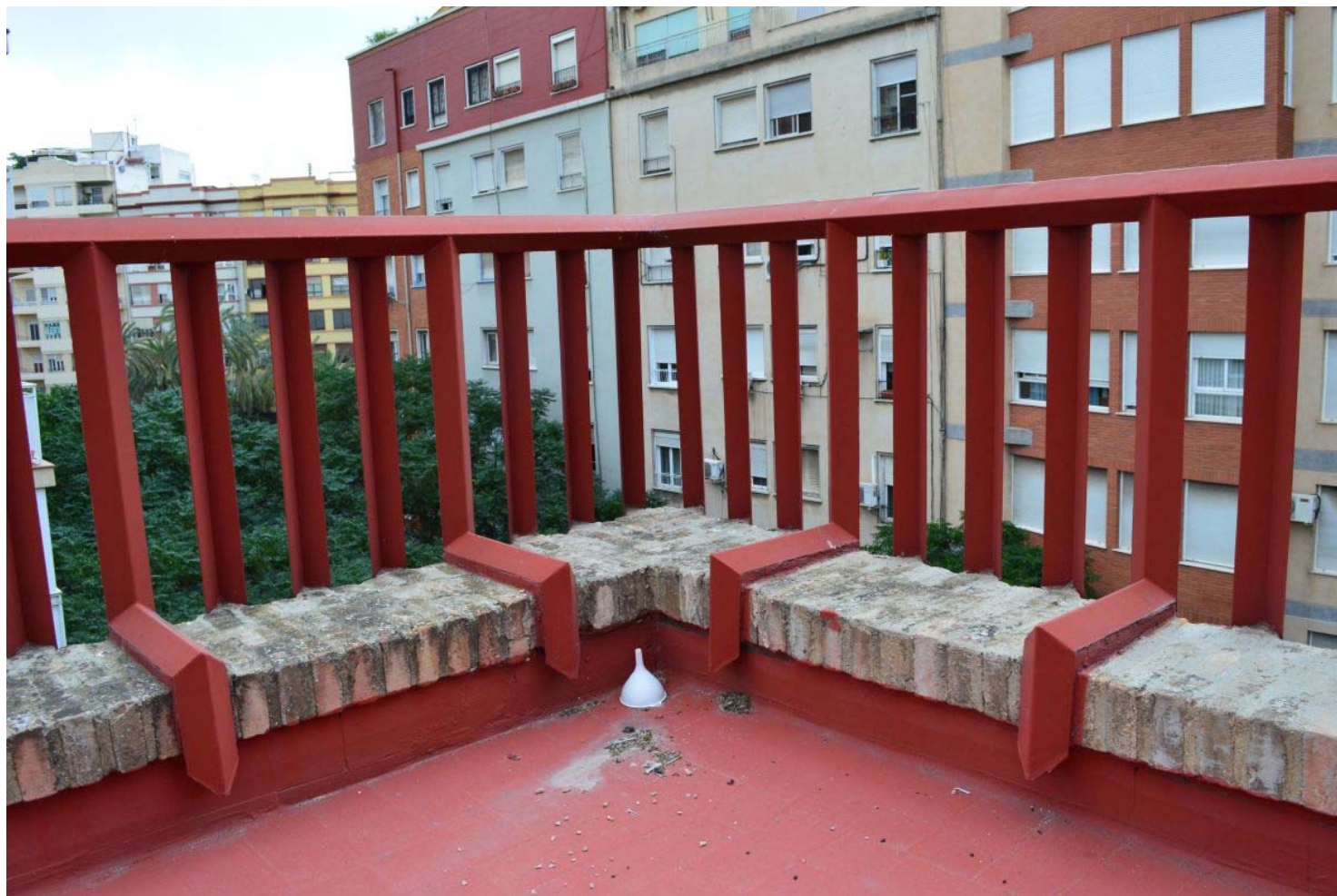
[46] V15: Planta quinta. Cubierta transitable. Detalle de la esquina de la celosía metálica, recayente a la calle E. J. Capuz, y a la calle Romeral. Nivel estructural +16,15 m. (2014). Autor: JMMN. V15.1.63.
