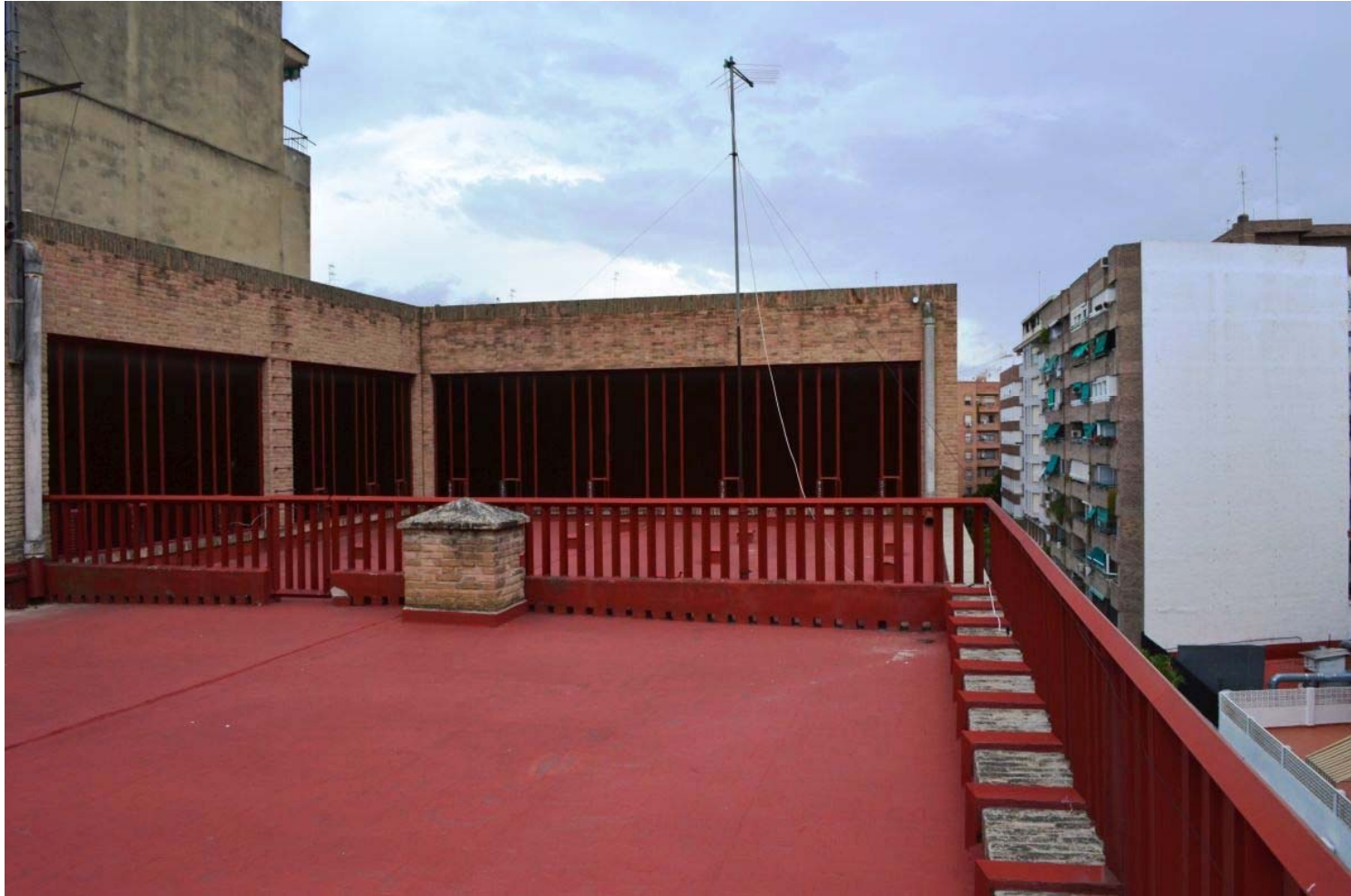
[45] V15: Planta quinta. Cubierta transitable, recayente a la calle E. J. Capuz, y en esquina con la calle Romeral. Vista hacia el lucernario vertical sobre el presbiterio y la calle Romeral. Nivel estructural +16,15 m. (2014). Autor: JMMN. V15.I.62.
