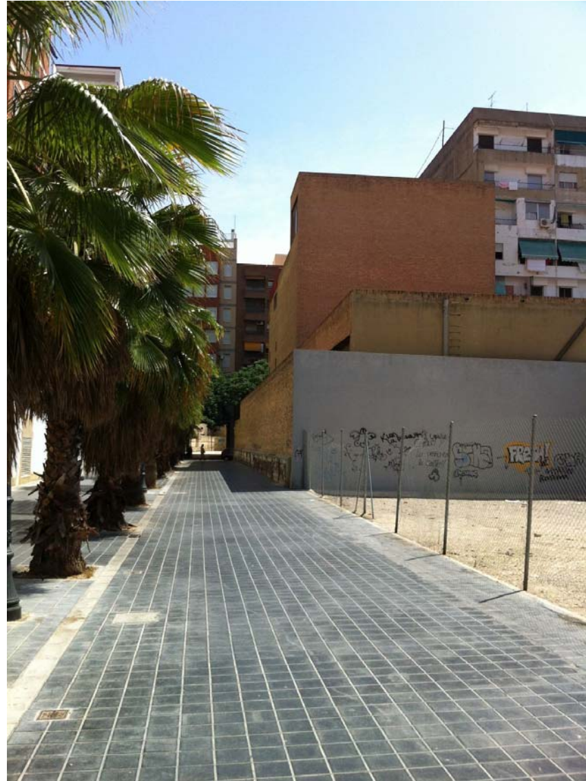
[2] V15: Vista exterior del templo construido desde la calle Romeral. Nivel estructural 0,00 m. (2013). Autor: JMMN. V15.I.02
