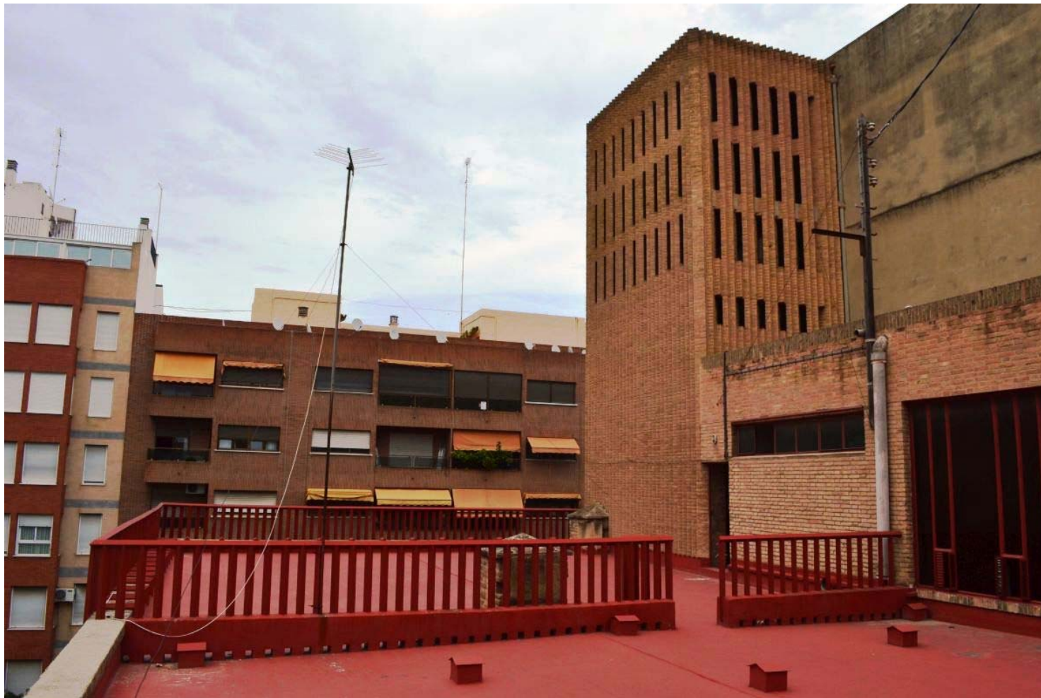
[44] V15: Planta quinta. Cubierta transitable, recayente a la calle E. J. Capuz, y en esquina con la calle Romeral. Vista hacia la torre del campanario. Nivel estructural +16,15 m. (2014). Autor: JMMN. V15.I.60.
