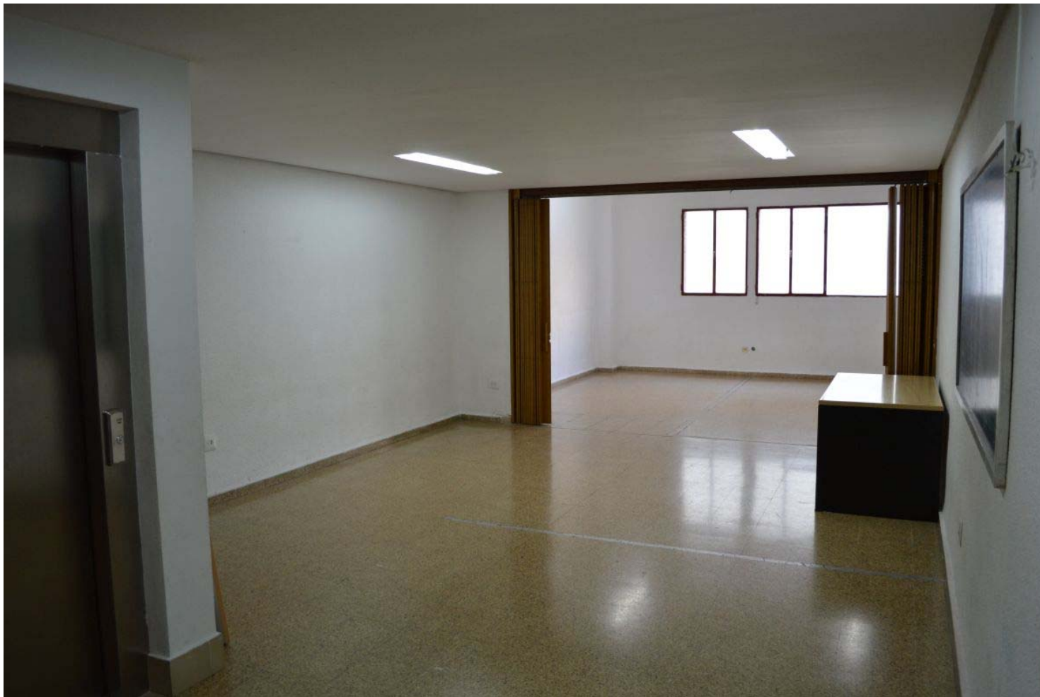
[40] V15: Planta cuarta. Estancia bajo cubierta transitable, desde su acceso y el ascensor. Vista hacia fachada recayente a la calle Romeral. Nivel estructural +13,09 m. (2014). Autor: JMMN. V15.I.56.
