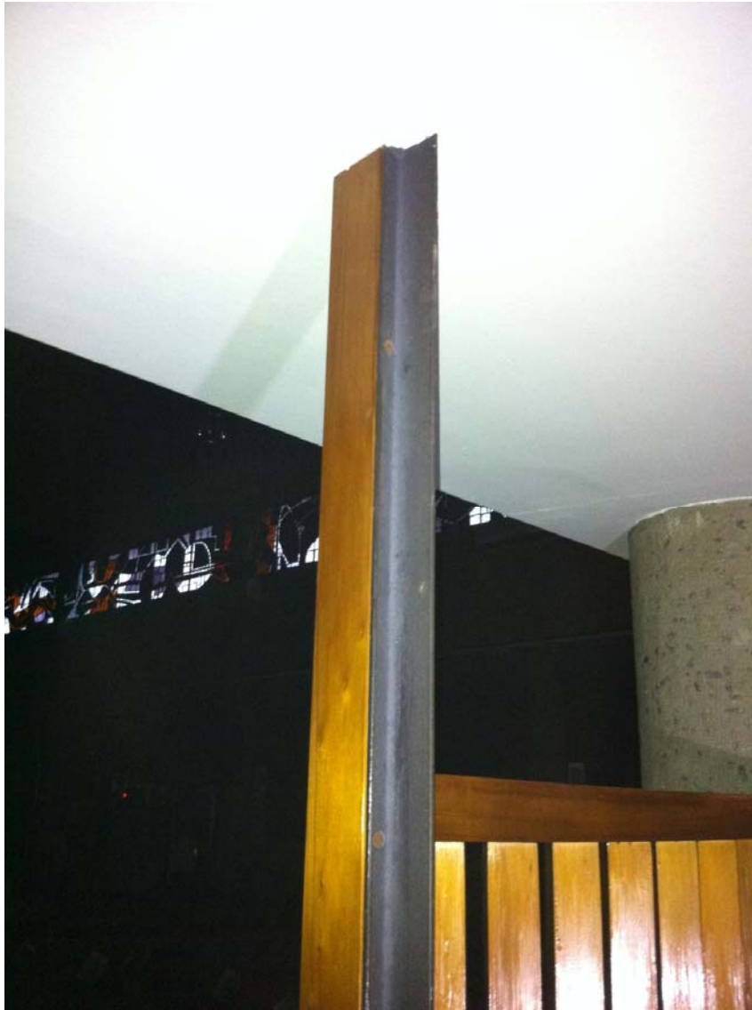
[25] V15: Planta baja. Zona penitencial desde el confesionario, y detalle de sustentación de la celosía de madera. Nivel estructural +0,68 m. (2013). Autor: JMMN. V15.I.39.
