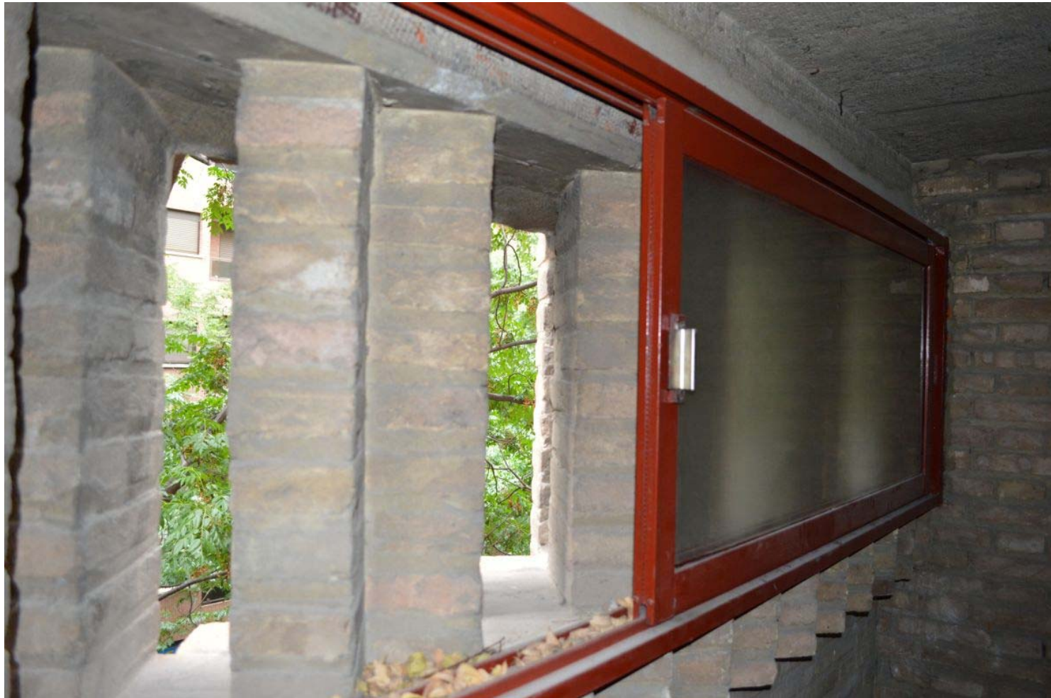
[53] V15: Descansillo entre las plantas, cuarta y quinta. Hueco vertical acristalado, tras celosía de ladrillo. Nivel estructural +14,62 m. (2014). Autor: JMMN. V15.I.74.
