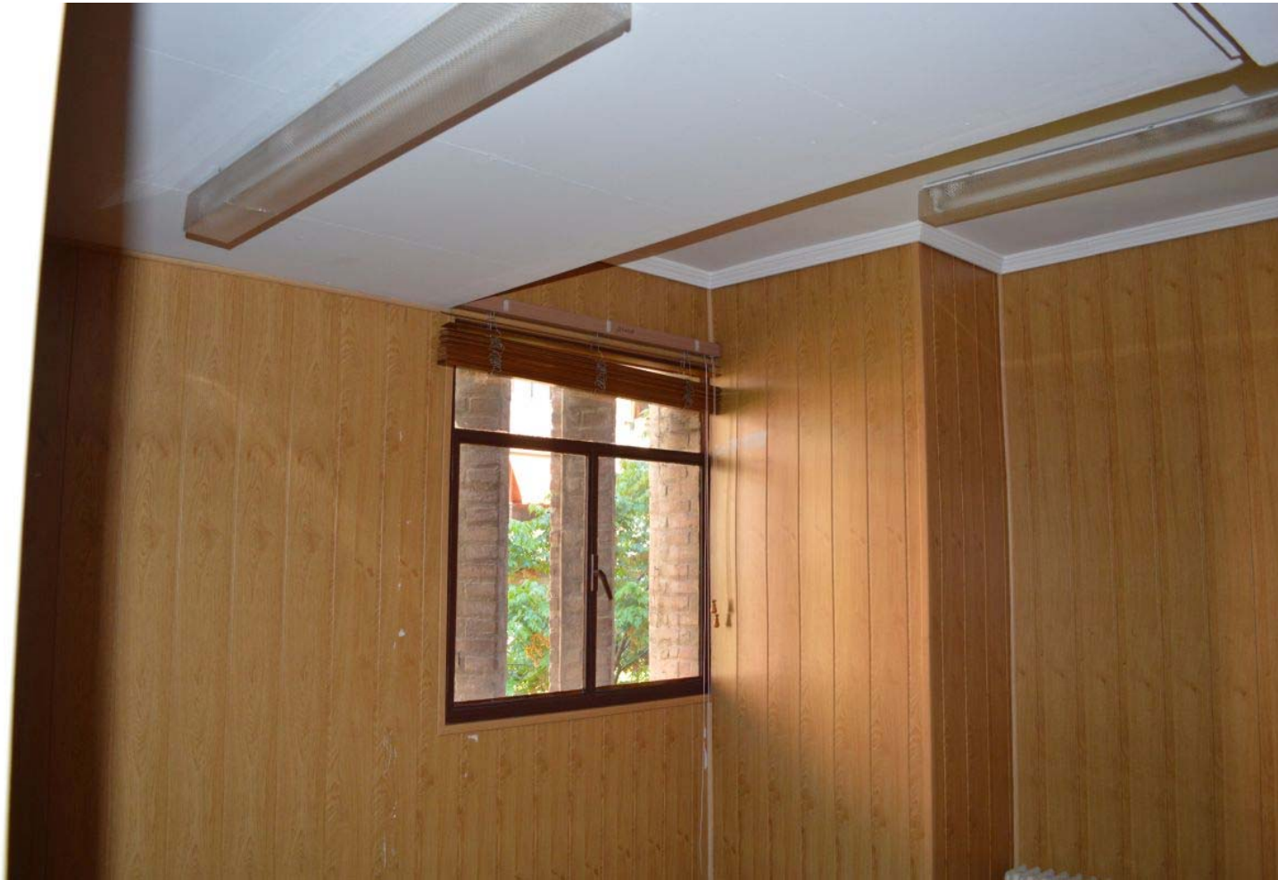
[42] V15: Planta cuarta. Estancia bajo cubierta transitable, junto a la escalera, y recayente a la calle E. J. Capuz. Nivel estructural +13,09 m. (2014). Autor: JMMN. V15.I.58.
