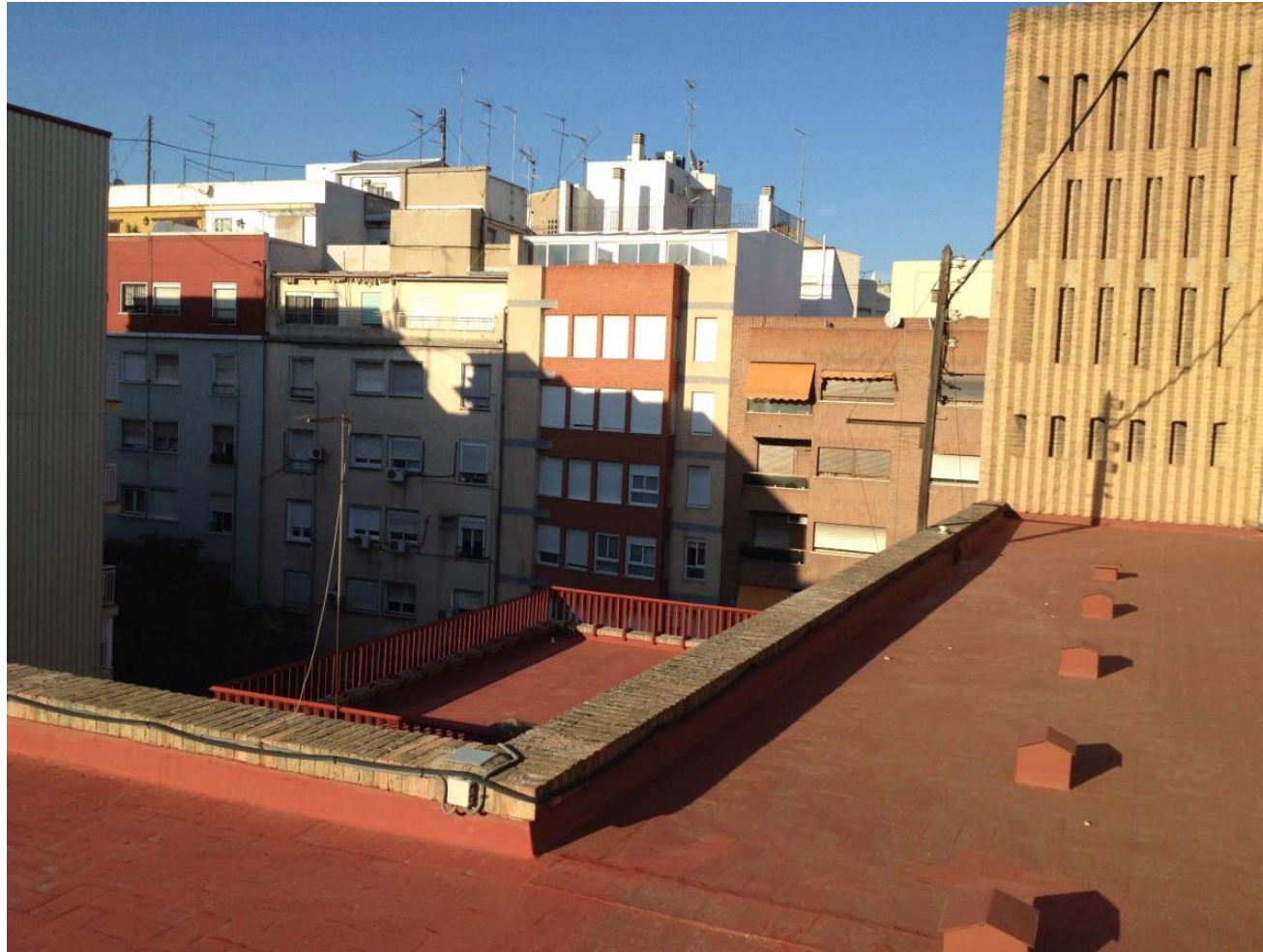
[61] V15: Planta sexta. Cubierta pisable. Vista hacia la torre del campanario. Nivel estructural +20,03 m. (2014). Autor: JMMN. V15.1.85.
