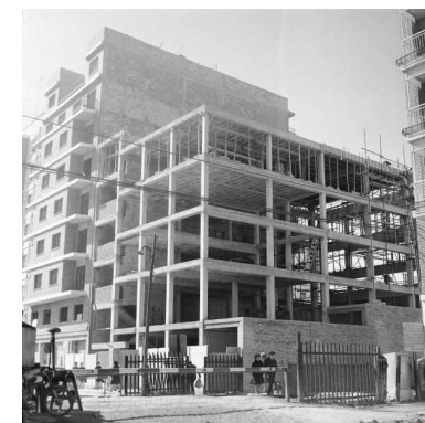
[12] V12: Vista exterior durante el proceso constructivo. VM/F0144_C33.1.6.
