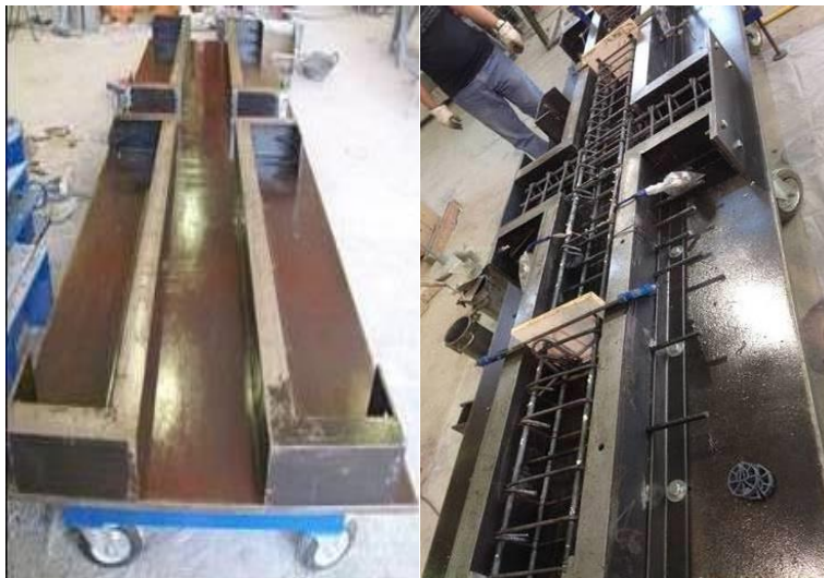
Figura V.27. Vista del encofrado del soporte antes y después de introducir la ferralla del elemento
