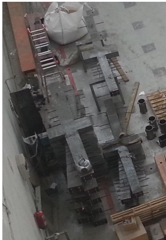
Figura V.48. Vista de la zona de acopio de soportes ensayados
