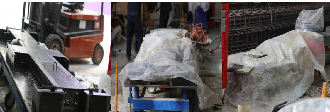
Figura V.32. Hormigón fresco en soporte. Curado del elemento y de las probetas de control
