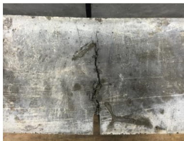
Figura V.37. Vista de la entalla realizada
