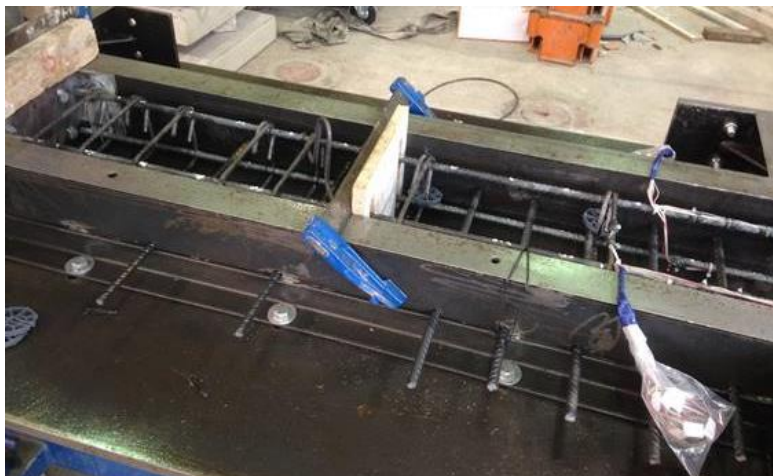
Figura V.24. Detalle de chapa de encofrado perforada. Vista de barras pasantes auxiliares
