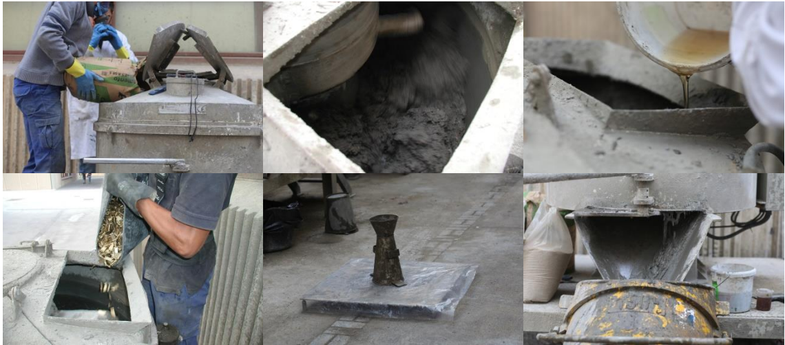
Figura V.30. Vistas de las distintas etapas de amasado. Aporte de las materias primas y amasado de la mezcla, control de la consistencia mediante ensayo de escurrimiento y vertido en cazo para su transporte
