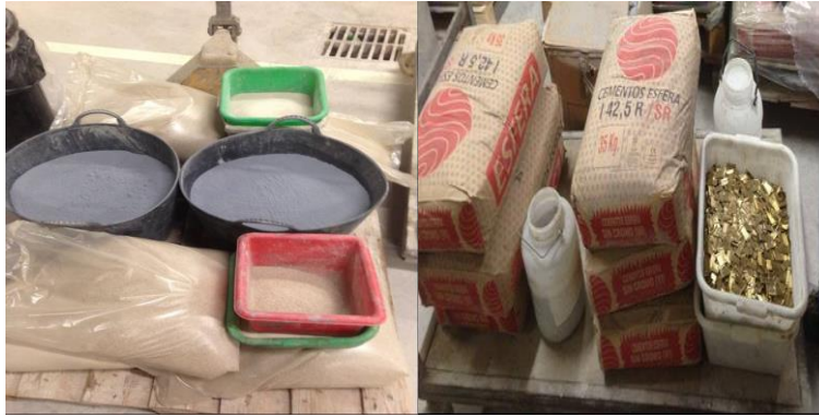
Figura V.28. Material sólido pesado según dosificación preparado para fabricar el hormigón
