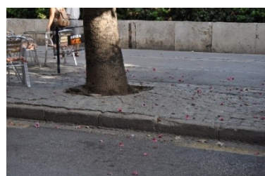
Fuente 69. Distintos acabados de aceras y pavimentos.
