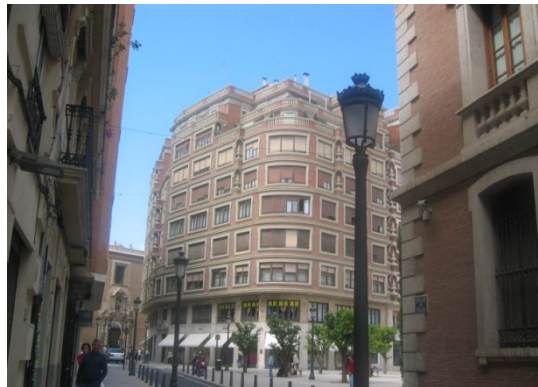
Fuente 121. Calle Salvá Fachada lateral de la Universidad.
