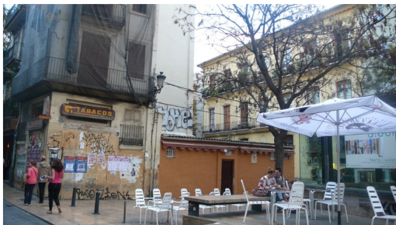
Fuente 157. Cableado aéreo.
