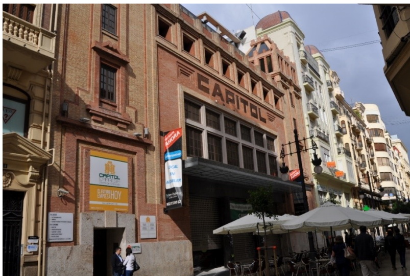
Fuente 84. Antiguo Cine Capitol en la Calle Ribera. La intervención en este inmueble mantuvo la fachada y primera crujía de la edificación original. Barrio de Universitat Sant Francesc.
