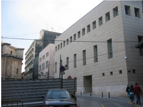
Fuente 8. Calle del Salvador. Espacio vacío frente a edificios de las Cortes. Barrio de la Seu Xerea
