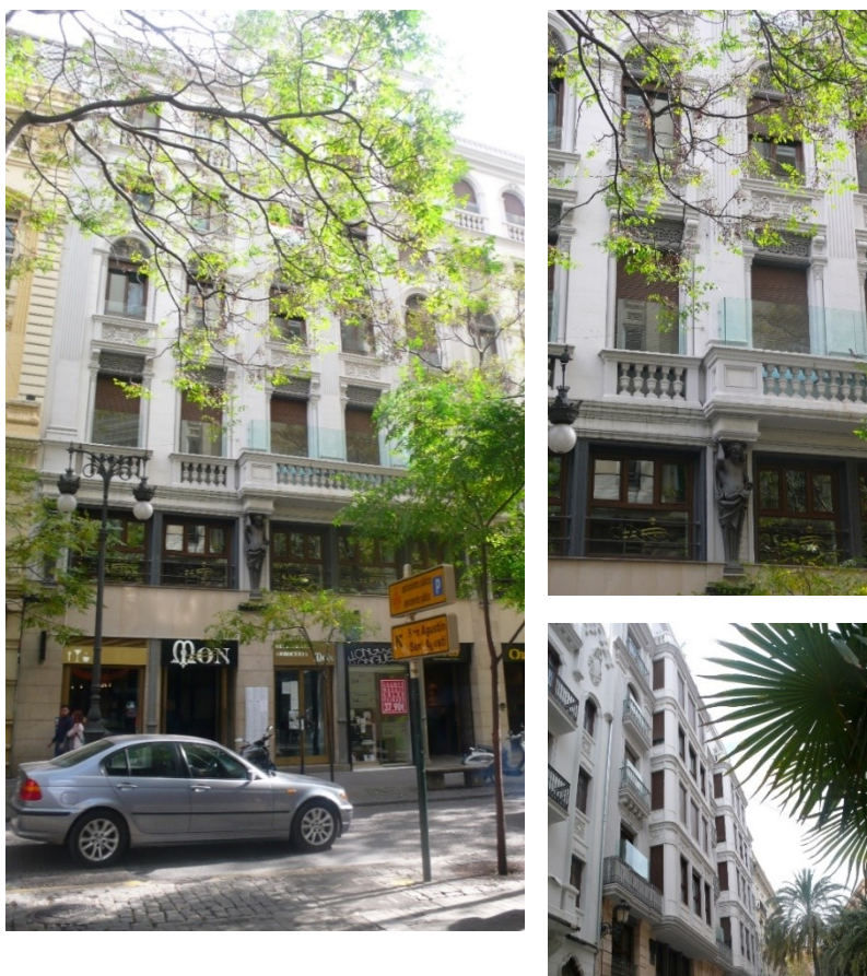
Fuente 91. Calle San Vicente y plaza Mariano Benlliure, 8. Barrio de Universitat Sant Francesc. Vaciado con mantenimiento de fachada. La estructura horizontal de la nueva construcción no respeta el orden de compositivo de la fachada
