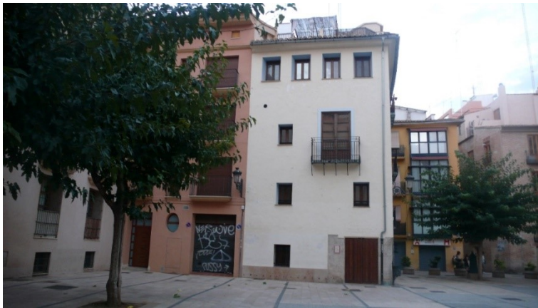
Fuente 130. Plaza del Pilar, mirando a la Calle Horno del Hospital
