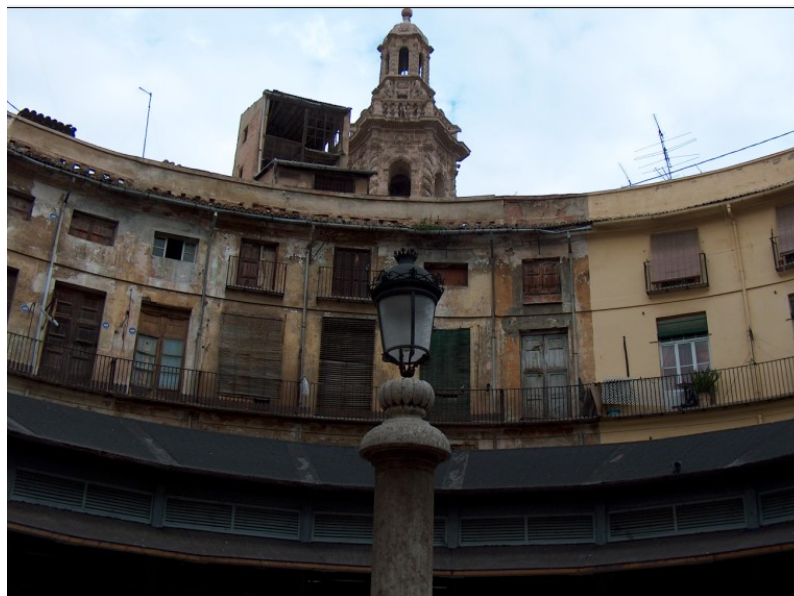
Fuente 141. Plaza Redonda. Vista de la Torre de Santa Catalina, previa a las obras de intervención.
