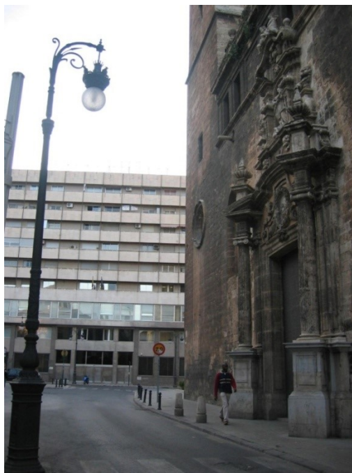
Fuente 3. Calle de la Paja, fachada Iglesia de los Santos Juanes o de San Juan del Mercado, frente a Plaza de Brujas, barrio del Mercat y barrio de Velluters, Valencia. Incorporación de nuevo estilos arquitectónicos en el Centro Histórico Protegido.
