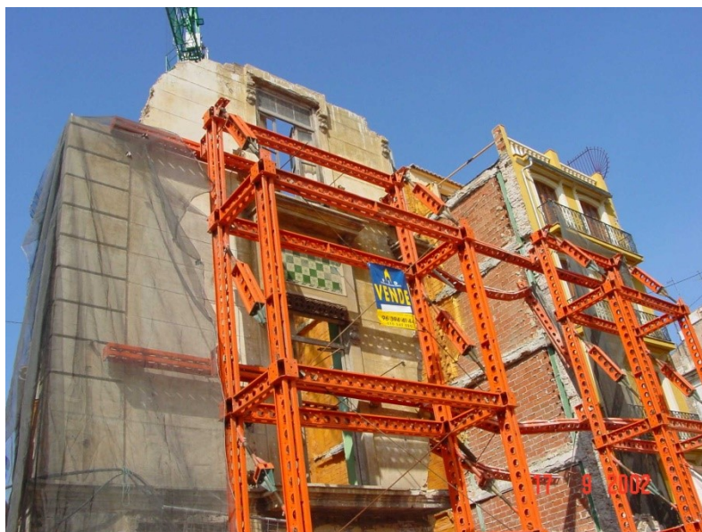
Fuente 85. Vaciado interior del edificio de la calle Santa Teresa, 9. Barrio de Velluters. Mantenimiento de su fachada mediante andamiaje.
