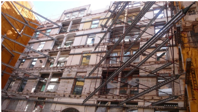
Fuente 86. Vaciado interior del edificio de la Plaza Benlliure, 8 vinculado a la calle San Vicente. Barrio Universitat Sant Francesc. Mantenimiento de su fachada mediante andamiaje
