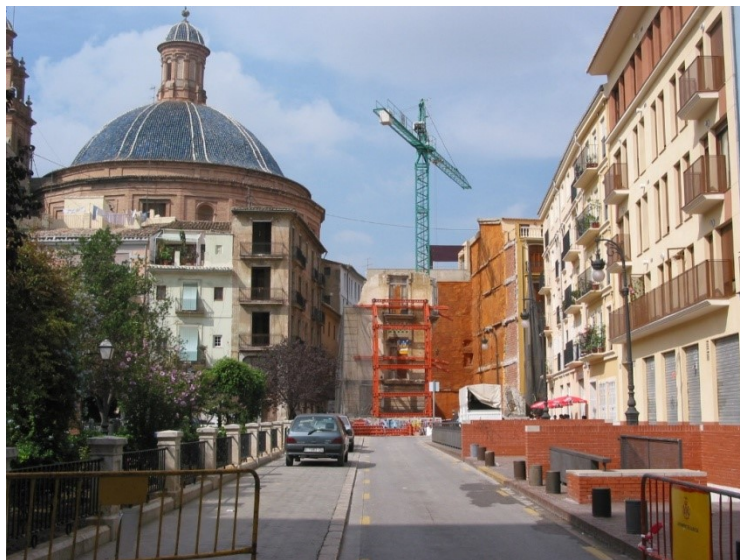
Fuente 22. Autor: Inspección de Patrimonio. Dirección Territorial de Cultura. Plaza Juan de Vilarrasa. Edificio de la calle Santa Teresa, 9, Barrio de Velluters, Valencia. Durante la obra, mantenimiento de parte de la fachada. Entorno de protección de la Iglesia de las Escuelas Pías.
