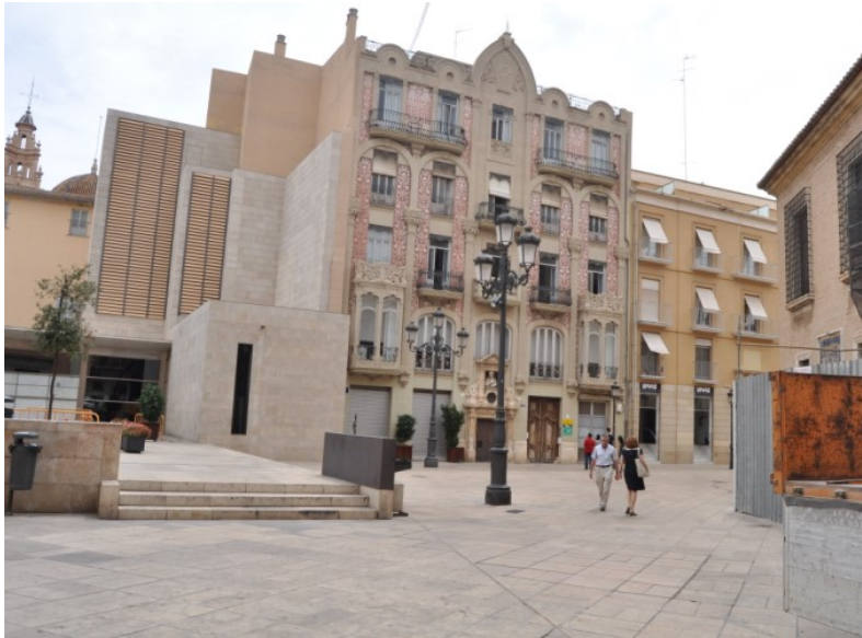
Fuente 95. Plaza de la Almoína, edificio Punt de Ganxo.
