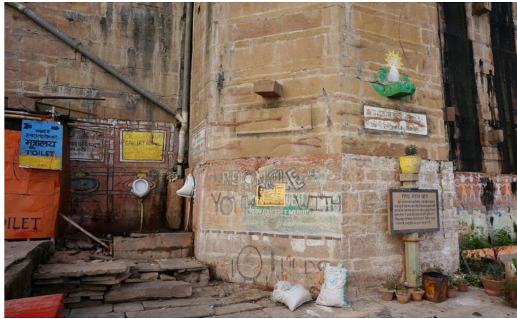
Wall of Creation. Proyecto llevado a cabo por Ravi, en el que convierte un largo muro usado indiscriminadamente como urinario en un espacio intervenido artísticamente con interés de consciencia social y criterios comprometidos de desarrollo del proyecto.
