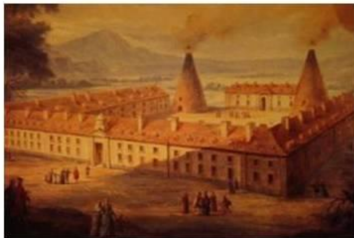
Cristalería de la Reina en Le Creusot. Hornos de sistema en cono.
