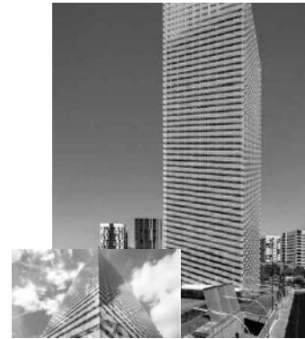
Torre Puig, Hospitalet de Llobregat, España
