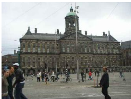
Fachada del Ayuntamiento de Amsterdam, Países Bajos
