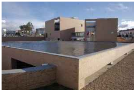
Sede Confederación Hidrográfica del Guadiana, Mérida (2009)
