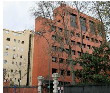
Ampliación de la Sede principal de Bankinter, Paseo de la Castellana, Madrid (1972-1976) * junto con Ramón Bescós
