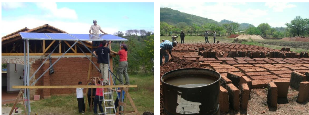
Figura 18: Proceso de construcción del restaurante La Casita Solar.
