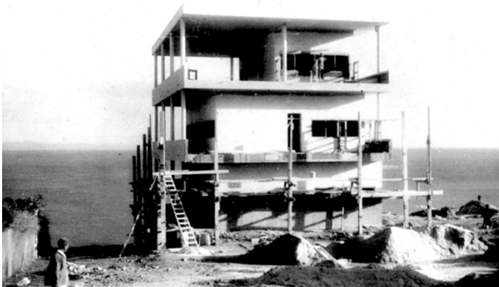
Villa Baizeau en construcción 1929
