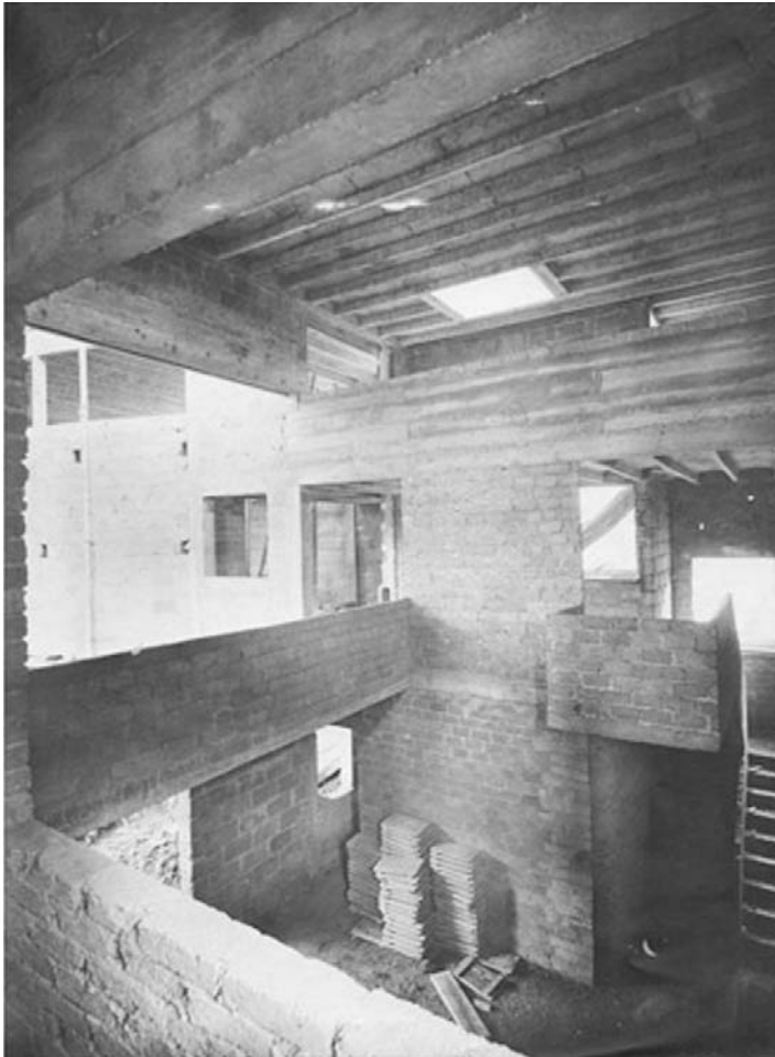
Fotografía FLC. Maison La Roche en construcción. La materialidad del espacio.
