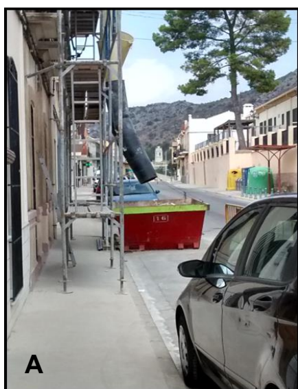
Imagen 5.425. Obras sin proteger y sin camino alternativo. Imagen A obra sin proteger y sin señalar camino alternativo. Imagen B obra con protección incorrecta y sin señalar camino peatonal alternativo. Fuente: imagen propia.
