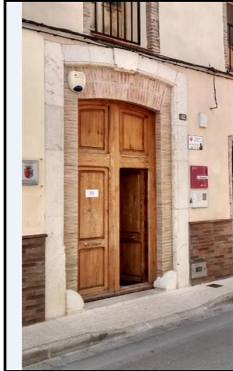
Imagen 5.12. Vista del.C/Major en Ràfol d'Almúnia. Vado mal ejecutado que modifica pendiente transversal de la acera. Fuente: imagen propia.
