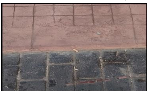
Imagen 5.14. Pavimento de hormigón impreso de diversos colores y dibujos. Presenta como ventaja la facilidad de ejecución. Antideslizante en seco y en mojado, Su resistencia al desgaste es menor a la de otros pavimentos. Fuente: imagen propia.
