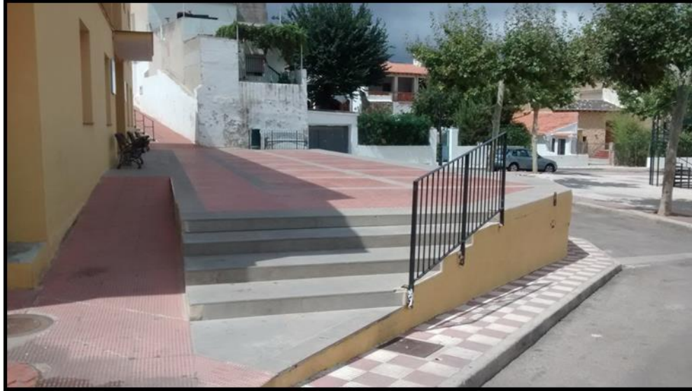
Imagen 5.301. Rampa que acompaña a la escalera con pendiente del 8% y pavimento abotonado en toda su superficie. Fuente: imagen propia.
