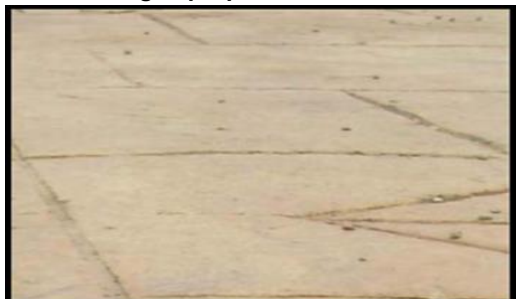
Imagen 5.14. Pavimento de hormigón impreso de diversos colores y dibujos. Presenta como ventaja la facilidad de ejecución. Antideslizante en seco y en mojado, Su resistencia al desgaste es menor a la de otros pavimentos. Fuente: imagen propia.
