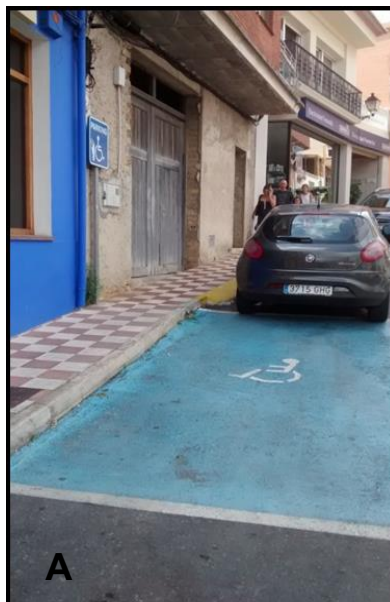
Imagen 5.414. Plaza reservada con señalización vertical pero sin vado que permita acceder a la acera. Además la plaza de la imagen B se halla situada en pendiente. Fuente: imagen propia.
