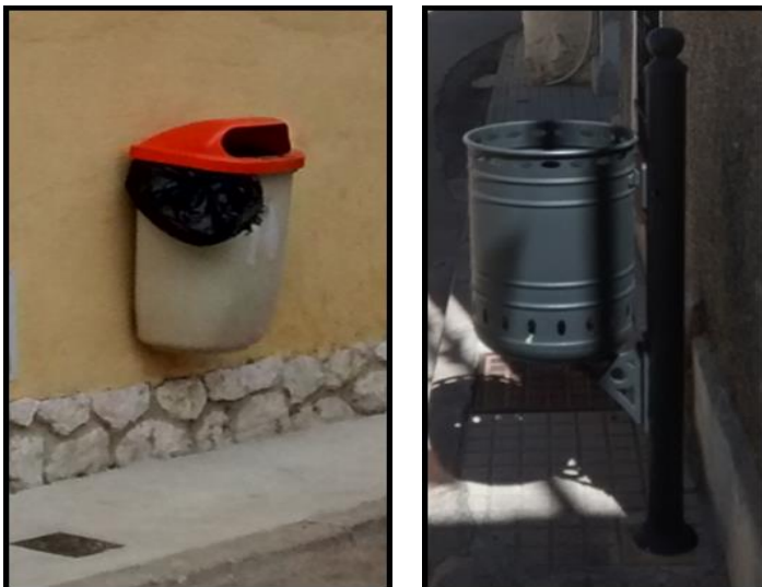
Imagen 5.335. Papeleras que no presentan proyección vertical hasta el suelo haciéndolas indetectables por el bastón de las personas invidentes. Fuente: imagen propia.
