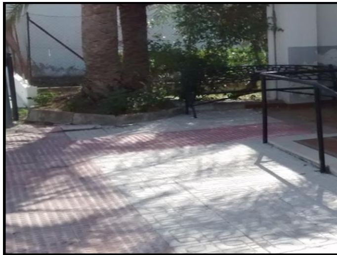
Imagen 5.17. Inadecuada utilización del pavimento señalizador en Adsúbia. Fuente imagen propia.
