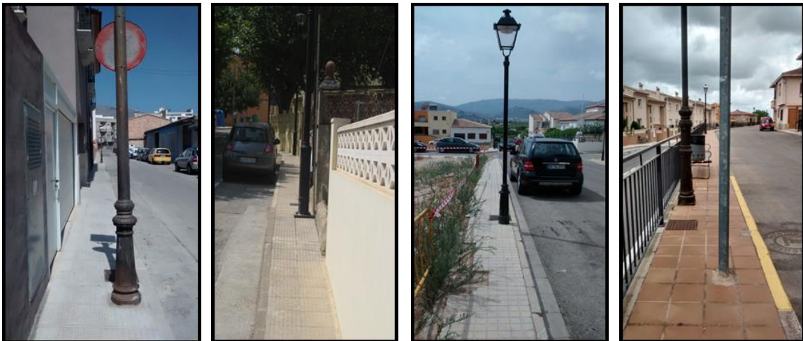
Imagen 5.32. Inadecuada ubicación de farolas reduce el ancho libre de paso a 30 cm. Fuente imagen propia.
