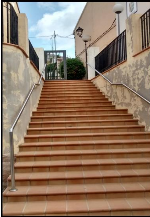
Imagen 5.256. Escaleras con huella inferior a 30 cm pavimento deslizante en mojado y ausencia de segundo pasamanos a altura 70-75 cm. Así como un número de escalones seguidos superior a 10. Fuente: imagen propia.
