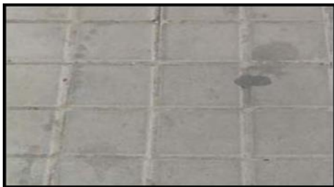
Imagen 5.13. Pavimento de baldosas hidráulicas. Presentan una dureza y compactación adecuadas. Antideslizantes en seco y en mojado. Fuente: imagen propia
