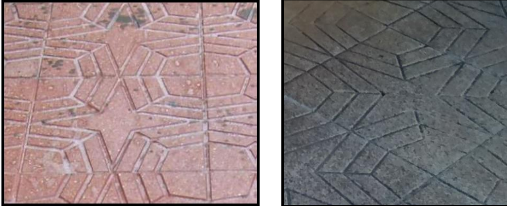
Imagen 5.13. Pavimento de baldosas prefabricadas. Resistentes al desgaste pero deslizantes en mojado. Fuente: imagen propia
