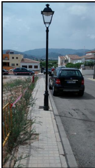
Imagen 5.4. Vista de la C/ Segària en Benimeli. Fuente: imagen propia.
