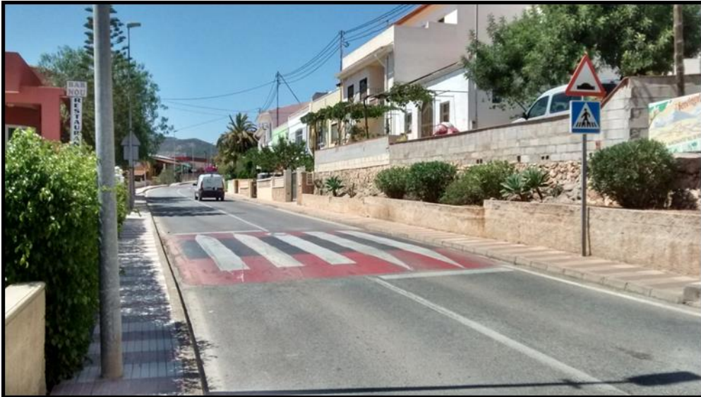
Imagen 5.9. Vista de la Avd. La constitución en Senija donde se observa la inadecuada ubicación de la farola. Fuente: imagen propia.
