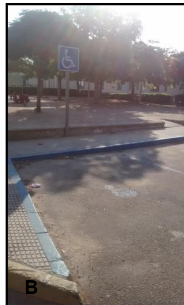
Imagen 5.414. Plaza reservada con señalización vertical pero sin vado que permita acceder a la acera. Además la plaza de la imagen B se halla situada en pendiente. Fuente: imagen propia.
