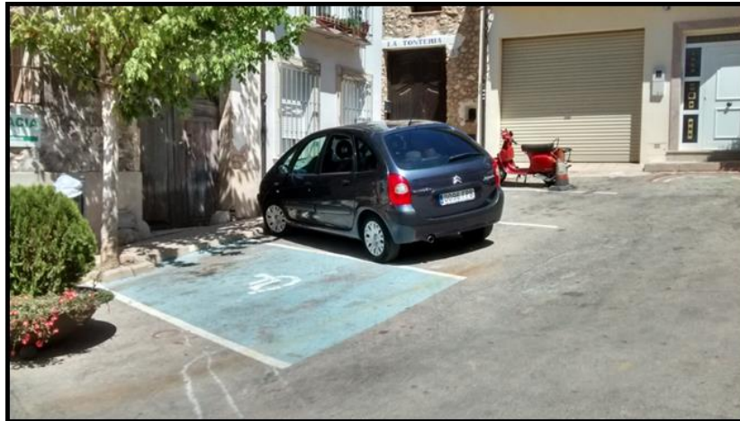
Imagen 5.403. Plaza reservada sin vado y señalización vertical. Fuente: imagen propia.
