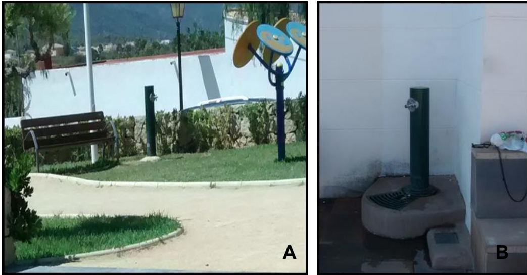
Imagen 5.458. Imágenes de fuentes con ubicación y tipo de chorro inadecuado. Estas fuentes no permite la aproximación de usuarios con silla de ruedas además al ser el chorro de agua del tipo de caída de agua descendente provoca que el usuario se moje. Fuente: imagen propia
