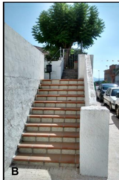
Imagen 5.267. Escalera con pavimento deslizante en mojado y ausencia de pasamanos. Ausencia de segundo pasamanos a altura 70-75 cm en escalera de la izquierda y el pasamano existente no cumple con la normativa en cuanto a diámetro. No existe pavimento señalizador en el embarque y desembarque de las escaleras. Fuente: imagen propia
