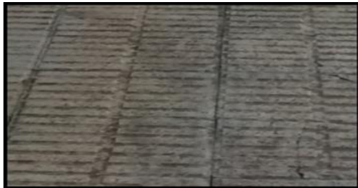
Imagen 5.13. Pavimento de baldosas hidráulicas. Presentan una dureza y compactación adecuadas. Antideslizantes en seco y en mojado. Fuente: imagen propia
