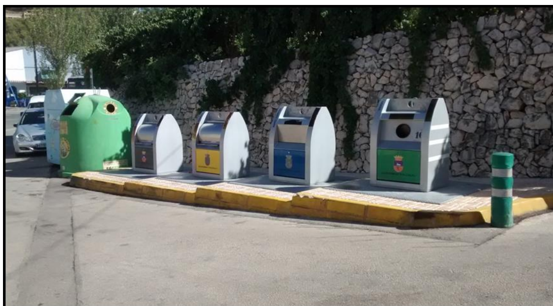
Imagen 5.379. La inadecuada ubicación de estos contenedores accesibles, los convierte en inaccesibles para usuarios en silla de ruedas al no poder llegar desde la acera. Fuente: imagen propia.
