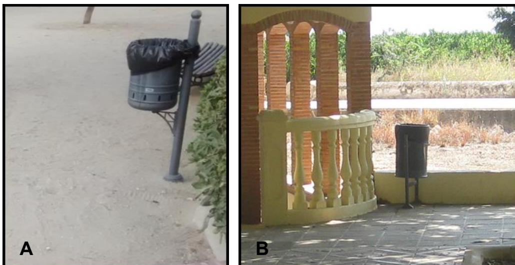
Imagen 5.50. Papeleras que incumplen algún parámetro de accesibilidad. La papelerera de la imagen A no es detectable por el bastón al no estar proyectada hasta el suelo y la de la imagen B presenta peligro de vuelco. Fuente: imagen propia.
