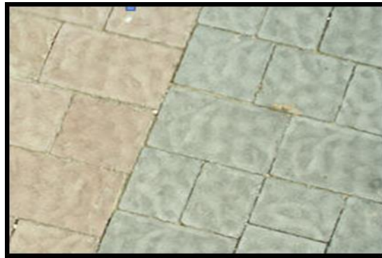
Imagen 5.14. Baldosas de hormigón. Resistentes al desgaste. Presentan una dureza y compactación adecuada y son antideslizantes en seco y en mojado. Fuente: imagen propia
