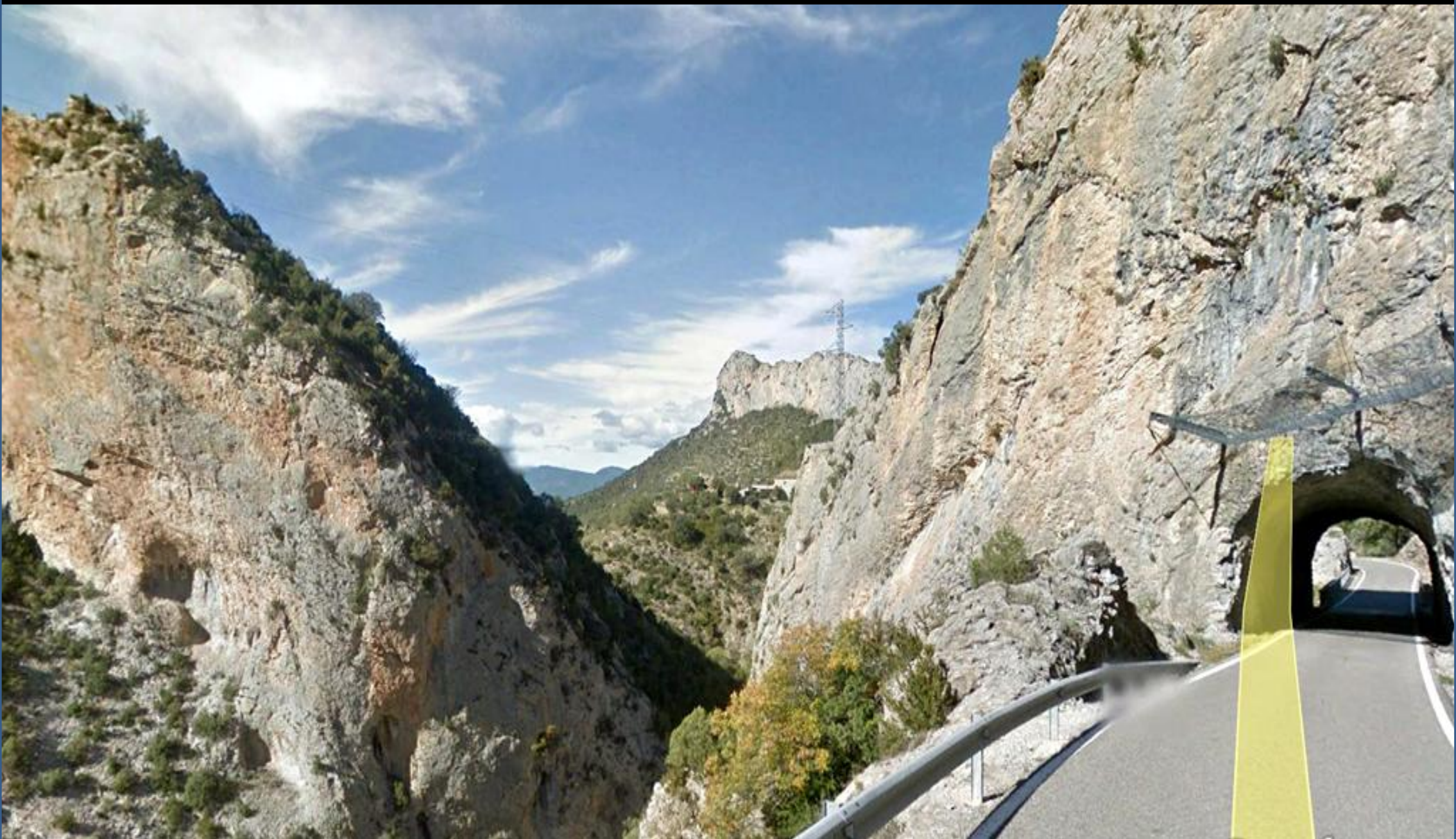
Túnel sin revestimiento en las calizas Mesozoicas de Perles, y protección a su salida frente a caídas de bloques. E de Coll de Nargó, Lérida. SE Hoja de Orgañá.
