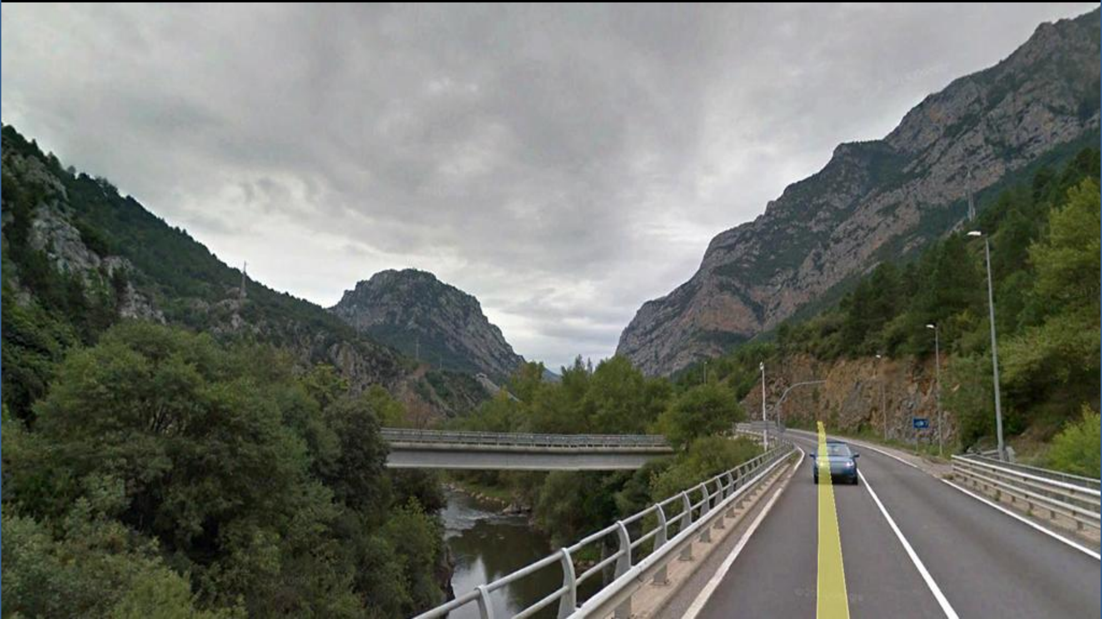
Mismo sitio que la anterior: Valle del Río Segre hacia el S. Relieves carbonatados del Cretácico Inf. Ribera d'Urgellet, Llérida. Centro E Hoja de Orduña.
