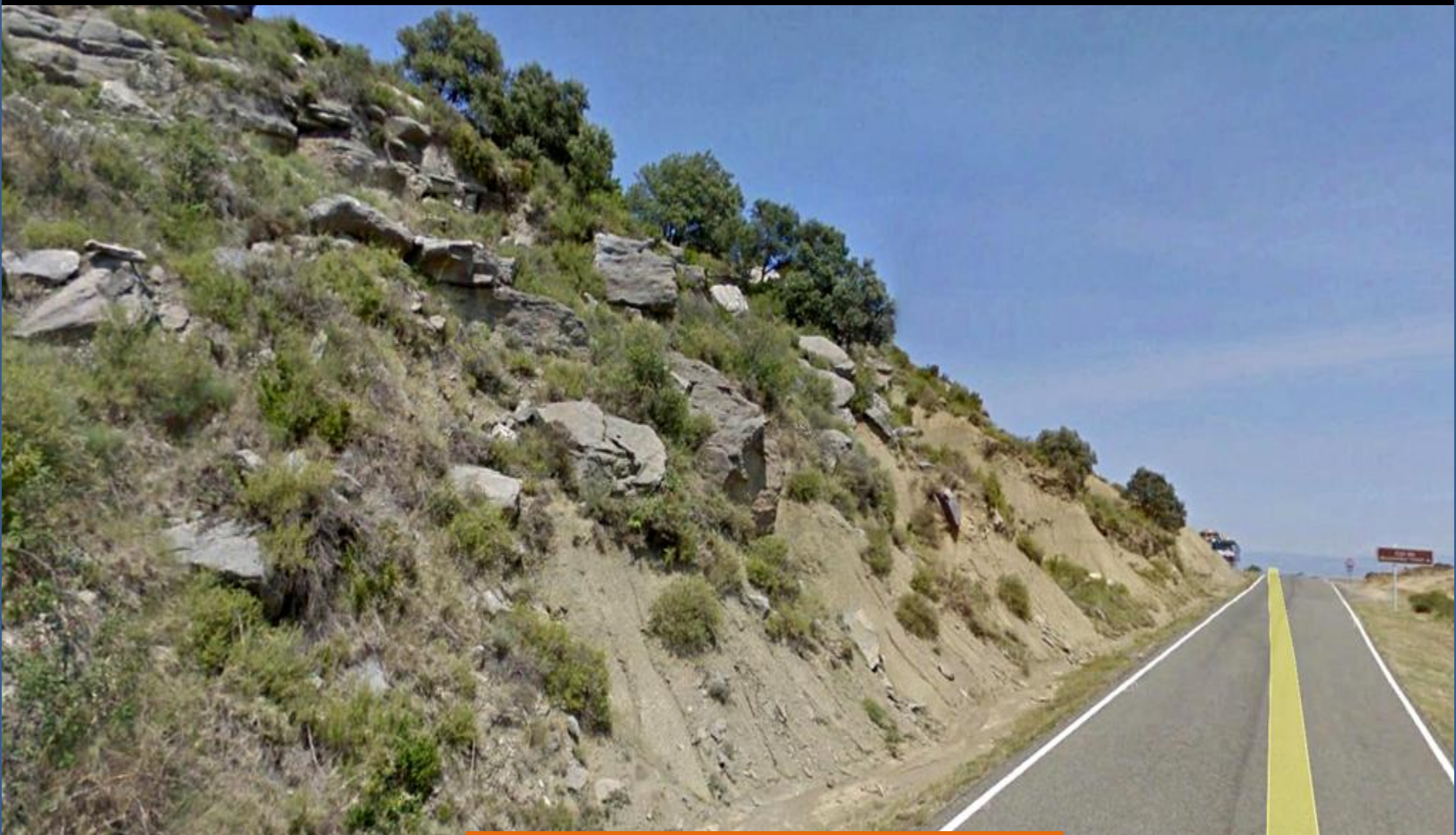
Inestabilidad de ladera en las pelitas y margas del Eoceno Inf. Paleógeno, Terciario. Coll de Montllobar, W de Figols, Lérida. NE Hoja de Benabarre.
