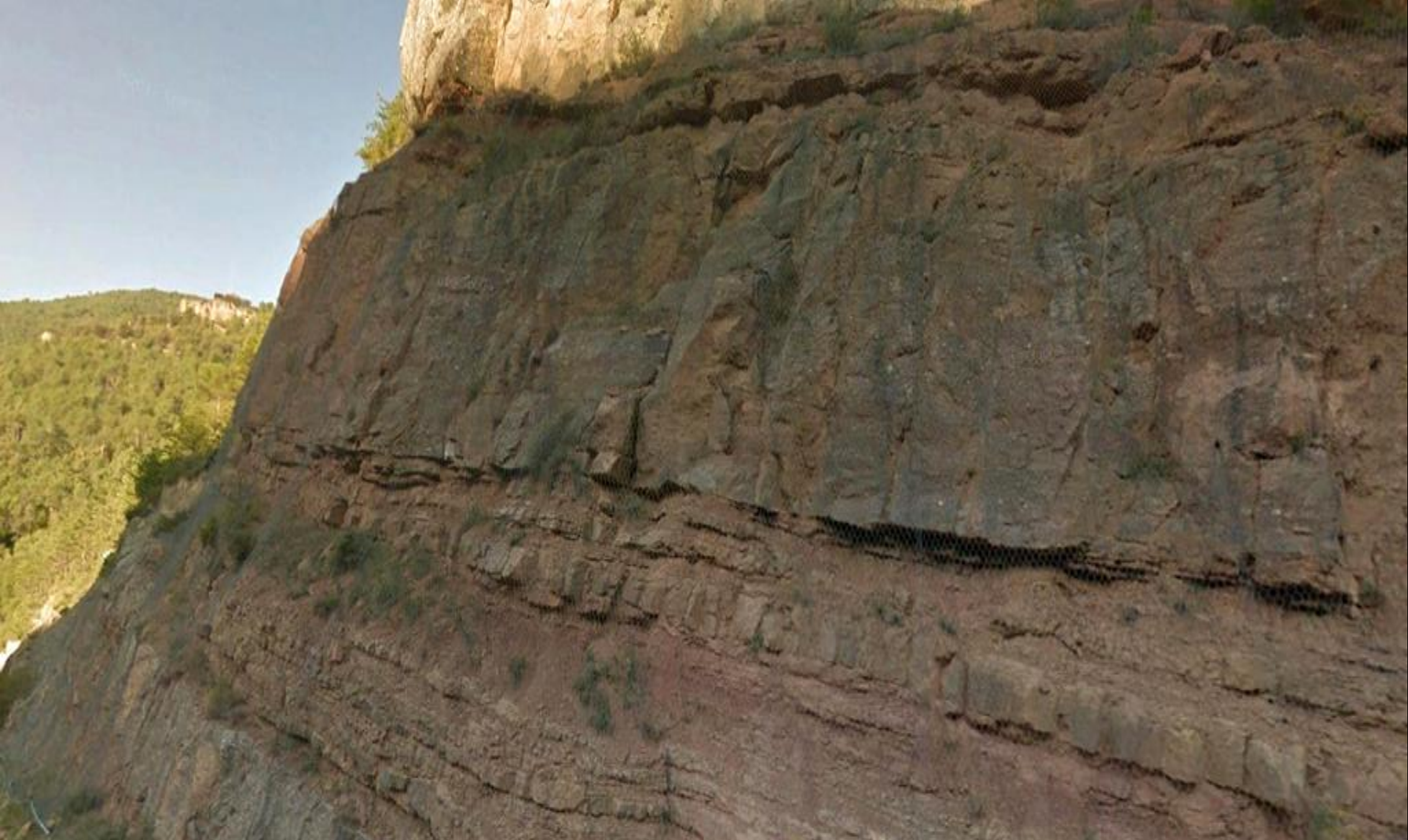
Talud de areniscas y arcillas del Paleógeno, Terciario, con mallazo. Talud de areniscas y arcillas del Paleógeno, Terciario, con mallazo. S de San Andreu del Cavall, Lérida. SE Hoja de San Lorenzo de Moruny.
