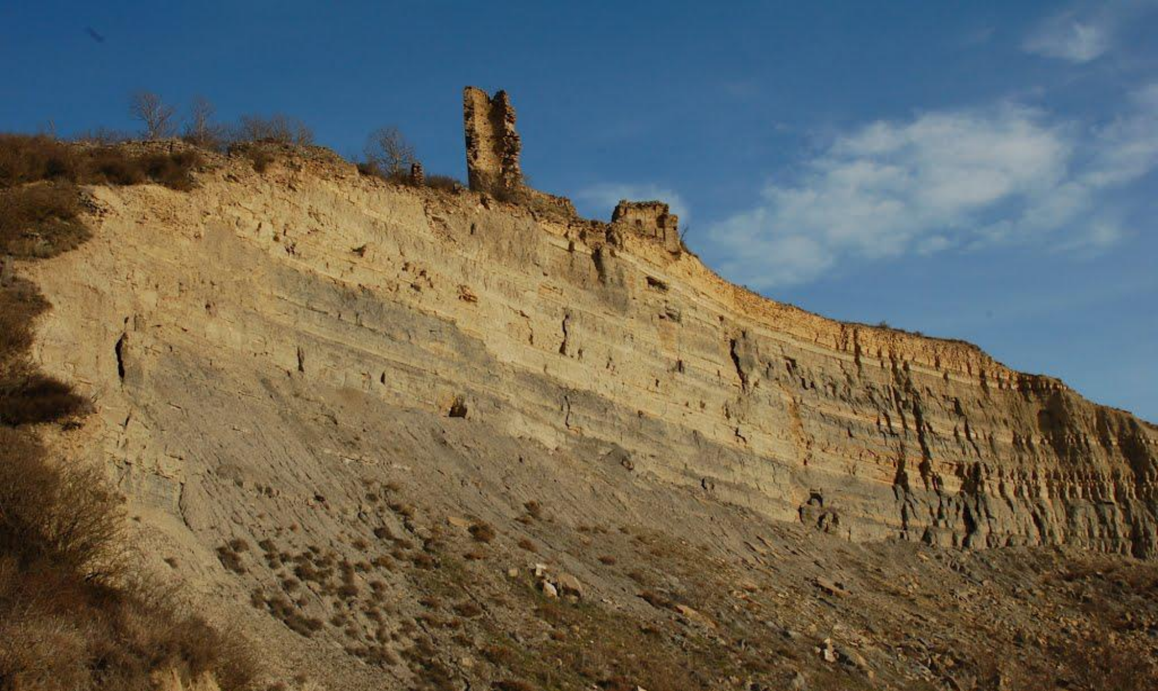
Desprendimiento de pelitas y areniscas deltaicas del Eoceno Inf. Terciario. W de Puigercós, Lérida. NW Hoja de Isona. (por Mussaranya-Google)
