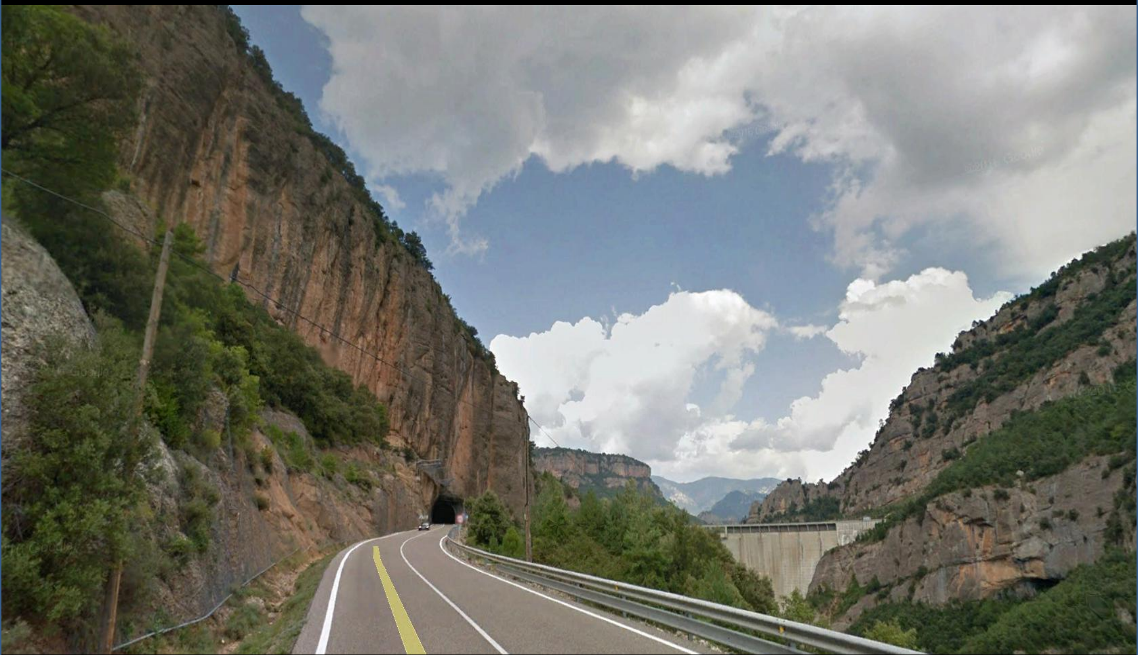
Túnel y estribo izq., de la cerrada del Embalse de La Llosa del Caball. (Solsona), Ríó Cardener. Mallazo en las capas de areniscas y algunos conglomerados. Calizas del Parisiense, Terciario. Centro W Hoja de San Lorenzo de Moruny.
