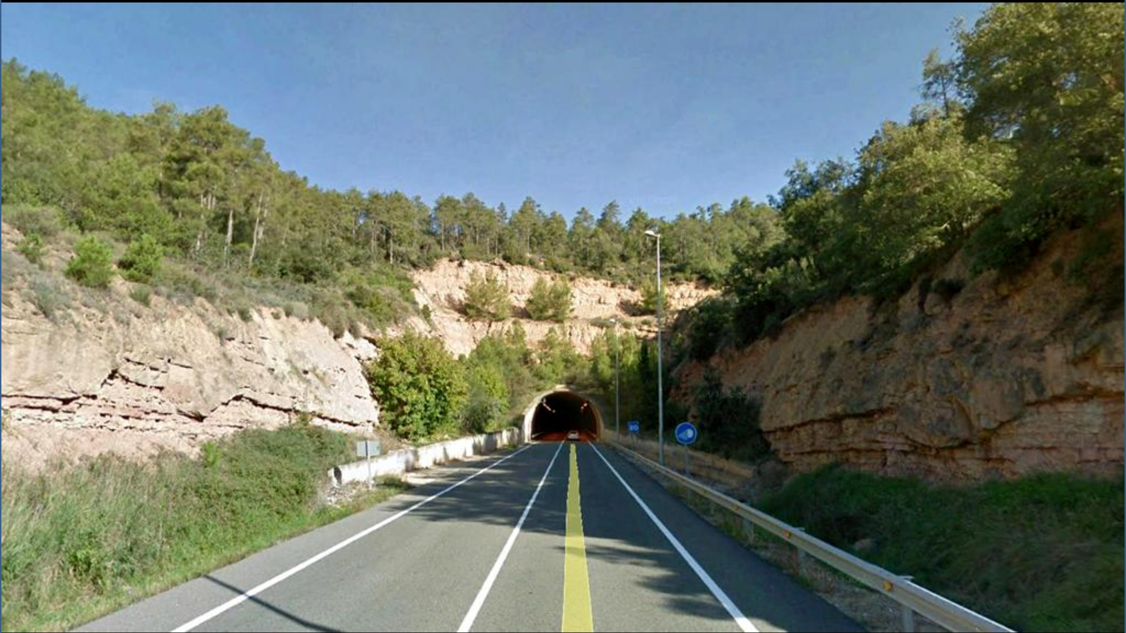
Túnel en terrenos areniscosos, limosos, del Stampiense, Oligoceno, Terciario. S de Basella, Lérida. N Centro Hoja de Pons.
