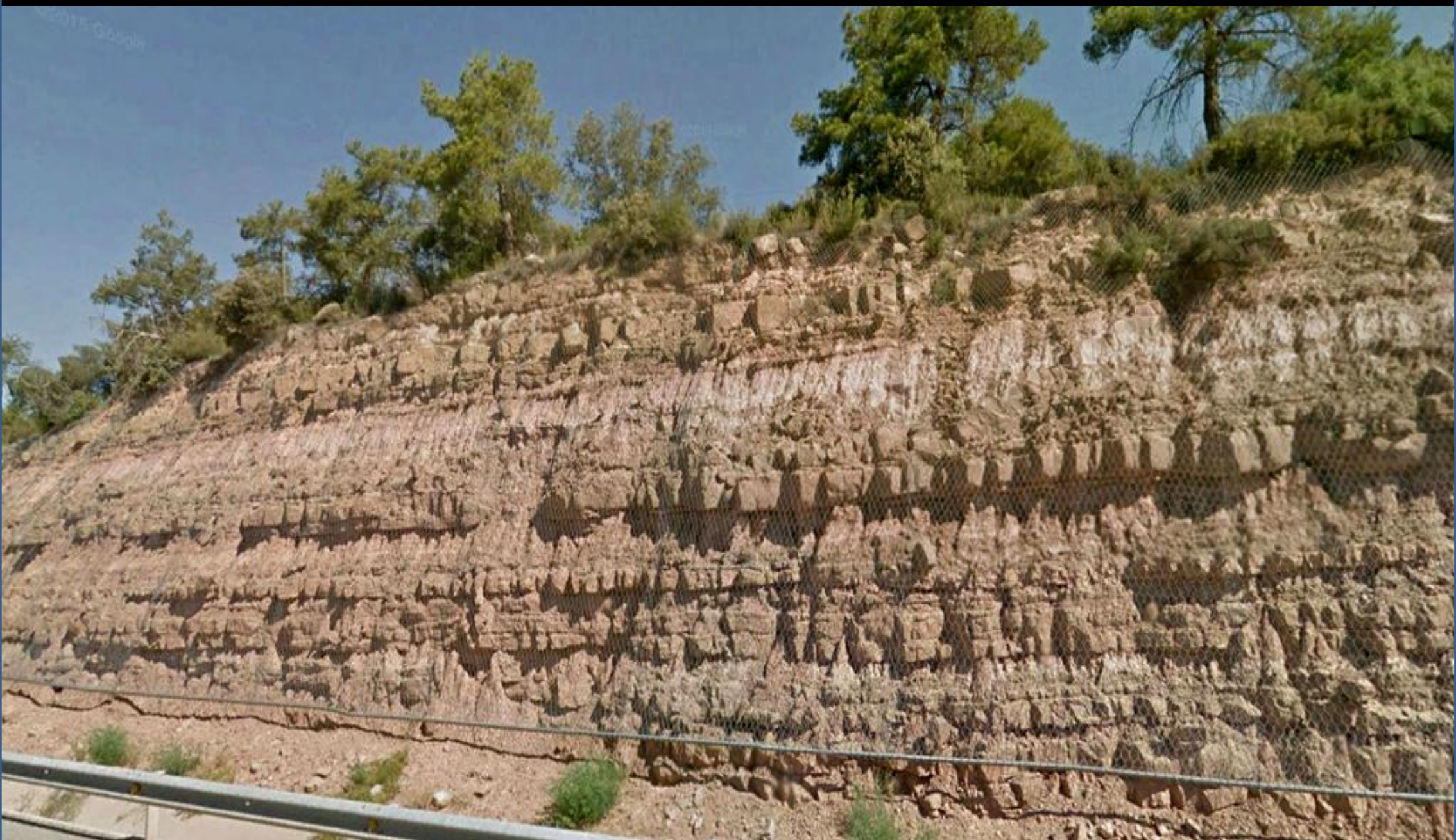
Mallazo en talud de areniscas y limolitas del Stampiense, Oligoceno, Terciario. E de Sanahuja, Lérida. SE Hoja de Pons.
