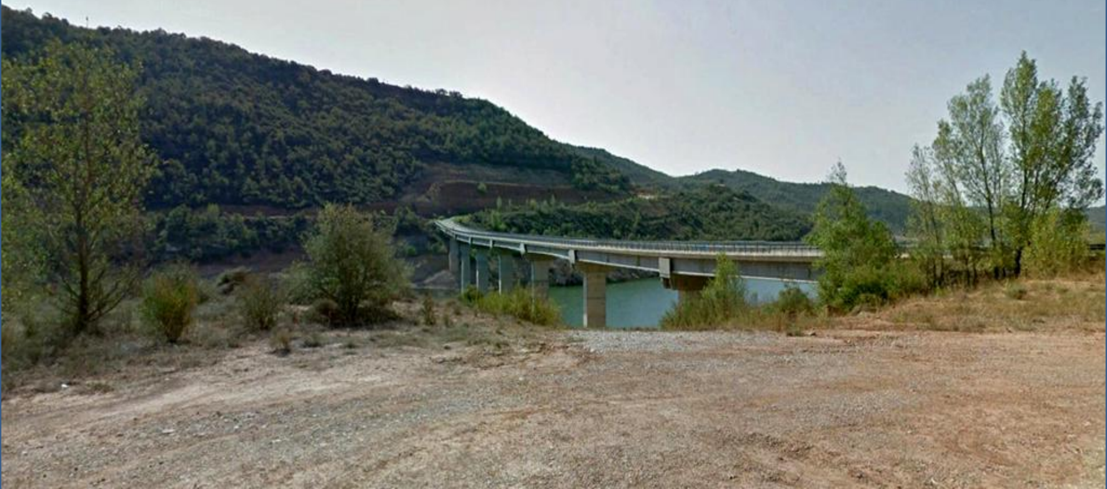
Puente sobre un brazo del Embalse de Rialb, en terrenos areniscosos, limosos, del Stampiense, Oligoceno, Terciario. NW de Tiurana, Lérida. NW Hoja de Pons.
