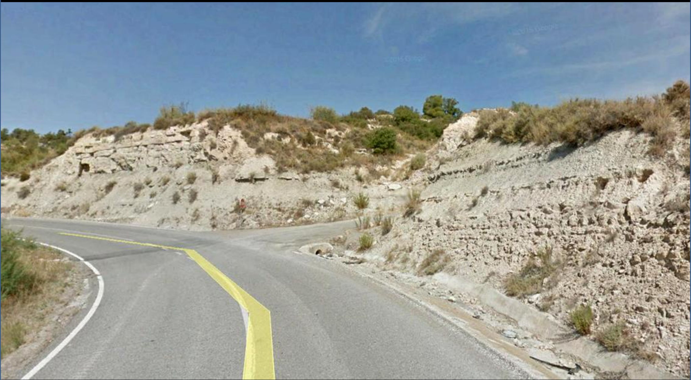
Margas con filoncillos de yeso y areniscas, y niveles calizos. Estampiense, Oligoceno, Terciario. N de Espluga Calva, Lérida. N Centro Hoja de Espluga de Francolí.
