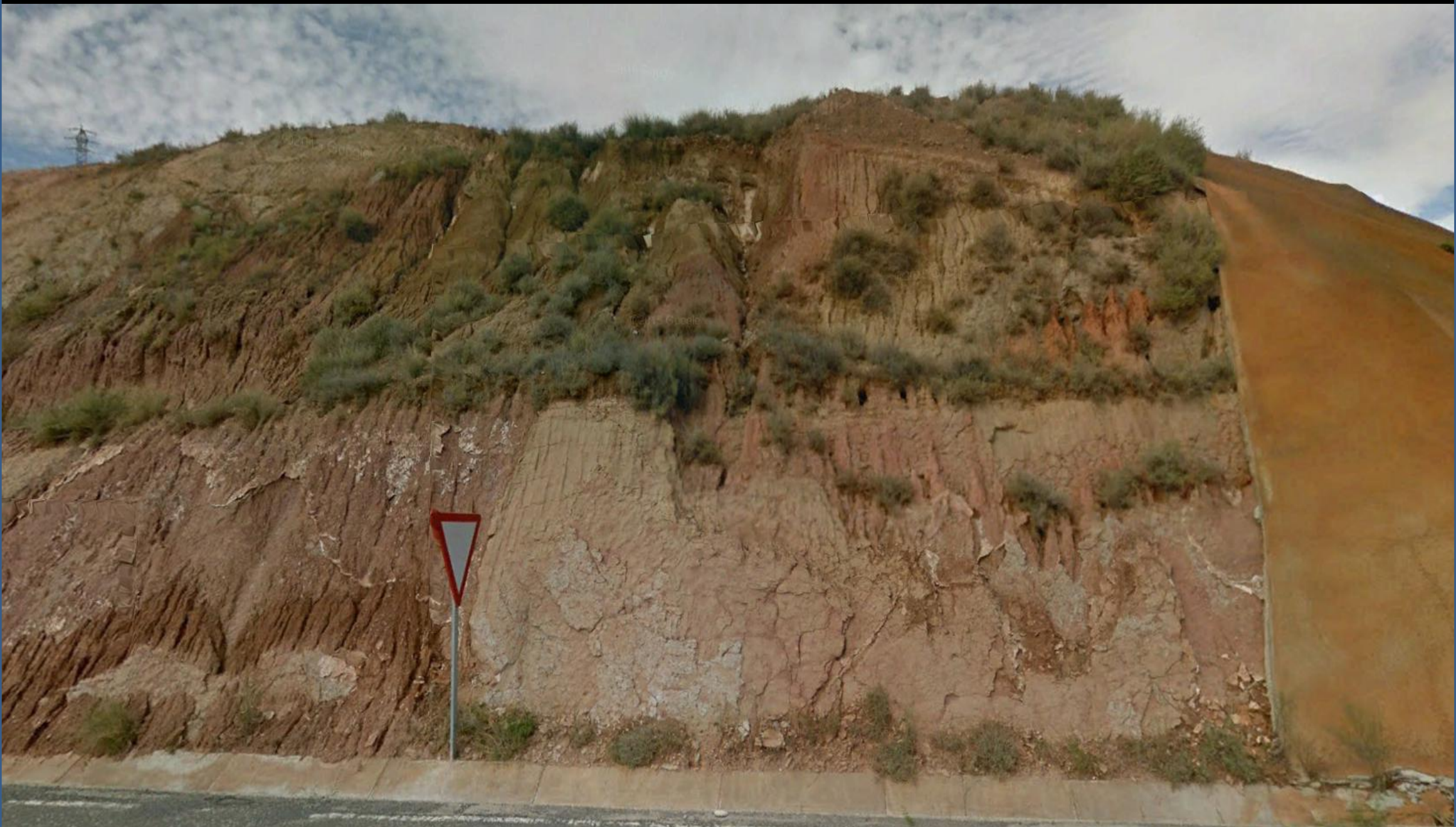
Gunitado ocre sobre los limos y las arcillas rojizas del Chattiense, Oligoceno Sup. Terciario. E de Alfarrás, Lérida. NW Hoja de Balaguer.
