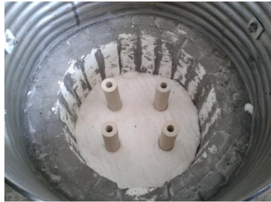
Imagen 14. Revestimiento con ladrillo
