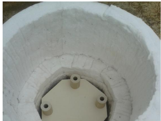
Imagen 16. Colocación fibra refractaria
