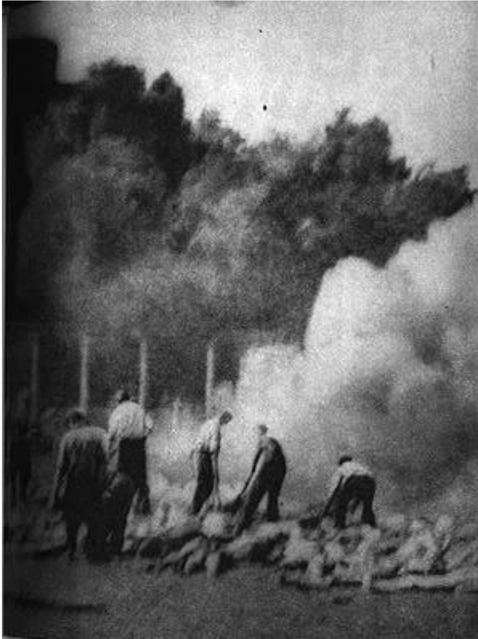
Corte ampliado foto 2
