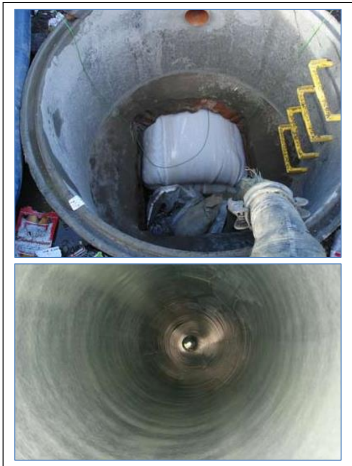
Figura 9.2.2.- Mantenimiento/Rehabilitación: Re-entubado
