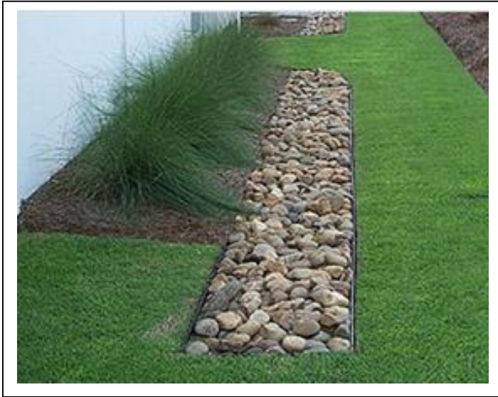
Figura 9.1.7.-TDDS: Zanja de infiltración
