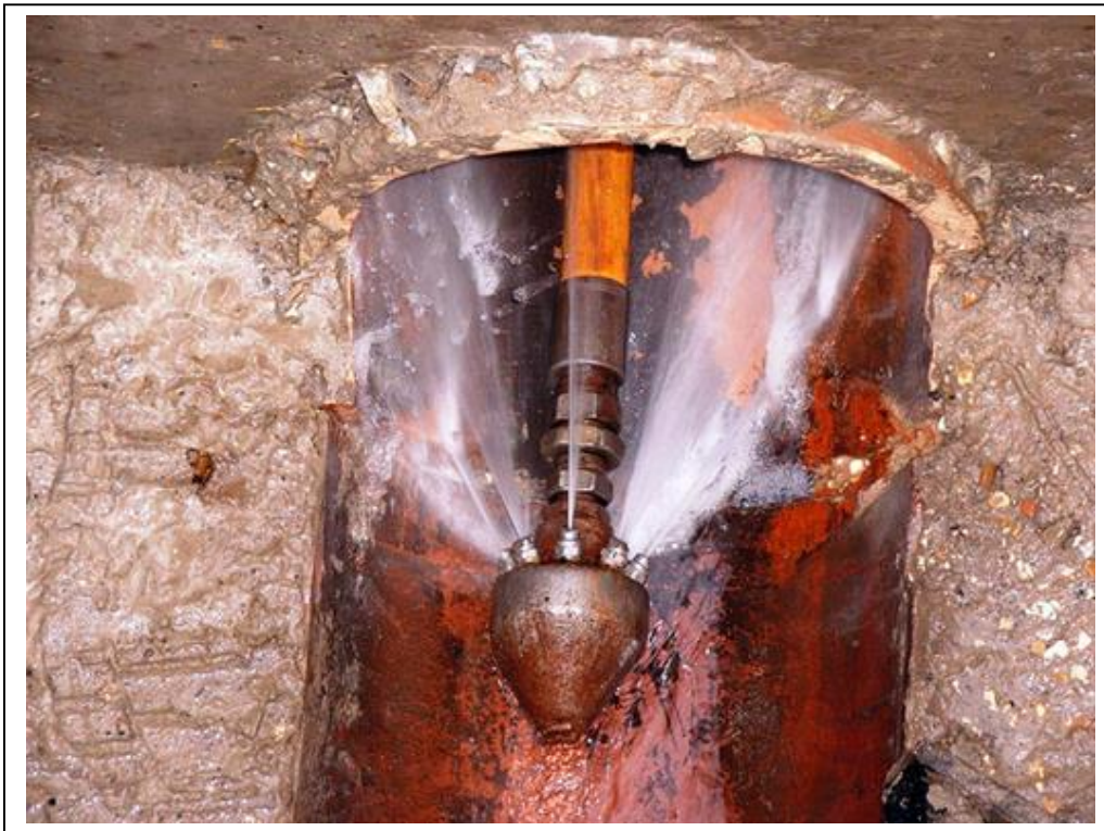
Figura 9.2.3.- Mantenimiento/Rehabilitación: “Jetting”
