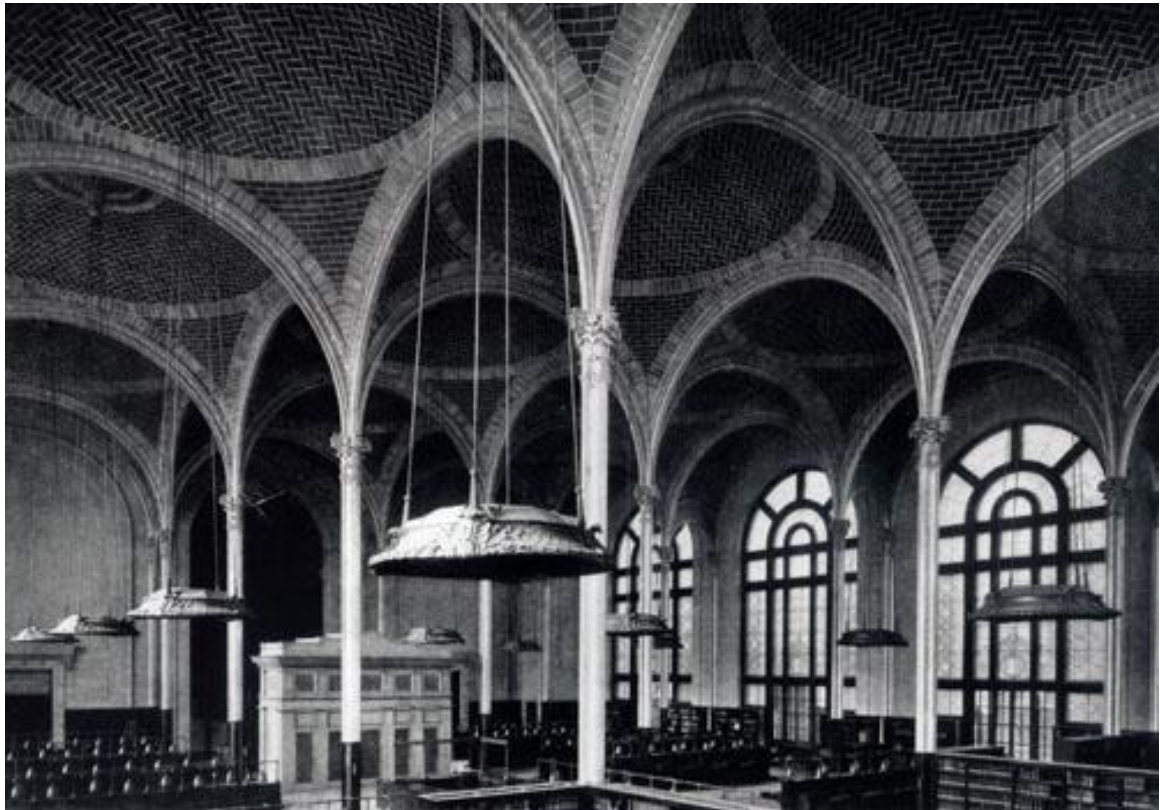
Biblioteca Pública de Albany, New York, USA (1908-1911). Realizada con el sistema de bóvedas de ladrillo plano patentado por Rafael Guastavino. Fuente: Garcia-Gutierrez Mosteiro, J. (2002). "Implantación y aventura de las bóvedas de Guastavino en América", en Revista Menhir-Arquitectura, Construcción y Diseño. 2002, Nº5. Bilbao. Ed. Company.
