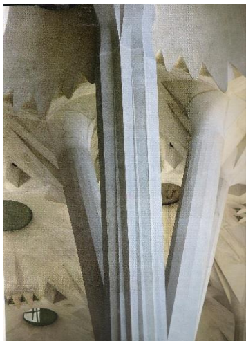
Estructura arboriforme de una columna. Fuente: Josep Gomez Serrano y AAVV (2008 ) Gaudí ara: la Sagrada Familia siglo XXI . Barcelona. Edicions UPC.
