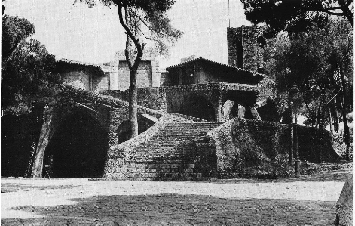
Visión frontal de la iglesia (Cripta) de Santa Coloma. Fuente: Puig Boada (1976) L'Esglesia de la Colonia Güell . Barcelona. Ed. Lumen.
