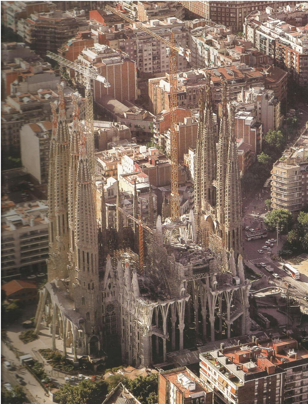
Vista general de la Sagrada Familia donde puede apreciarse la sección transversal de la Estructura de las naves. Fuente: Gómez Serrano, J. y AA.VV. (2008) Sagrada Familia XXI/ Gaudí ara. Barcelona. Edicions UPC.
