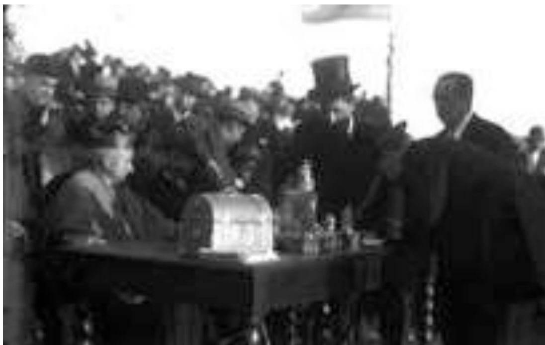
Fig.6.157.- Imagen del Acto de Colocación de la Primera Piedra de las Casas Baratas. 1929. AGRMA. Archivo Casáu AC-062-002554.
