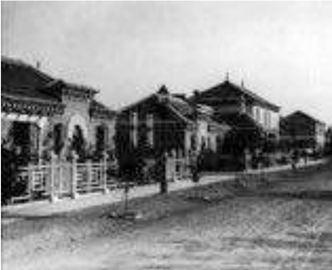
Fig. 2.30.- Arquitectura regionalista en la Ciudad Jardín de Málaga. Sdad. Anónima de Casas Baratas de Málaga. 1924-1928. AHPM. Fondo Casas Baratas. En Reinoso Bellido (2010, p.452)
