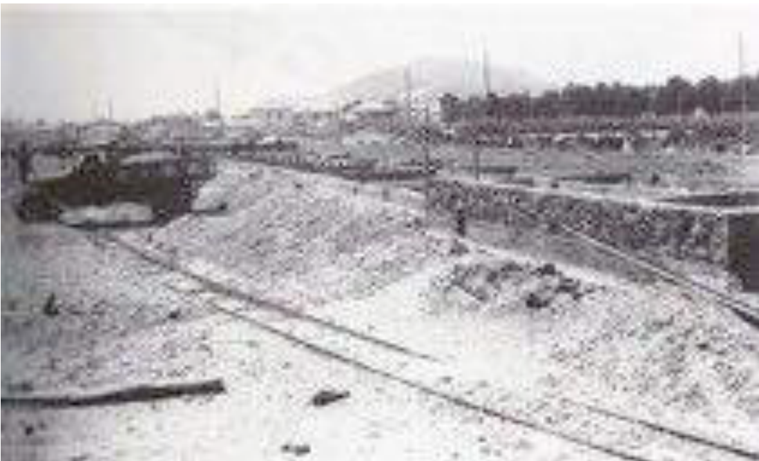
Fig.6.142.- Fábricas de mampostería sobre muretes de hormigón. Se aprecian las vías que conectaban la obra con las canteras. Diario Cartago-Nova 1 de abril de 1930.
