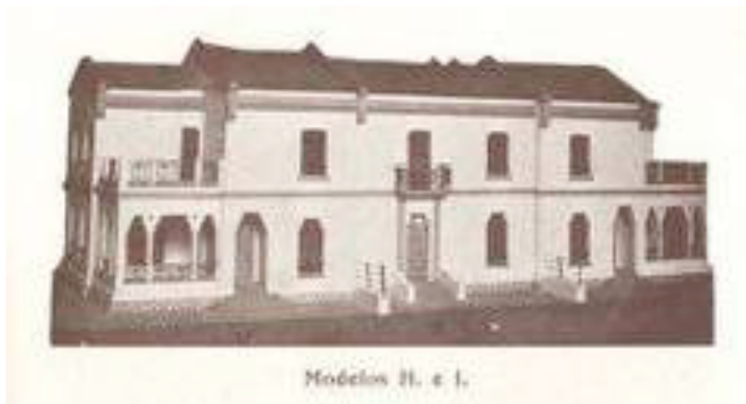
Fig.6.94.- “Fotografía Maqueta Modelos H e I ”. Folleto de venta. Construcciones Inmobiliarias Barcelona 1929. ACMF CB 171/1.
