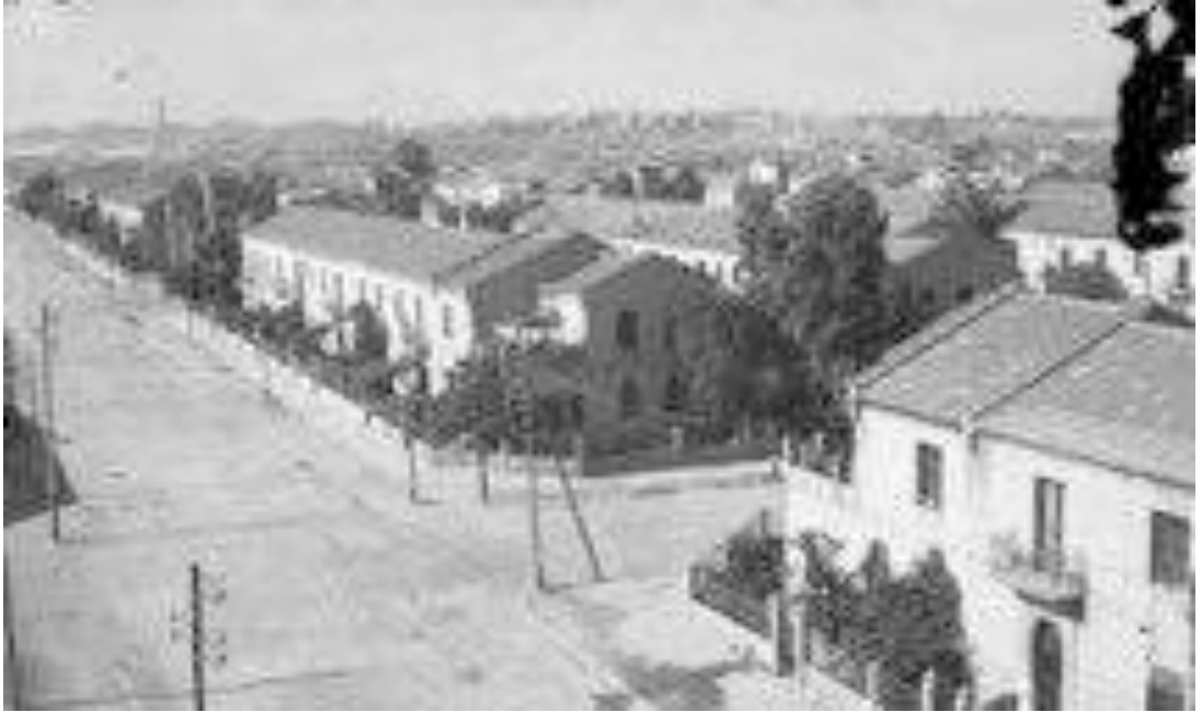
Fig.6.168.- Vista con la barriada ya habitada. AGRM. Archivo Casaú. AC-090-008409.
