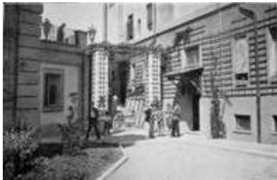
Fig.8.7.- Acceso a espacios interiores. Grupo Appio. (Calza Bini 1927)
