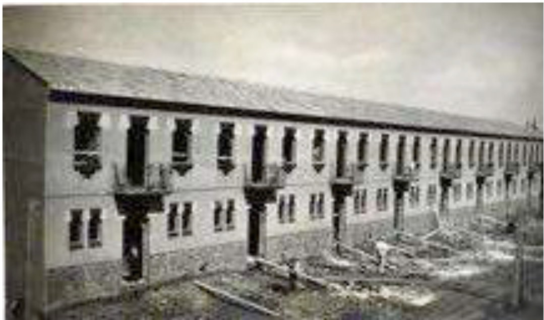
Fig.6.127.- Vista de una secuencia de 8 tipos 'C' en construcción, manzana 21. 1931. ACMF CB 171/1.
