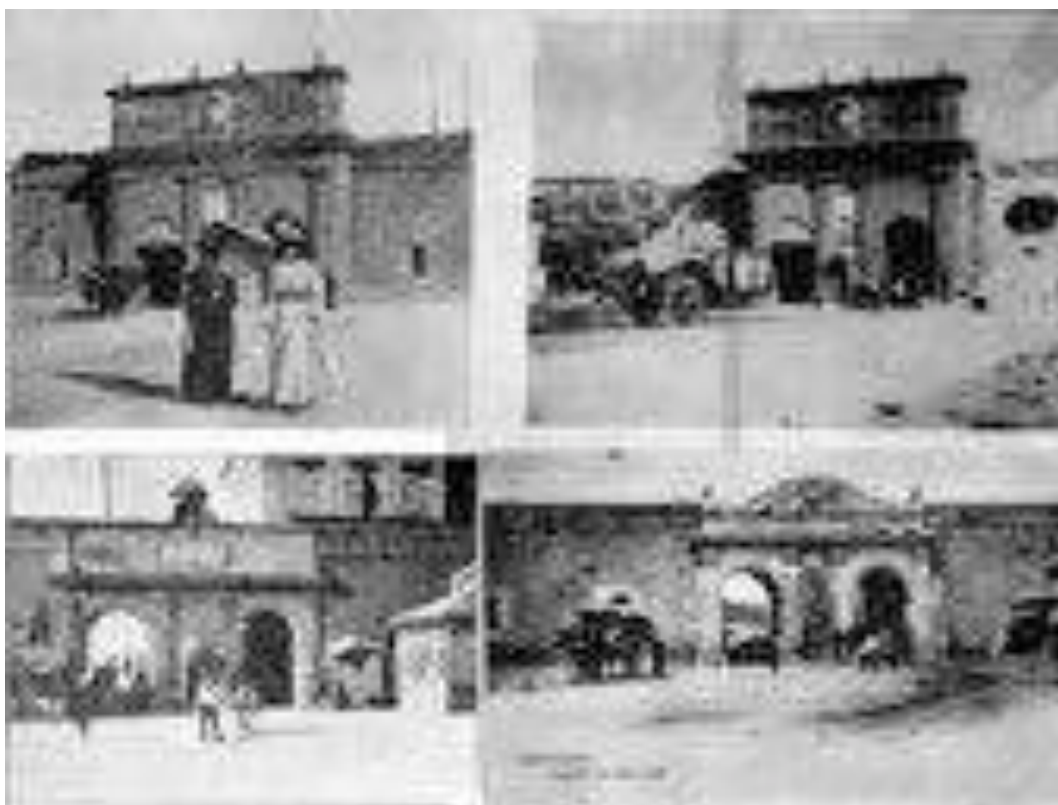
Fig.- 3.27.- Arriba: Puertas de Madrid, antes y durante su demolición; abajo izquierda: Puerta del Muelle; abajo derecha: Puerta de San José. AGRM. AC-085-006375; AC-085-006442; AC-089-008299; AC-085-006180.
