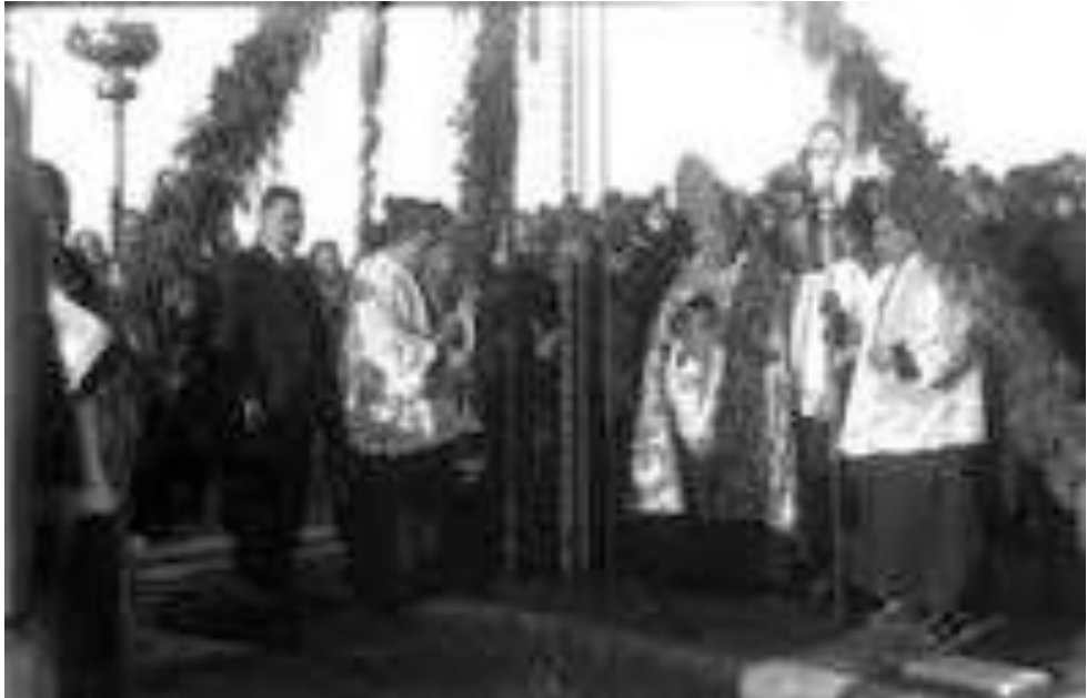
Fig.6.160.- Imagen del Acto de Colocación de la Primera Piedra de las Casas Baratas. Bendición. 1929. AGRMA. Archivo Casaú AC-038-001565.
