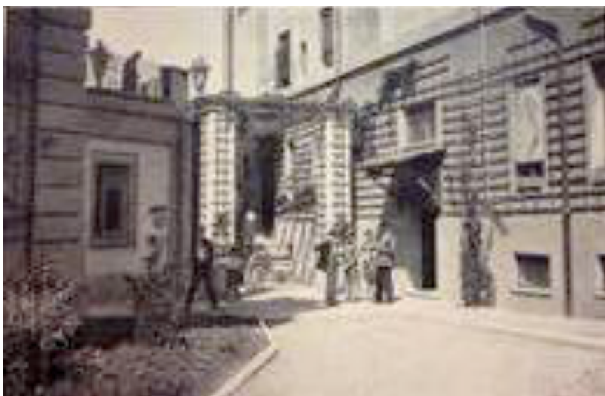
Fig.8.7.- Acceso a cortile interno. Gruppo Appio. (Calza Bini 1927)
