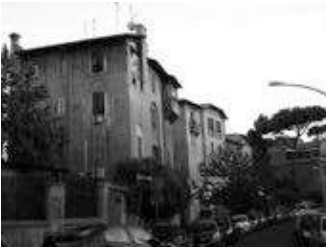
Fig.8.27.- Borgata giardino Garbatella. Foto del autor. 2014.
