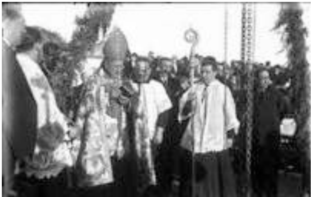
Fig.6.161.- Imagen del Acto de Colocación de la Primera Piedra de las Casas Baratas. Bendición. 1929. AGRMA. Archivo Casaú AC-024-000996.
