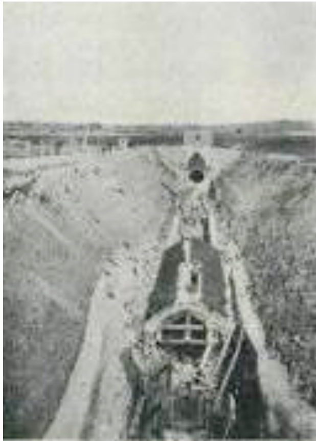
Fig.6.94.- Obras de desagüe y saneamiento del fondo del Almarjal de Cartagena. Foto Marín. AMC Hemeroteca. Diario 'Cartago-Nova'. 1 de abril de 1928.
