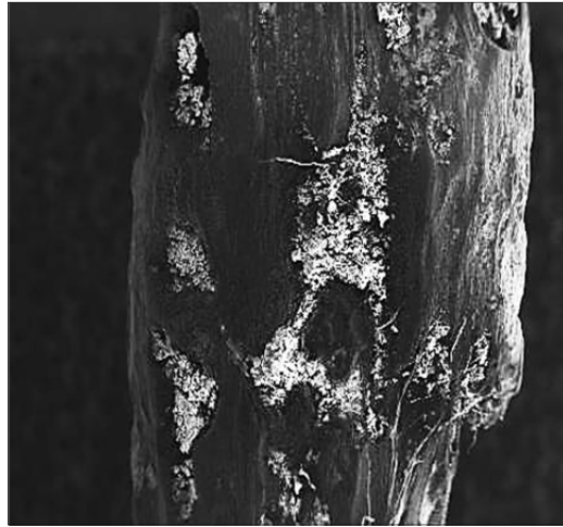
Fig. 7.19. Armadura de la vigueta mostrando corrosión por picaduras, observado mediante SEM de 20 aumentos
