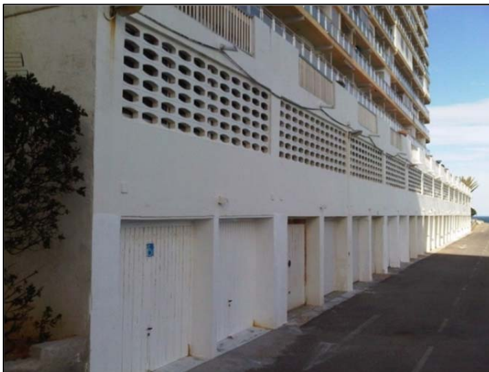
Fig. 7.8. Imagen de la fachada en la zona del edificio donde se realiza el trabajo
