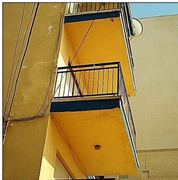
Fig. 4.9. Detalle de frente de terraza donde con ausencia goterón en la localidad de Oropesa del Mar
