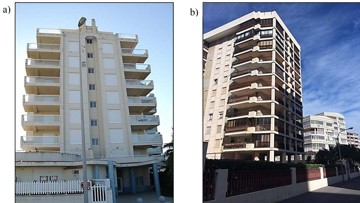
Fig. 4.8. Fachadas de edificios de segunda residencia a) Terminación de la fachada en monocapa, en un edificio ubicado en la población de Xeraco y b) Edificio con estructura en fachada en la localidad de Benicassim
