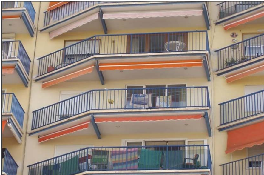
Fig. 4.4. Edificio con forjados a base de vigas metálicas en la población de Oropesa del Mar
