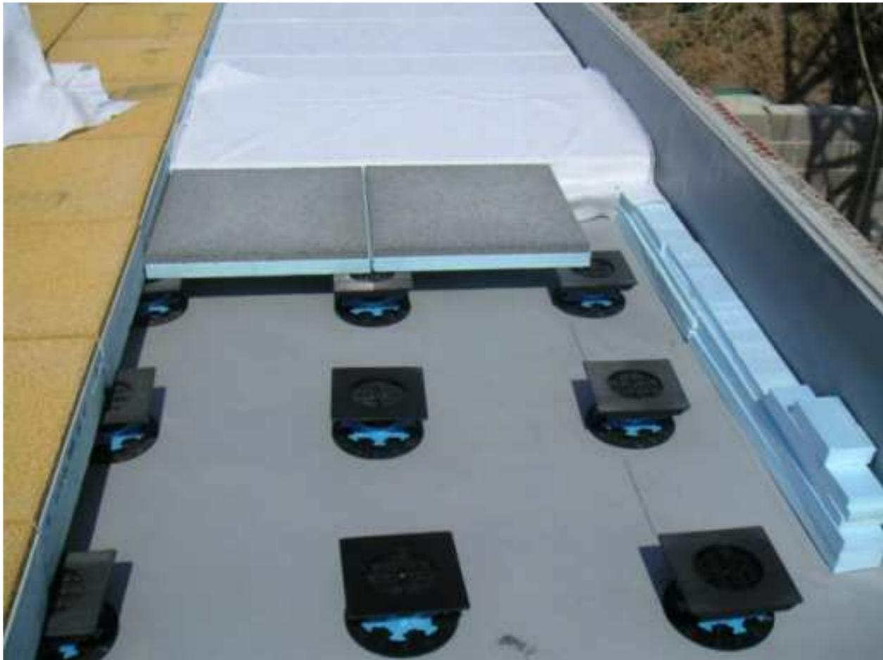
Se trata también de una cubierta invertida, construida con una membrana impermeabilizante a modo de barrera de vapor, formación de pendientes con hormigón celular, impermeabilización aislamiento térmico y colado apoyado sobre plots plásticos que le dan la horizontabilidad necesaria, el aislamiento puede estar incluido en cada pieza o por debajo de los soportes.
